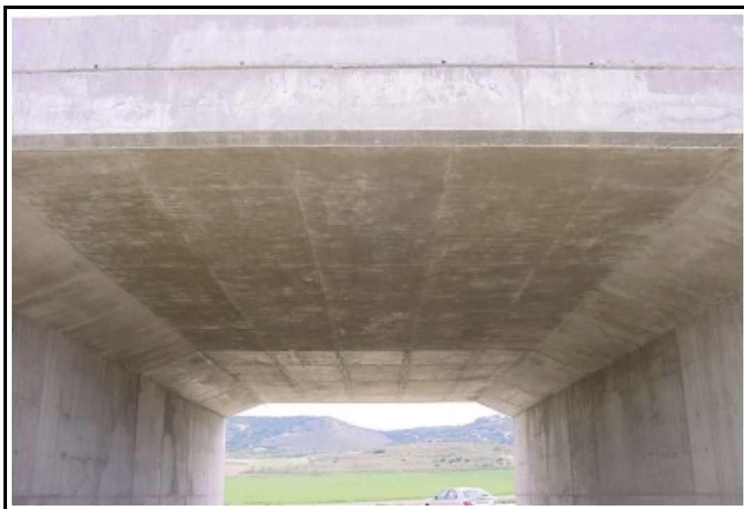
Foto 4: Vista inferior de la estructura
