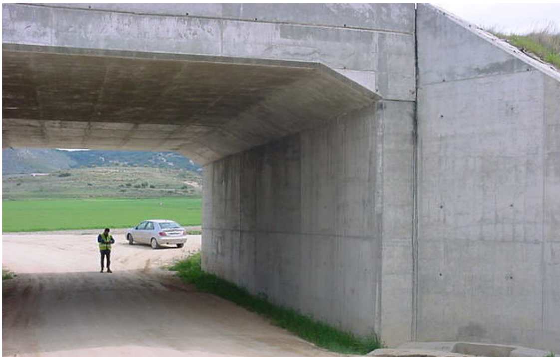
Foto3: Estribo de entrada
