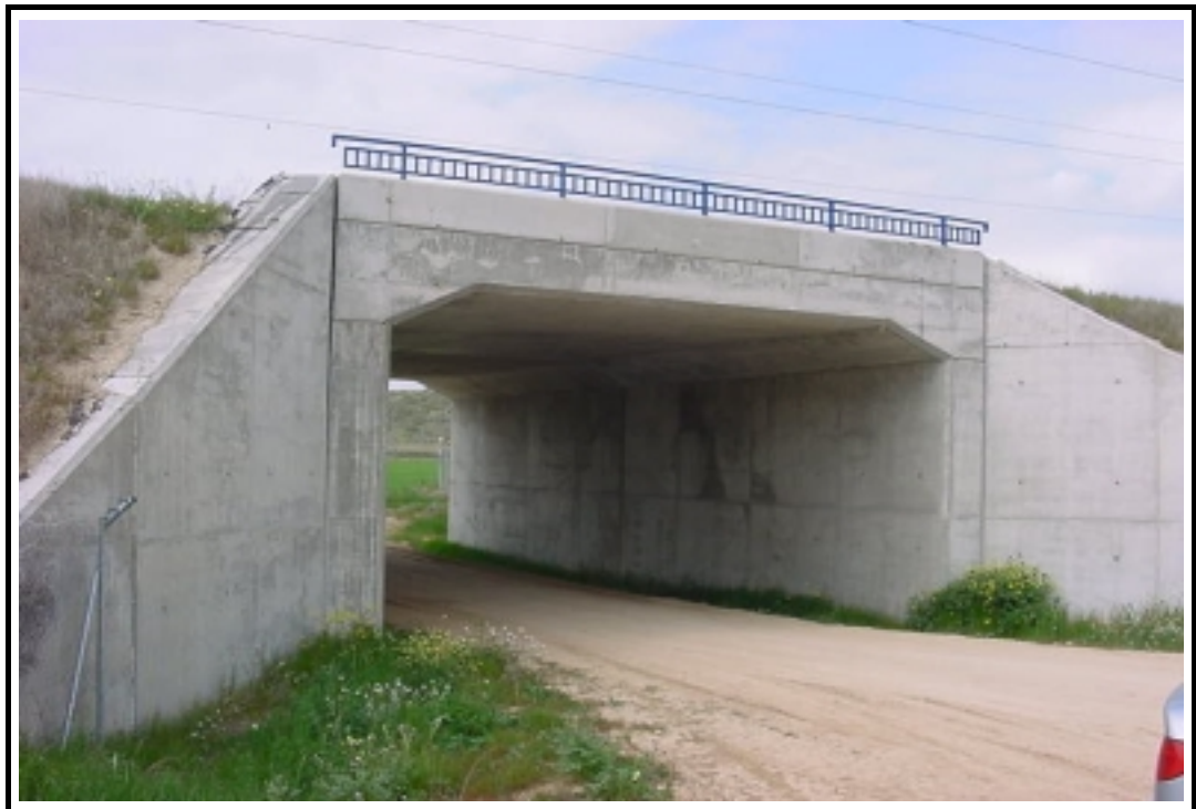
Foto 1: Vista general de la estructura
