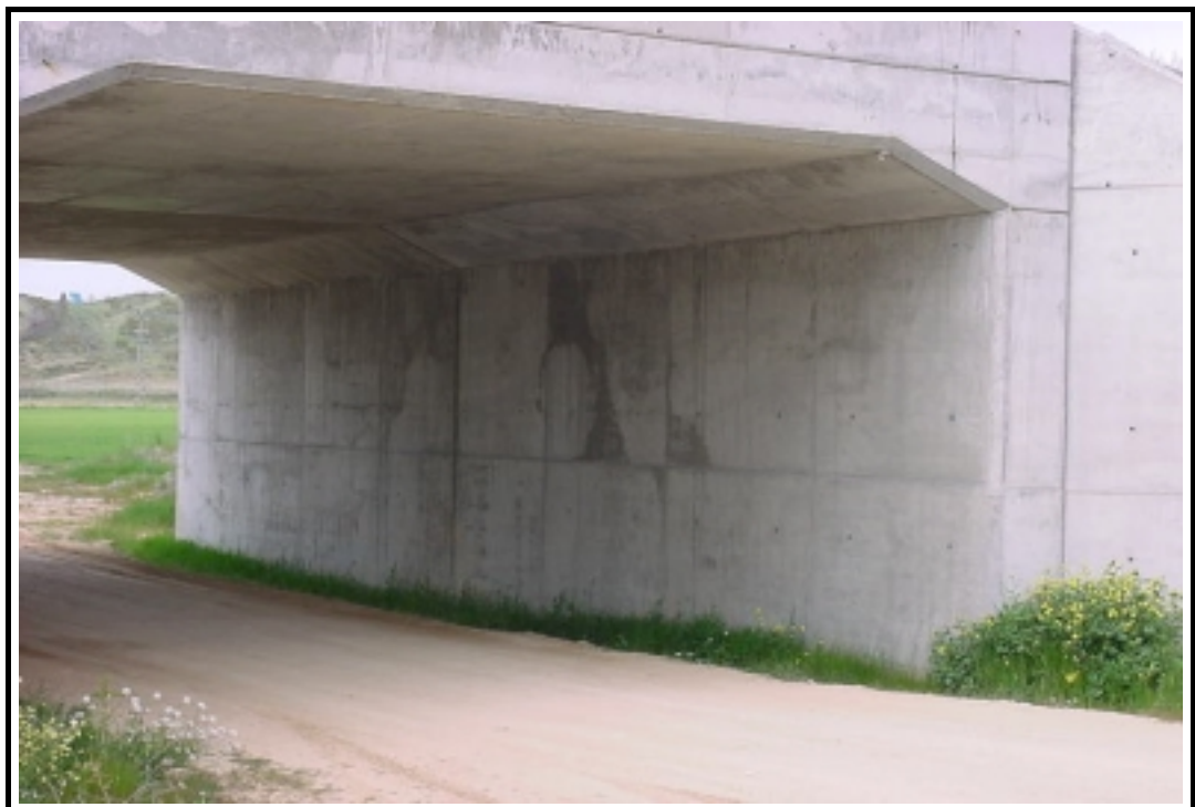
Foto 2: Vista general del estribo de salida
