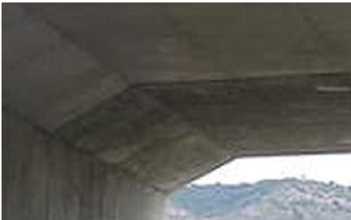
Foto8: Detalle de junta longitudinal
