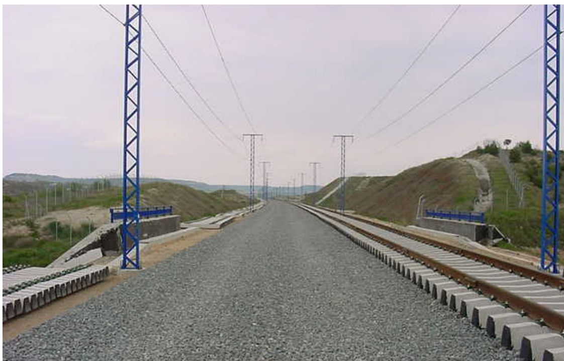
Foto3: Vista superior desde entrada
