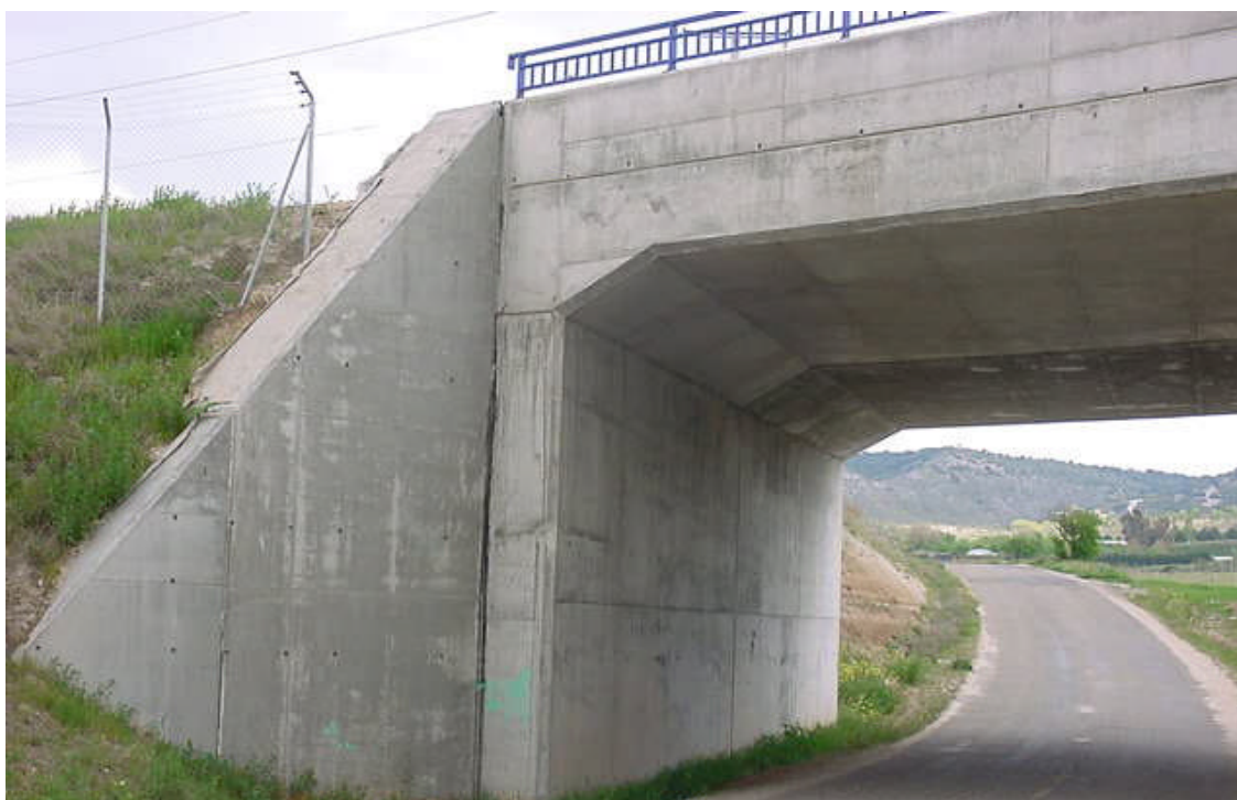
Foto6:Estribo desalida
