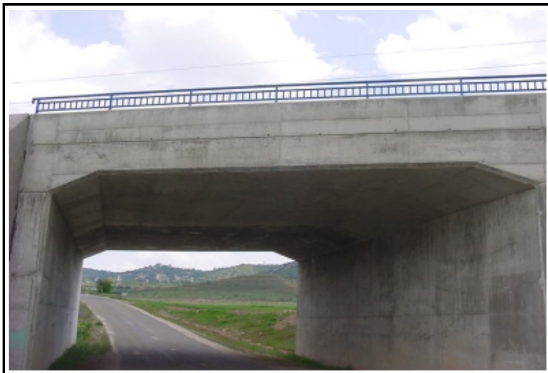
Foto 4: Vista inferior de la estructura
