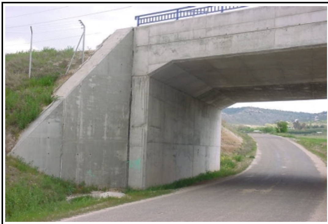
Foto 3: Vista general del estribo de salida
