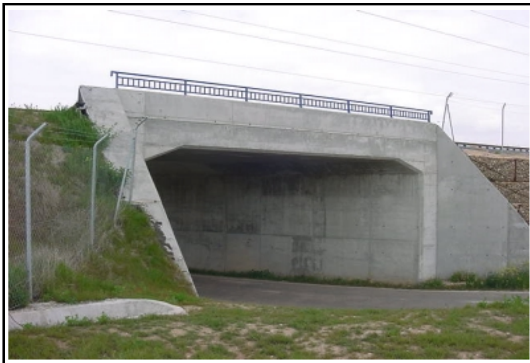
Foto 1: Vista general de la estructura
