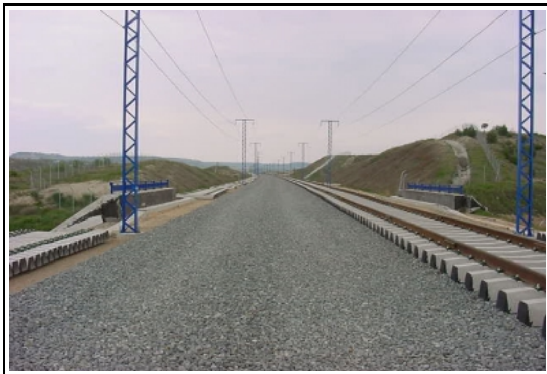
Foto 2: Vista superior de la estructura
