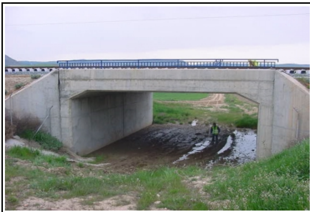
Foto 1: Vista general de la estructura
