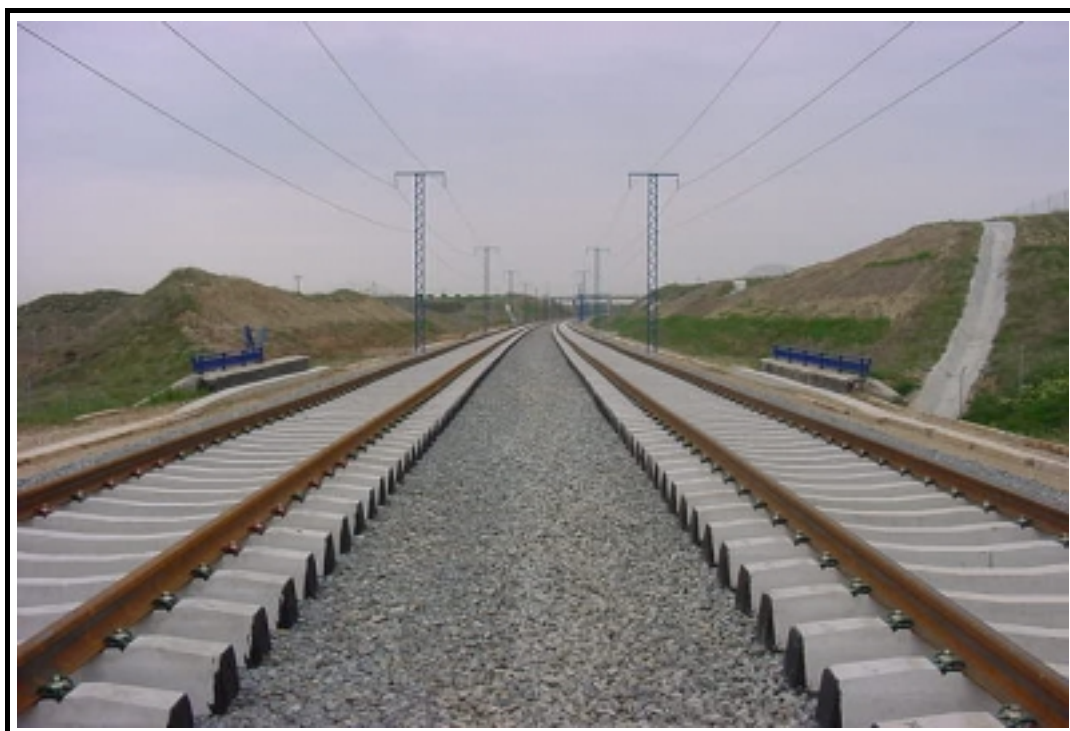
Foto 2: Vista superior de la estructura
