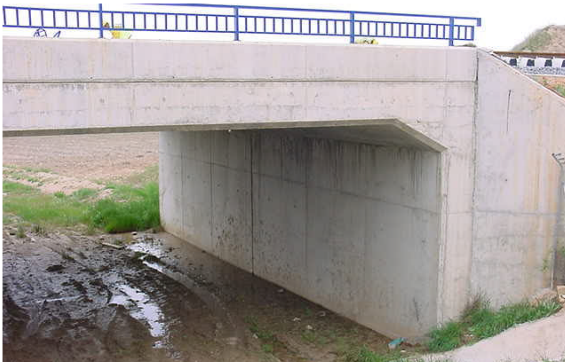
Foto5: Estribo de entrada
