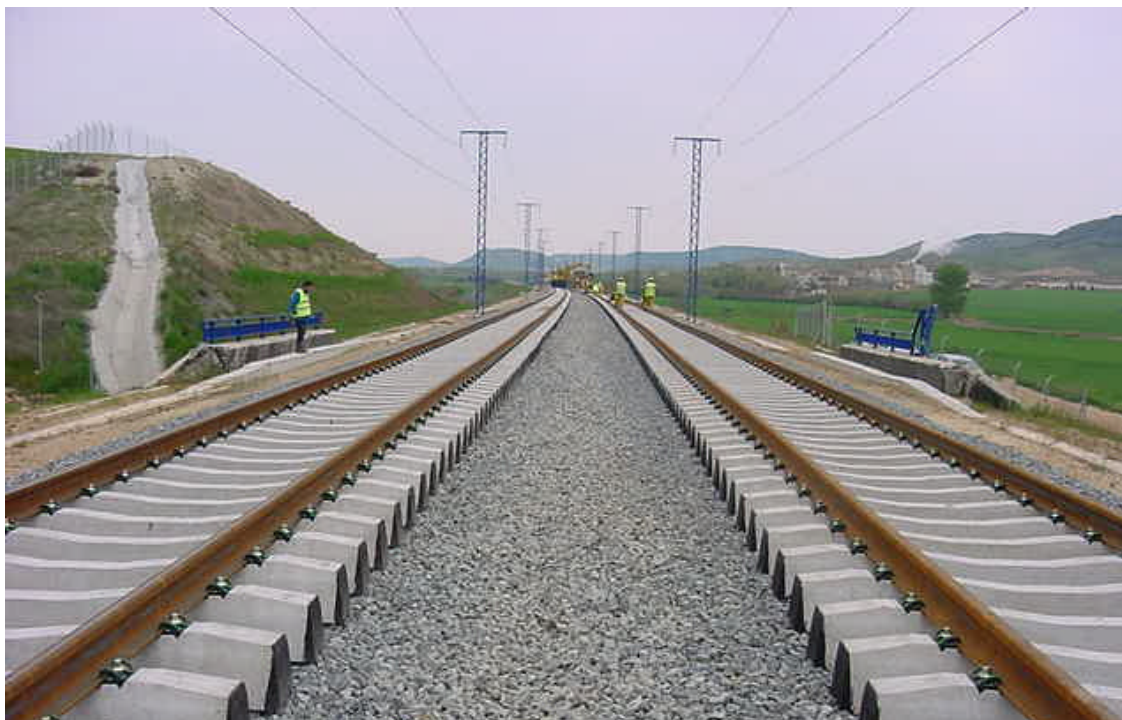
Foto3: Vista superior desde entrada
