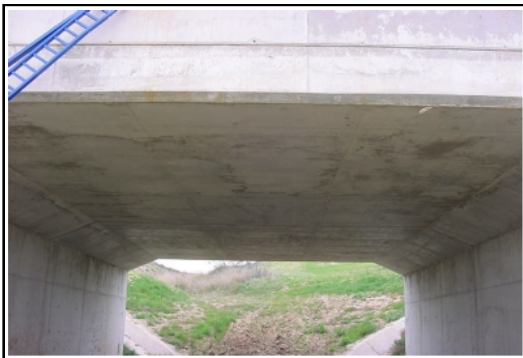
Foto 4: Vista inferior de la estructura
