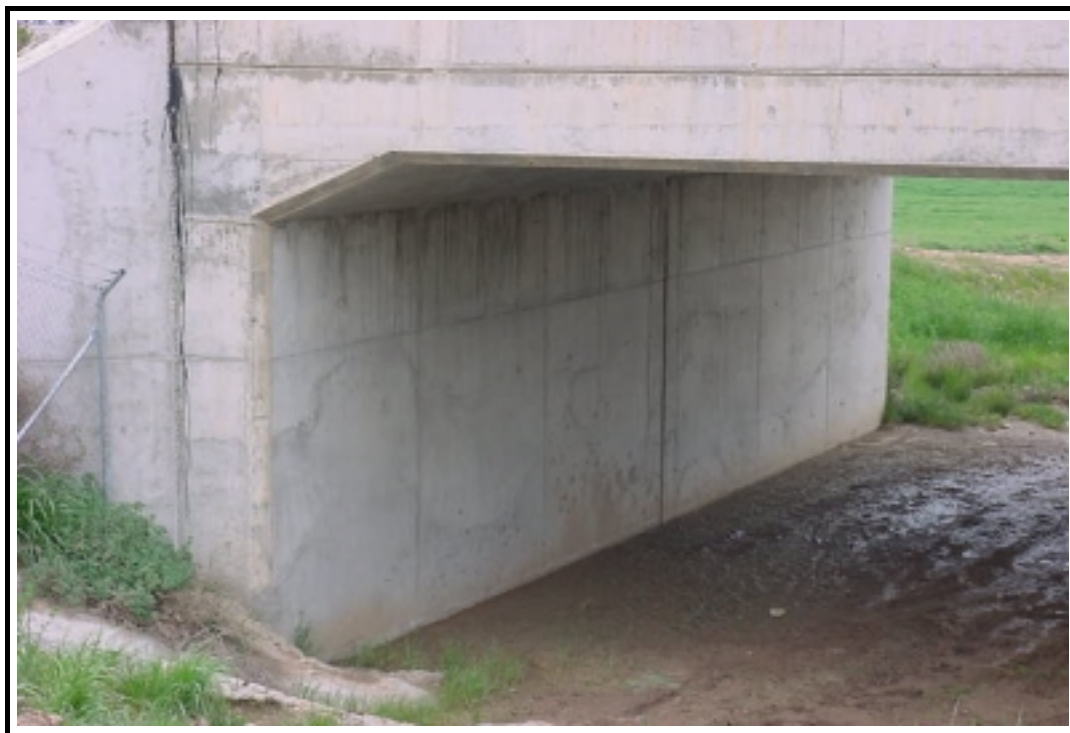
Foto 3: Vista general de estribo de entrada
