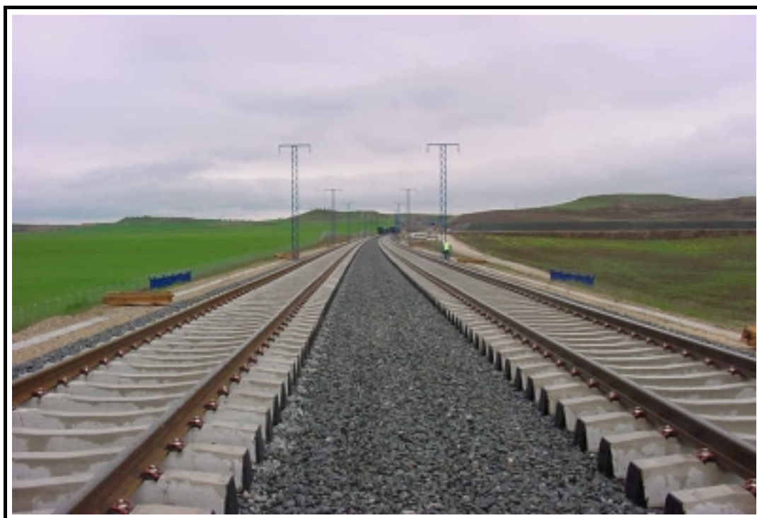
Foto 2: Vista superior de la estructura
