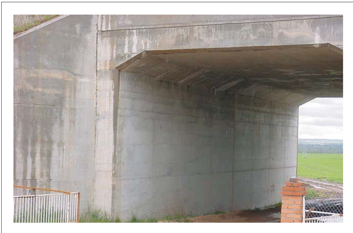
Foto 5: Estribo de entrada
