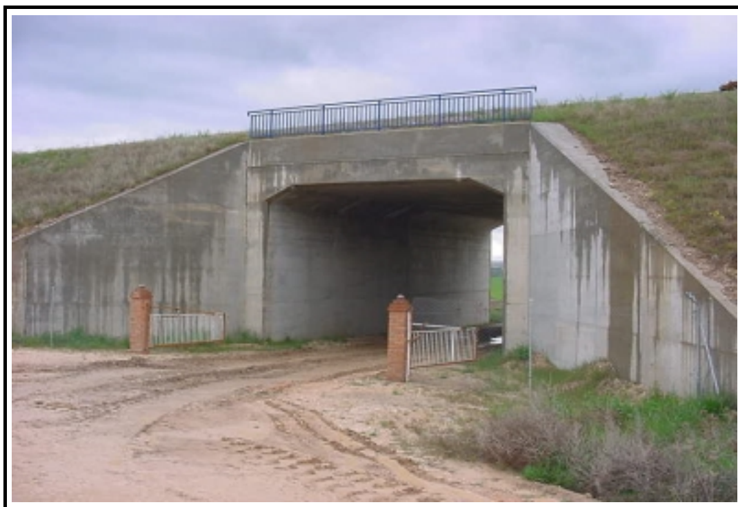
Foto 1: Vista general de la estructura
