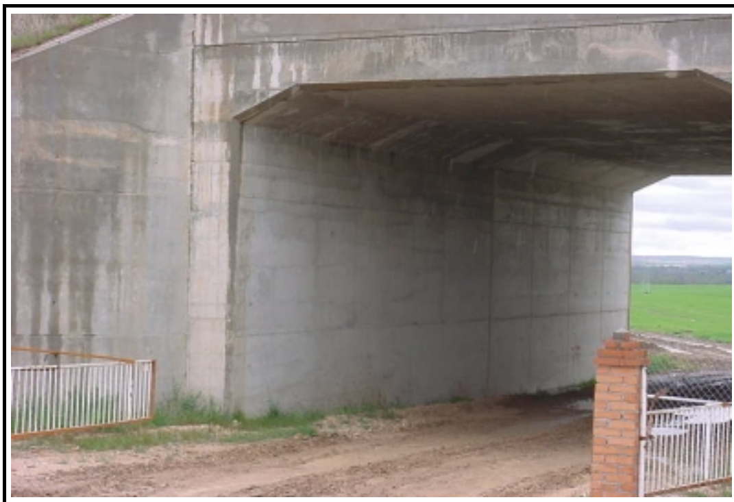
Foto 3: Vista general de estribo de entrada
