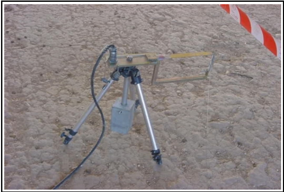
Foto 5: Detalle de ménsula para medida de desplazamientos
