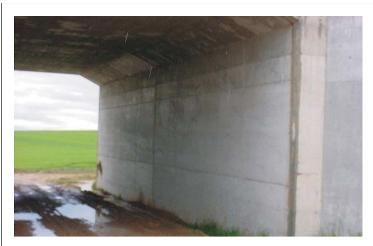
Foto 6: Estribo de salida
