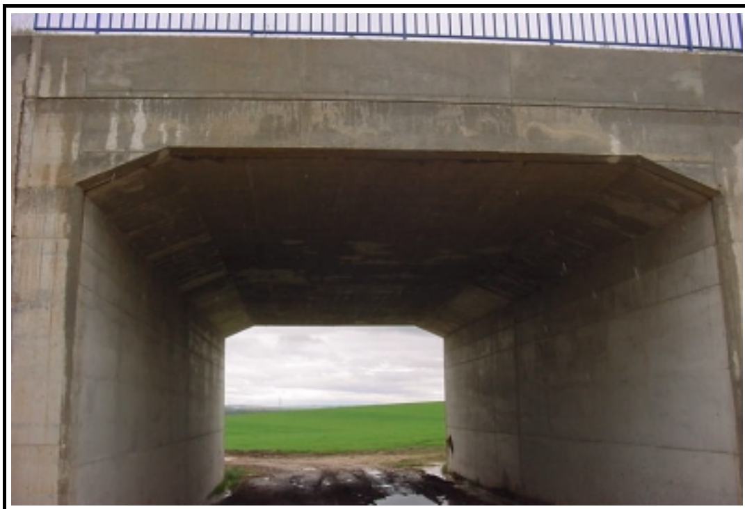
Foto 4: Vista inferior de la estructura
