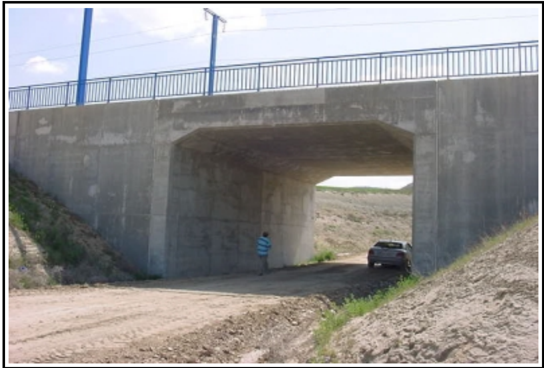
Foto 1: Vista general de la estructura
