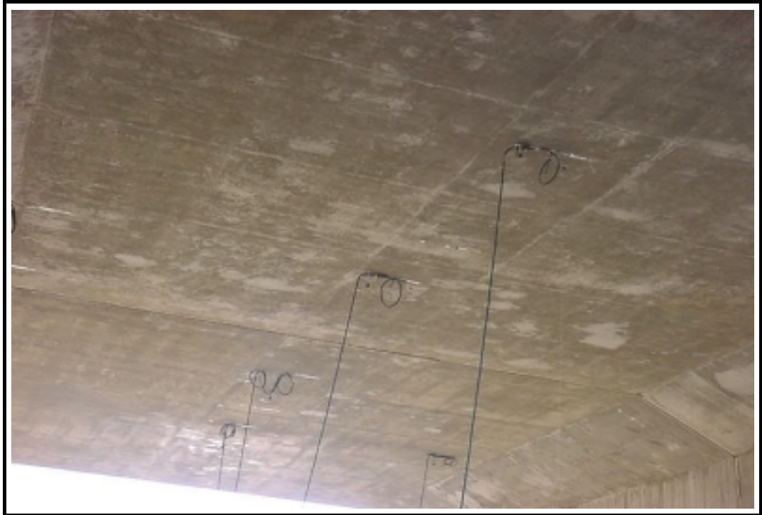
Foto 7: Línea de bandas extensométricas en centro de vano
