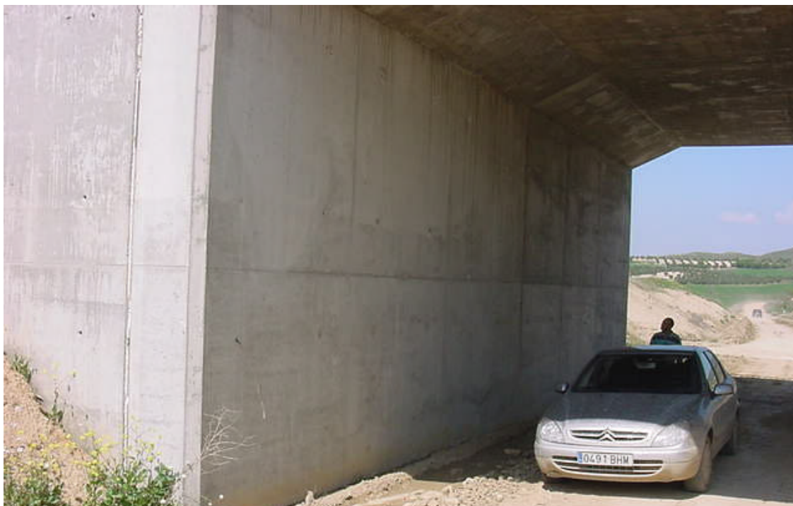
Foto5: Estribo de entrada
