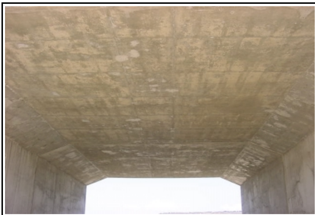
Foto 4: Vista inferior de la estructura
