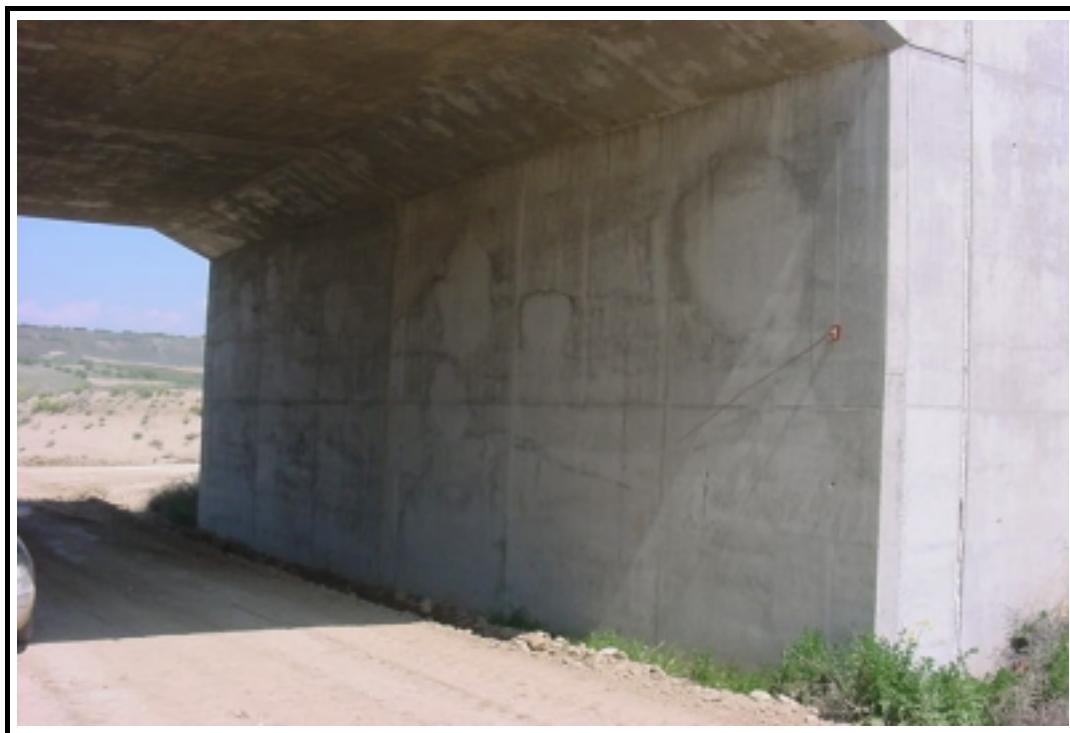
Foto 3: Vista general de estribo de entrada
