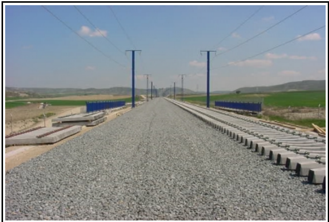
Foto 2: Vista superior de la estructura
