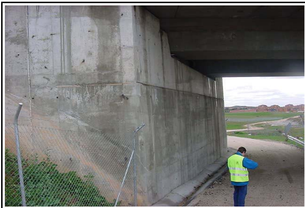
Foto 6: Estribo de salida
