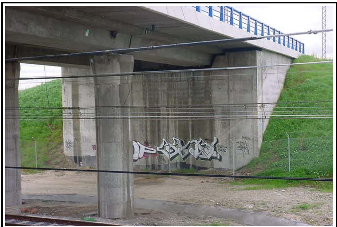
Foto 4: Vista general de estribo
