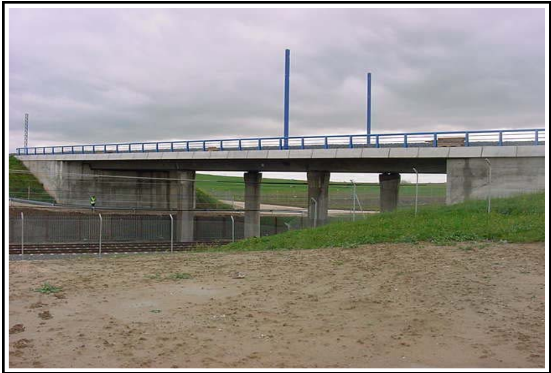
Foto 1: Vista general de la estructura
