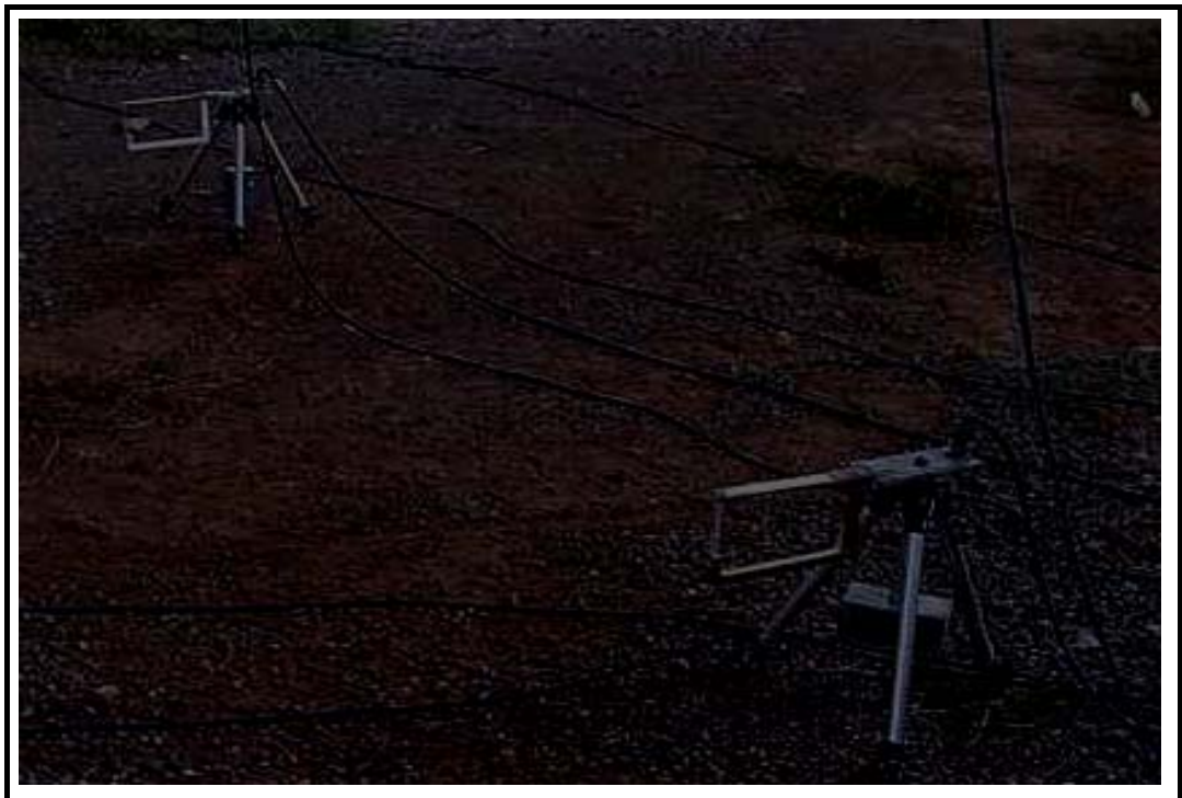
Foto 6: Línea de ménsulas para la medida de flecha (Vano 1)
