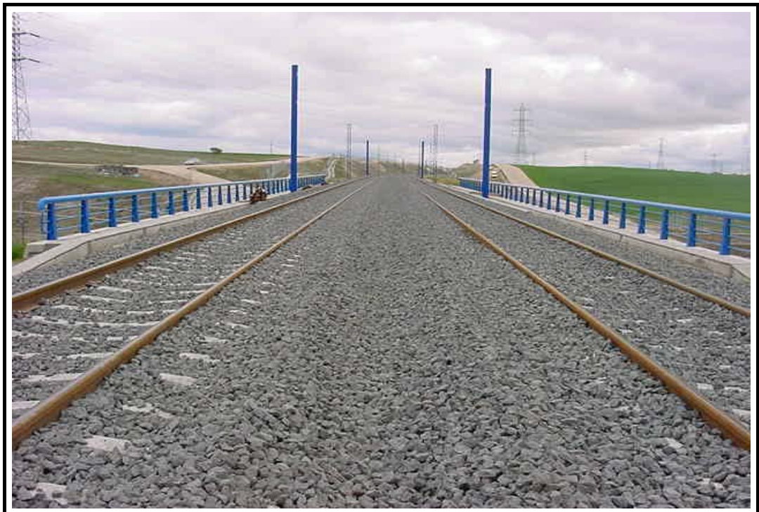
Foto 2: Vista superior de la estructura
