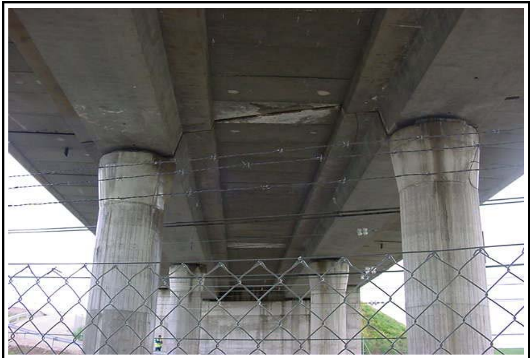
Foto 3: Vista inferior de la estructura
