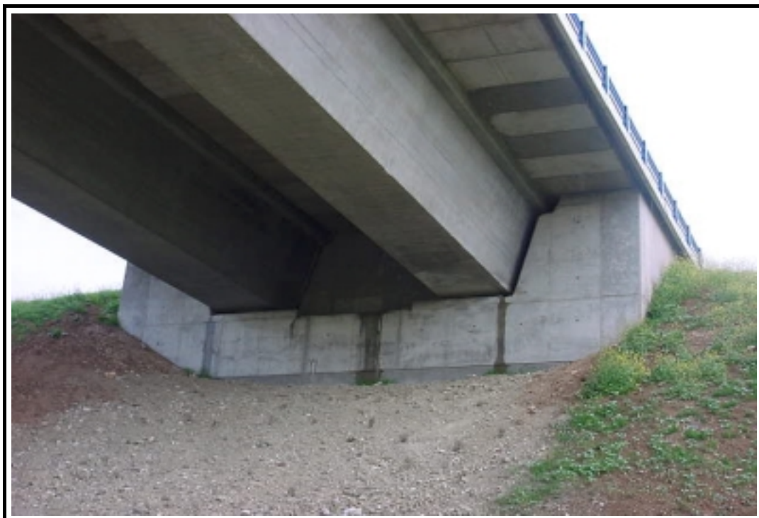
Foto 4: Vista general del estribo de salida
