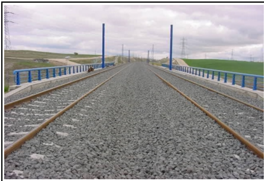
Foto 3: Vista Superior desde entrada
