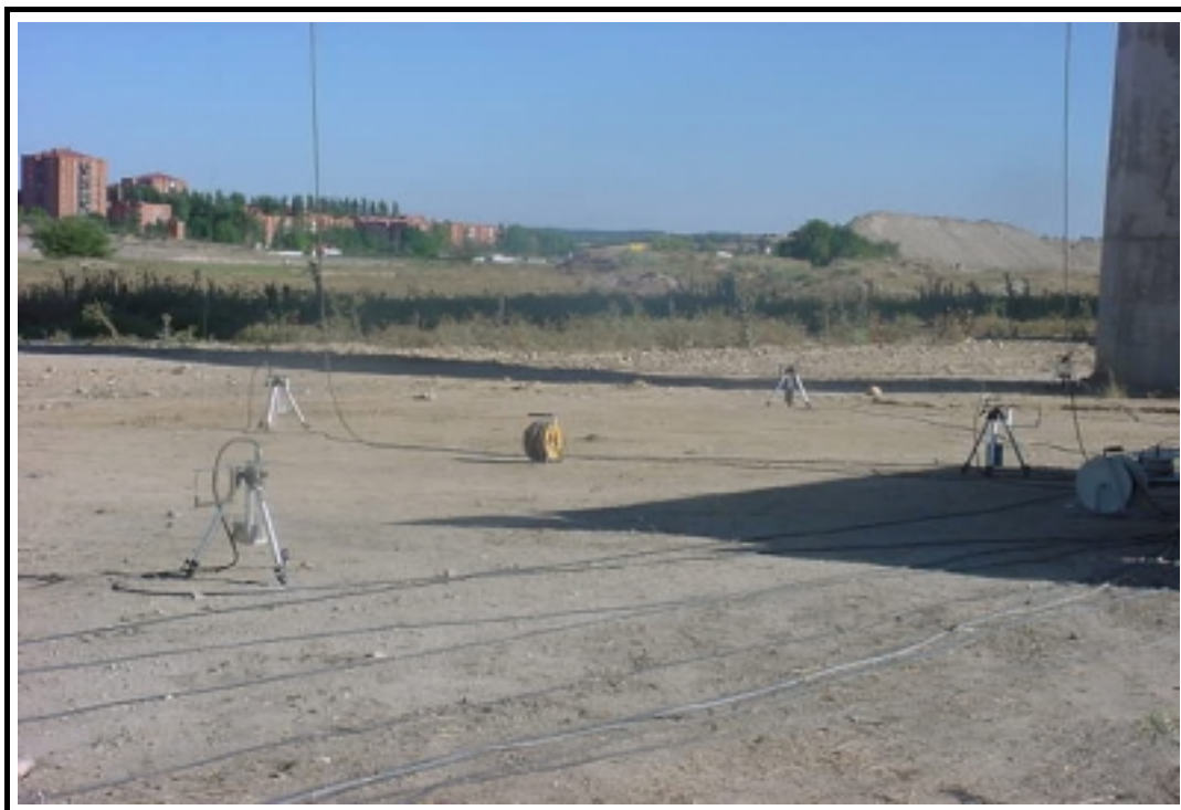
Foto 6: Detalle de apoyo
