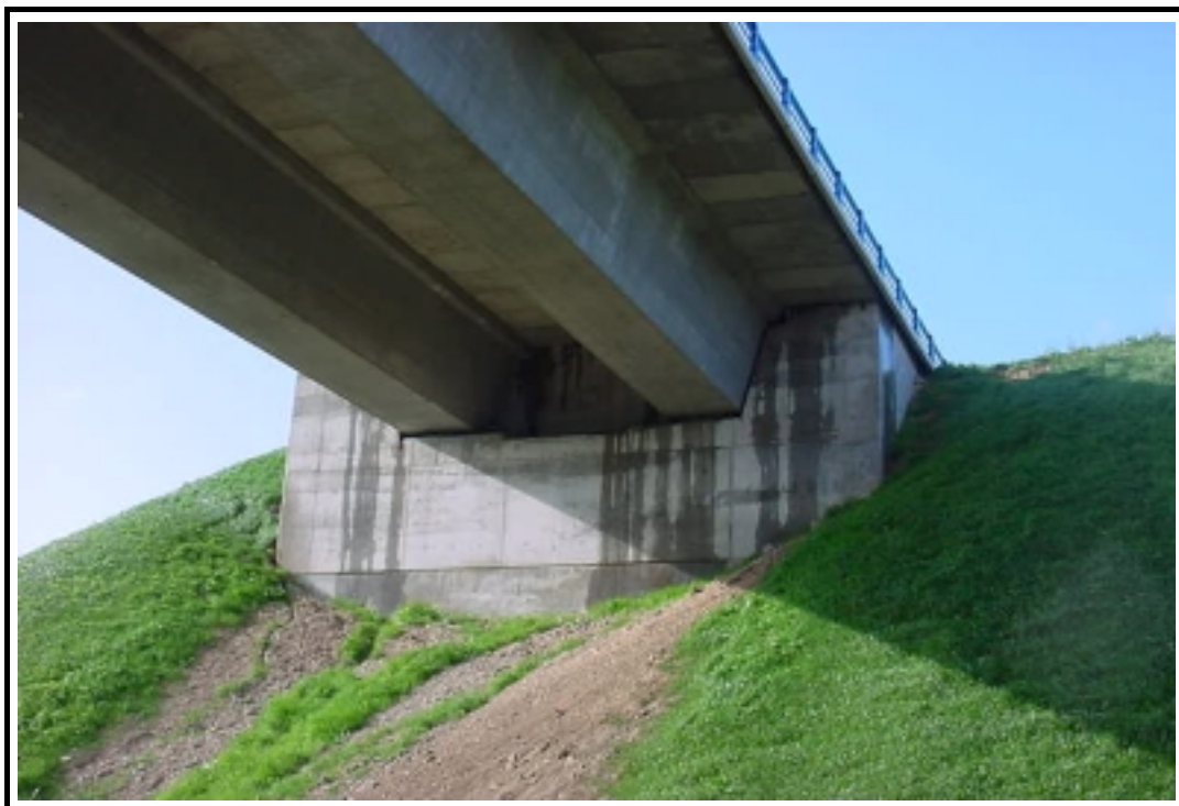
Foto 3: Vista general del estribo de entrada
