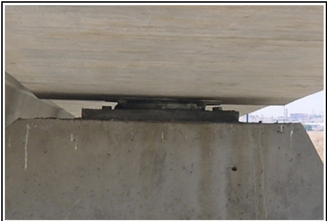
Foto 6: Detalle de apoyo
