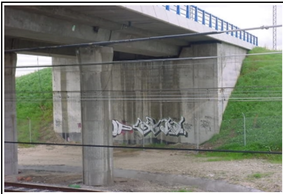
Foto 5: Estribo de entrada
