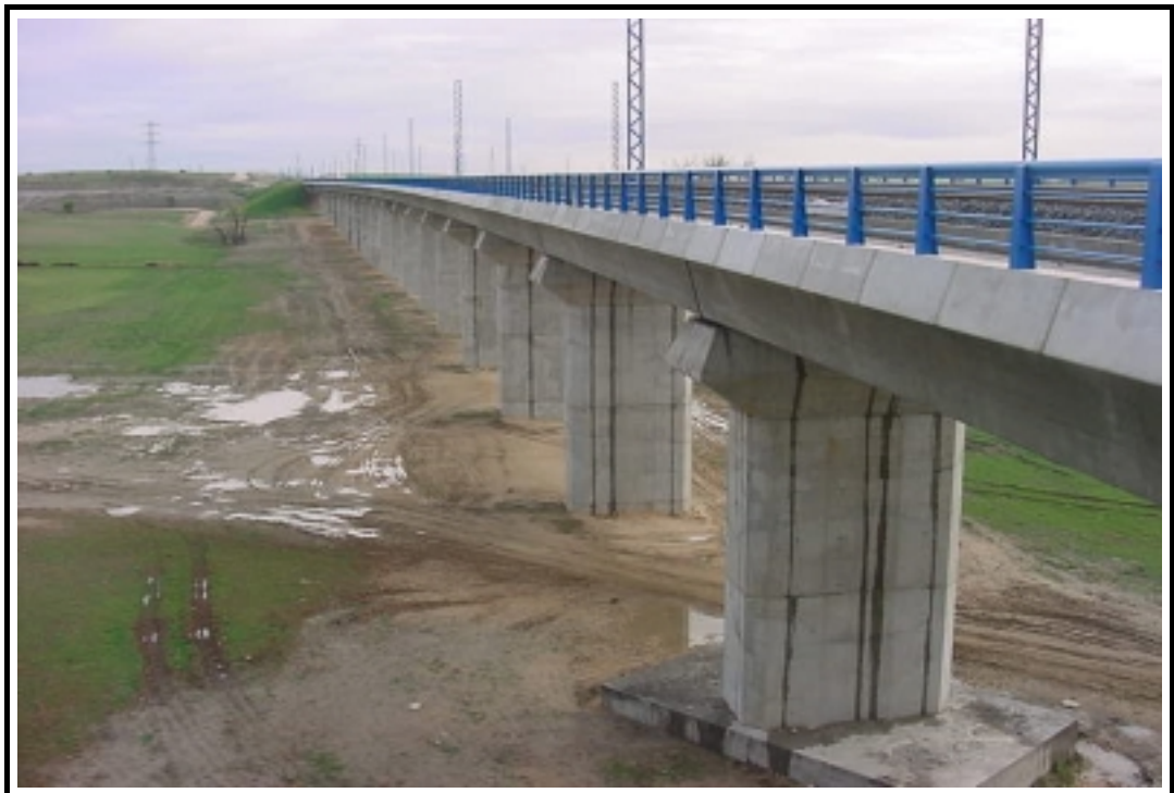
Foto 2: Vista lateral de la estructura
