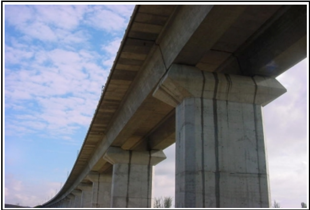
Foto 5: Vista inferior de la estructura
