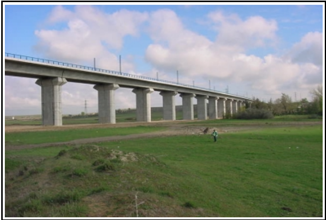
Foto 1: Vista general de la estructura
