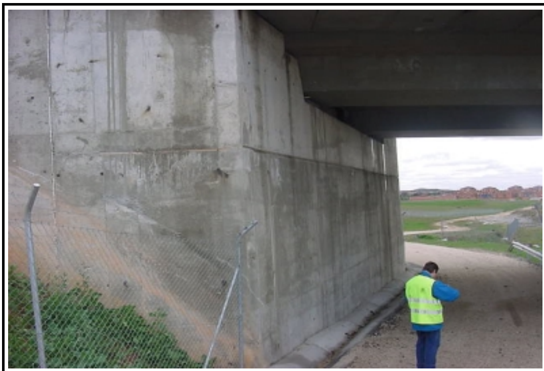
Foto 6: Estribo de salida
