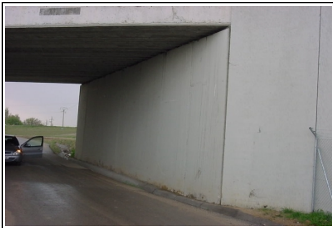
Foto 3: Vista general de estribo de entrada
