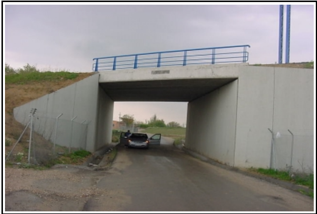
Foto 1: Vista general de la estructura
