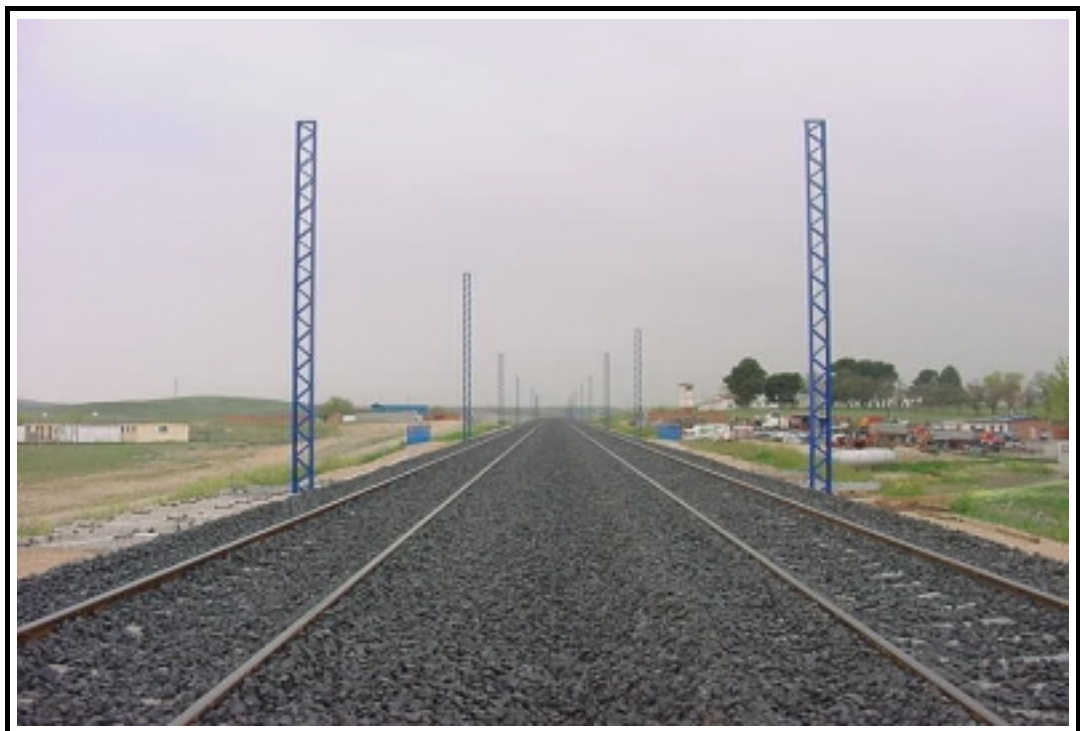
Foto 2: Vista superior de la estructura
