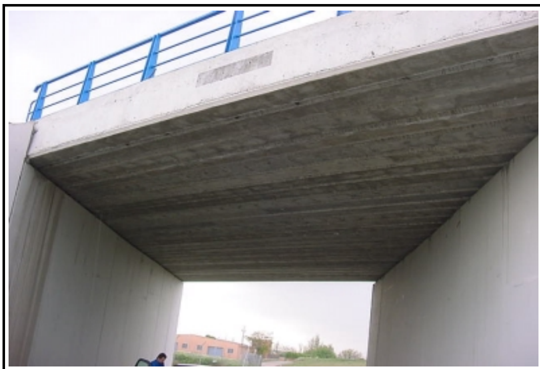
Foto 4: Vista inferior de la estructura
