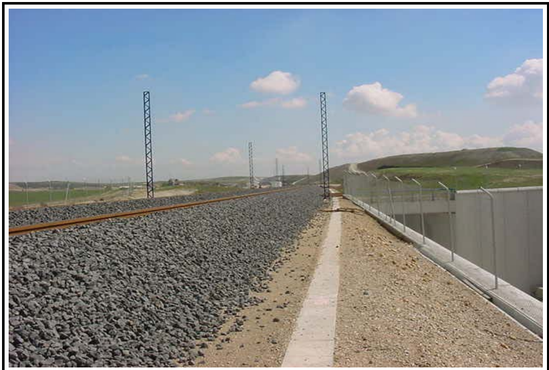
Foto 2: Vista superior de la estructura
