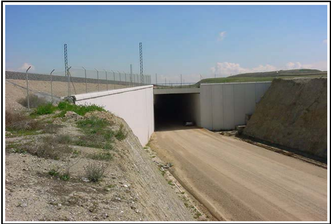
Foto 1: Vista general de la estructura
