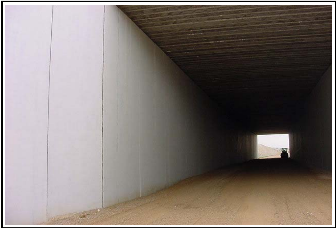
Foto 3: Vista general de estribo de entrada
