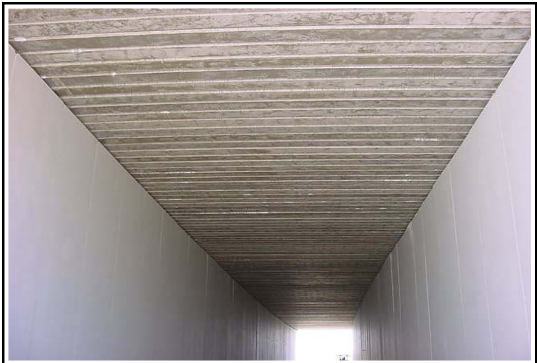
Foto 4: Vista inferior de la estructura
