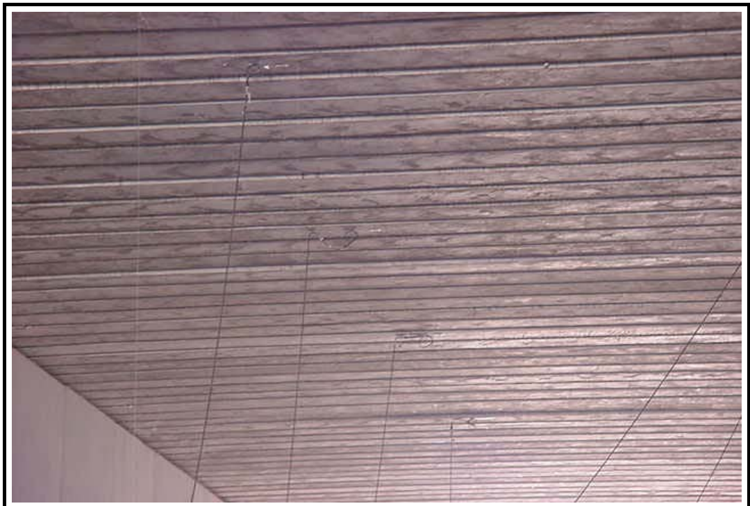
Foto 8: Línea de bandas extensométricas en centro de vano
