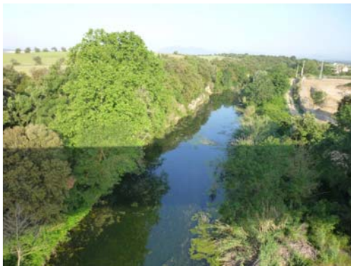
Vista aguas arriba
