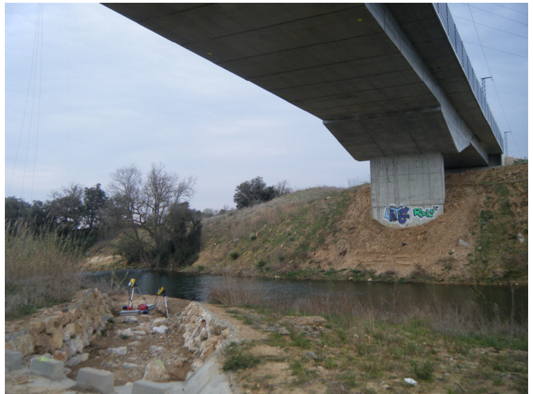
Fotografía N°4: Instrumentación del vano 2.
