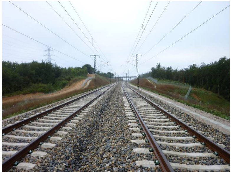
Fotografía N°7: Vista superior desde el estribo de salida.
