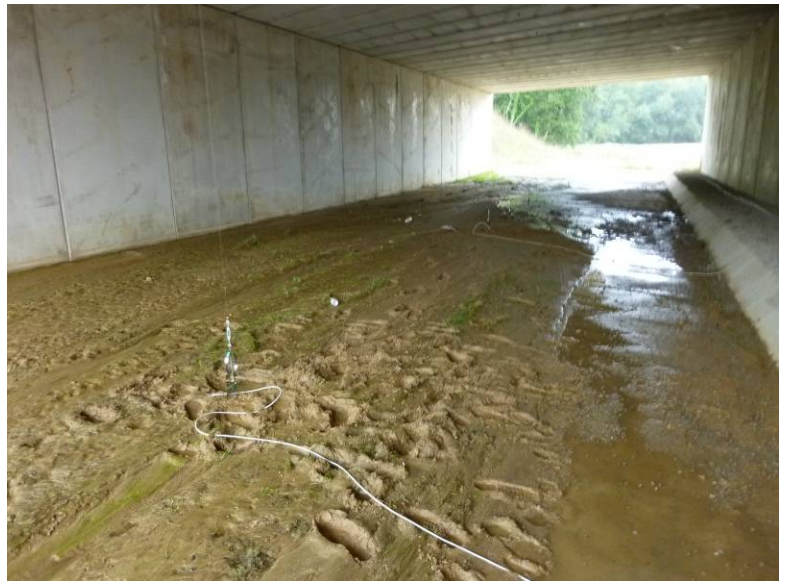
Fotografía N°1: Anillos en centro de vano.
