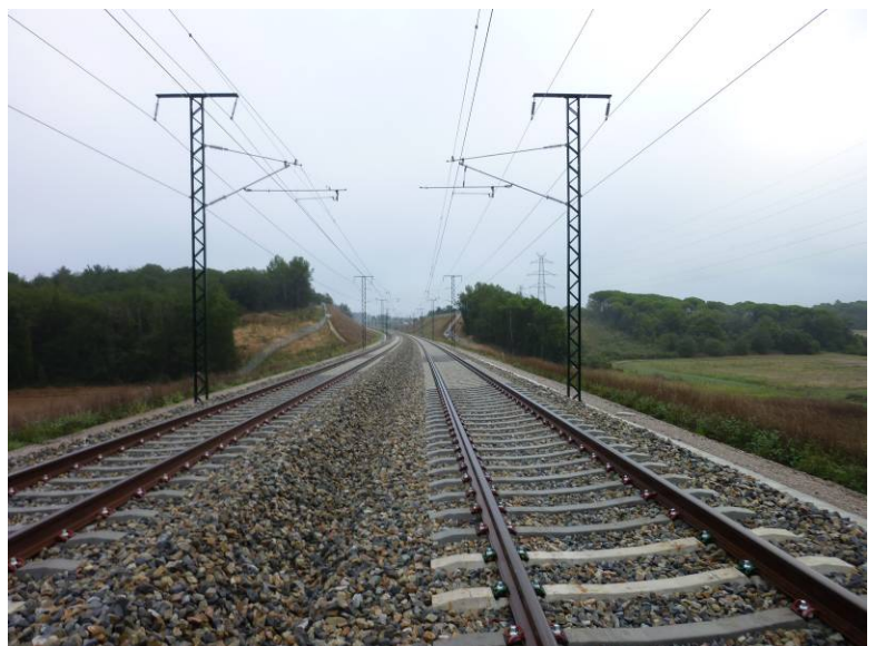
Fotografía N°6: Vista superior desde el estribo de entrada.
