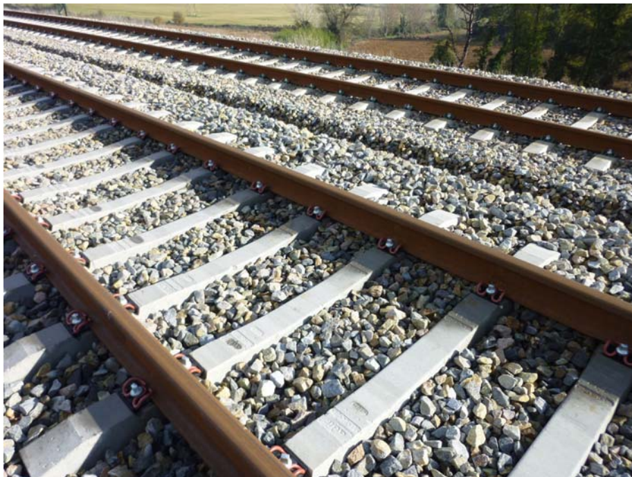
FOTOGRAFIA N° 6: Vista del material de vía
