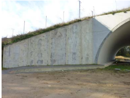
Fotografía nº 5. Estribo de entrada
