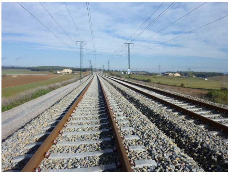
FOTOGRAFIA N° 1: Vista Superior del tablero dirección Francia
