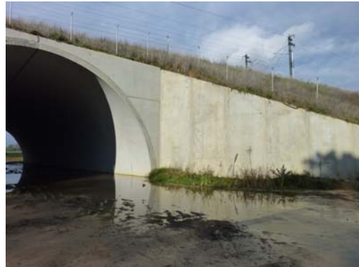
Fotografía nº 6. Estribo de salida
