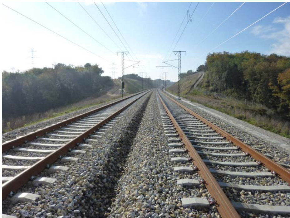
FOTOGRAFIA N° 2: Vista superior del tablero dirección Barcelona
