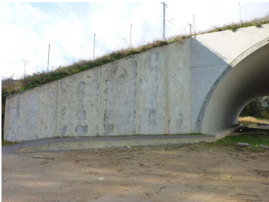
FOTOGRAFIA N° 10: Vista del estribo de entrada
