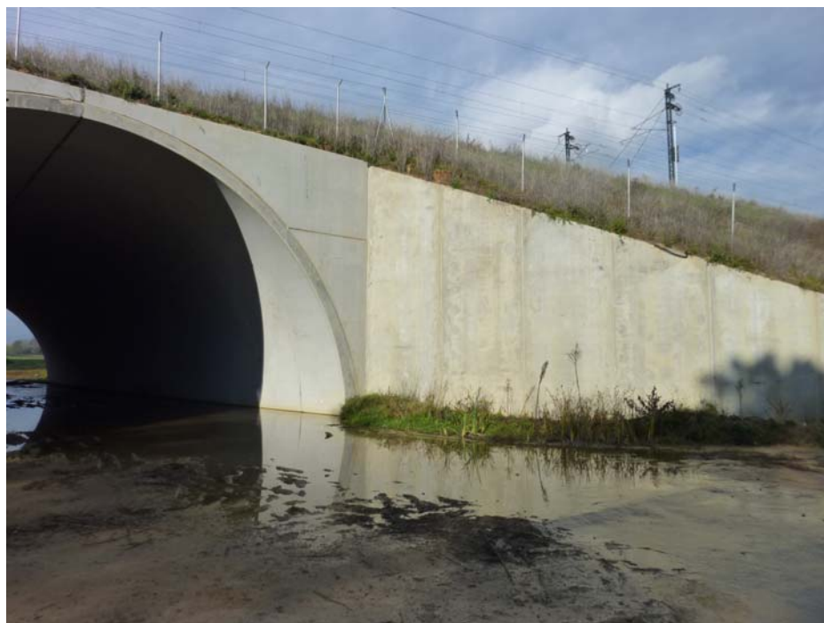
FOTOGRAFIA N° 11: Vista del estribo de salida
