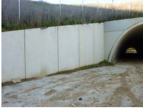
Fotografía nº 5. Estribo de entrada
