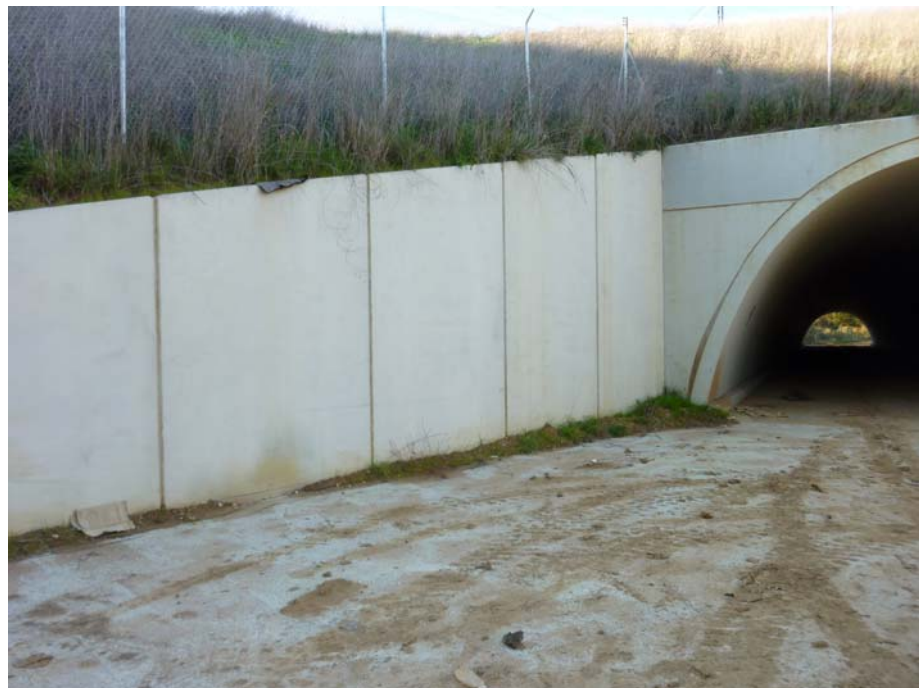
FOTOGRAFIA N° 10: Vista del estribo de entrada
