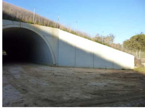
Fotografía nº 6. Estribo de salida
