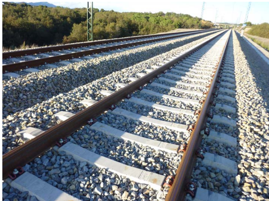
FOTOGRAFIA N° 6: Vista del material de vía
