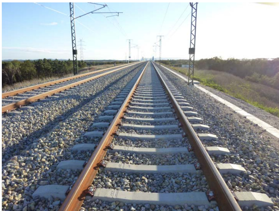
FOTOGRAFIA N° 2: Vista superior del tablero dirección Barcelona
