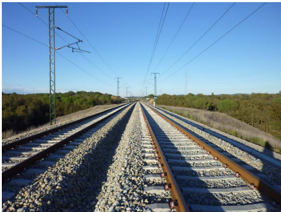
FOTOGRAFIA N° 1: Vista Superior del tablero dirección Francia
