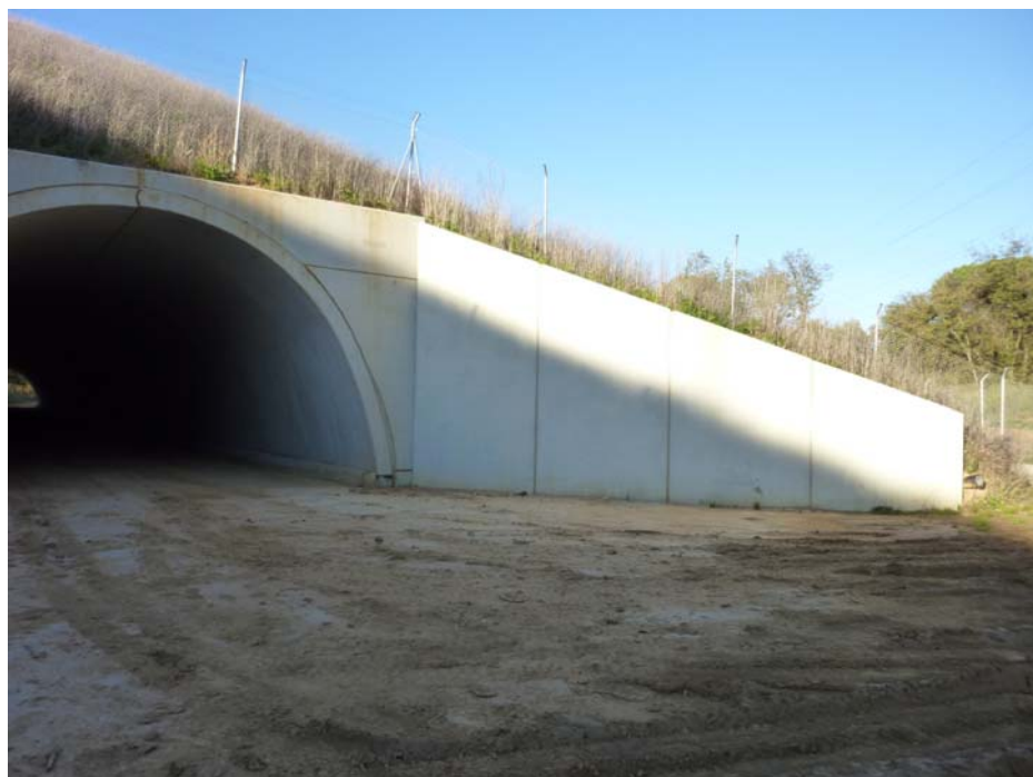
FOTOGRAFIA N° 11: Vista del estribo de salida
