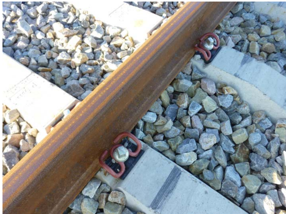
FOTOGRAFIA N° 7: Detalle de sujeción del carril
