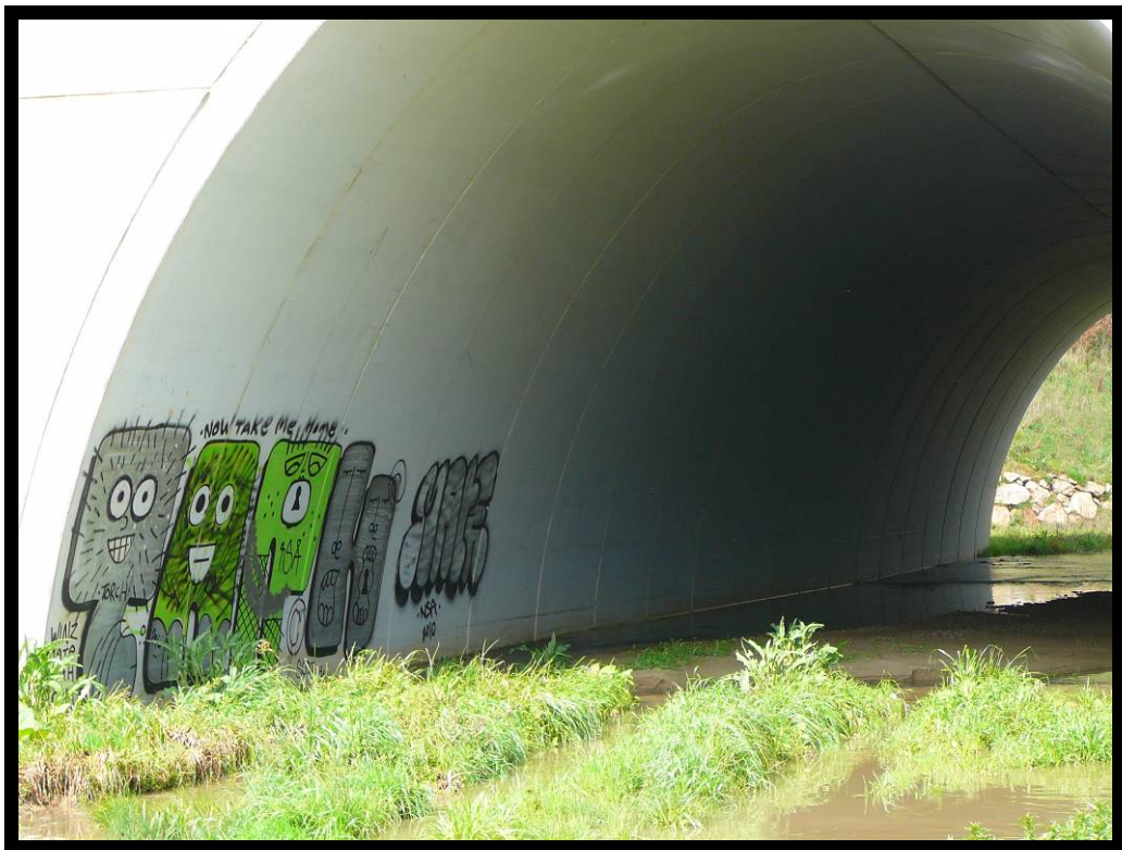
4. Estribo de entrada.
