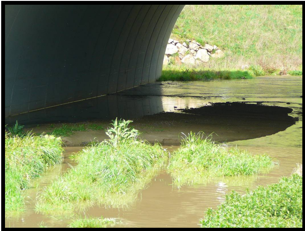
21. Barra bajo estructura.
