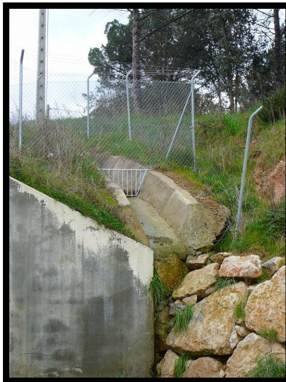
18. Drenaje, margen derecho, aguas arriba.
