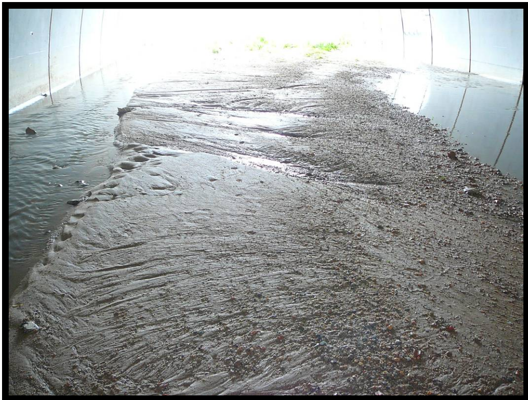
22. Barra bajo estructura.
