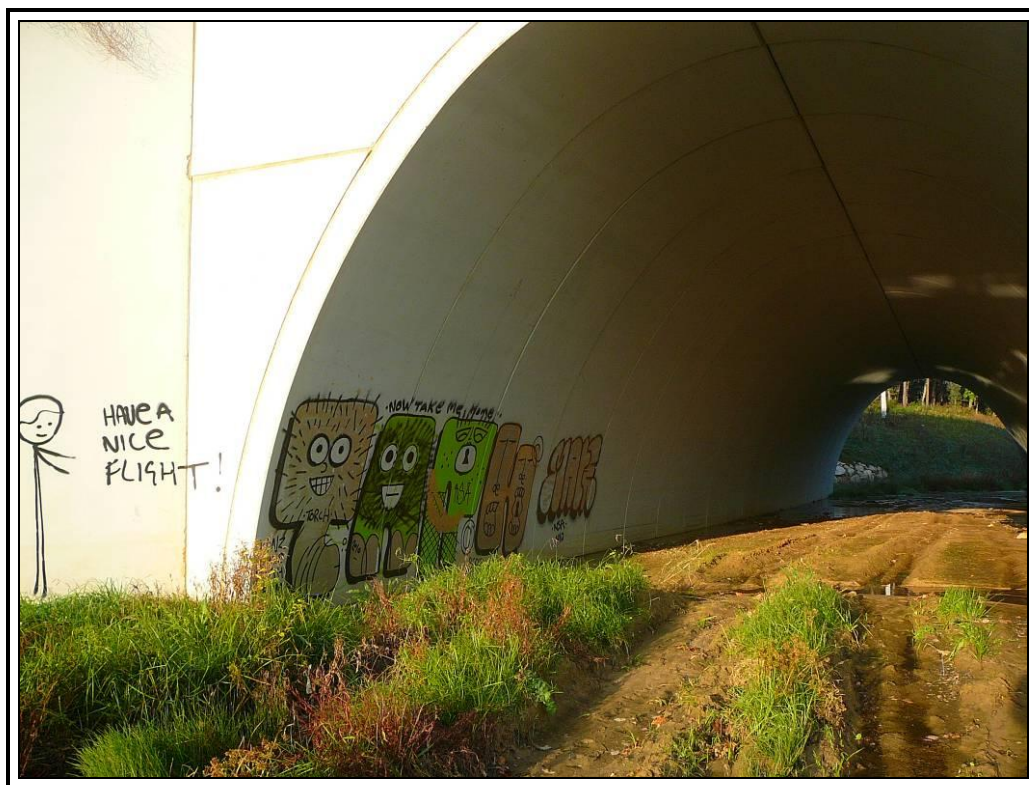
Semibóveda de entrada
