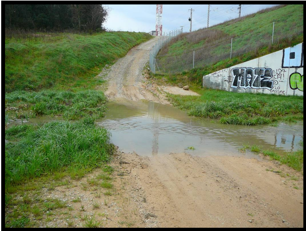
17. camino, aguas abajo de la estructura.
