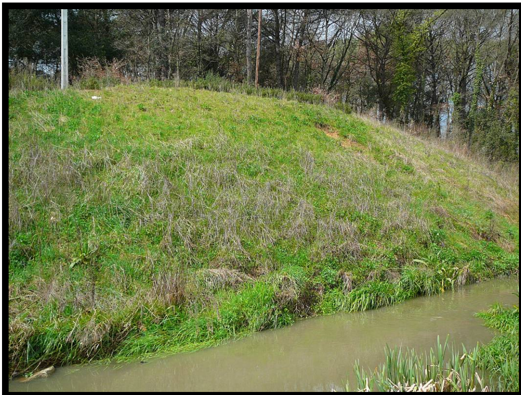
9. Margen derecha del cauce aguas arriba.
