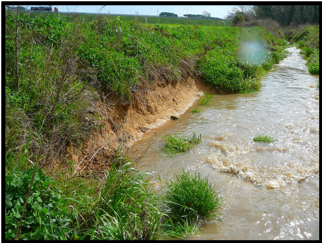
12. Margen izquierda del cauce aguas abajo.
