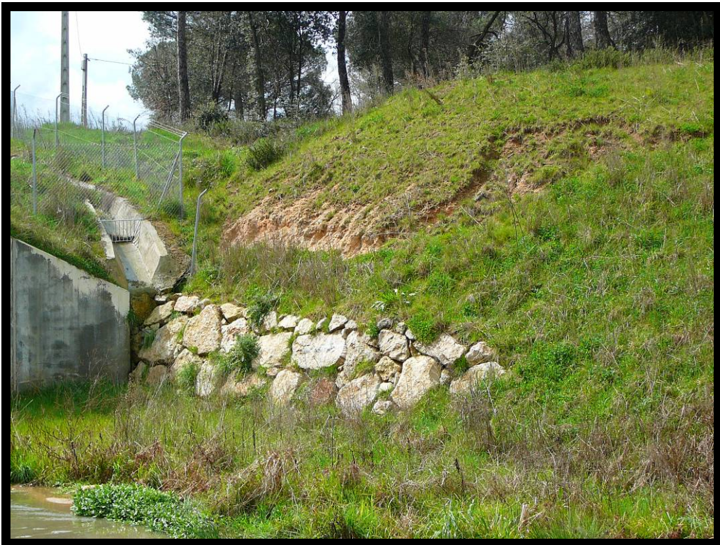
20. Protección margen derecha, aguas arriba.
