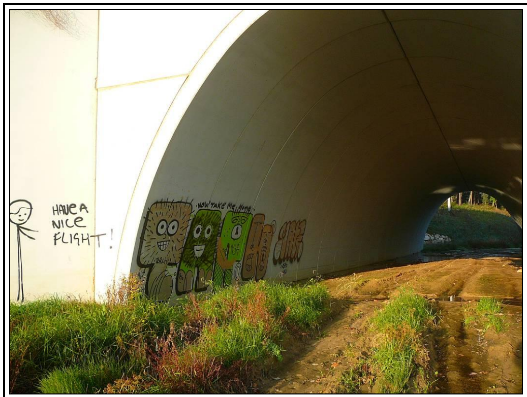
Semibóveda de entrada
