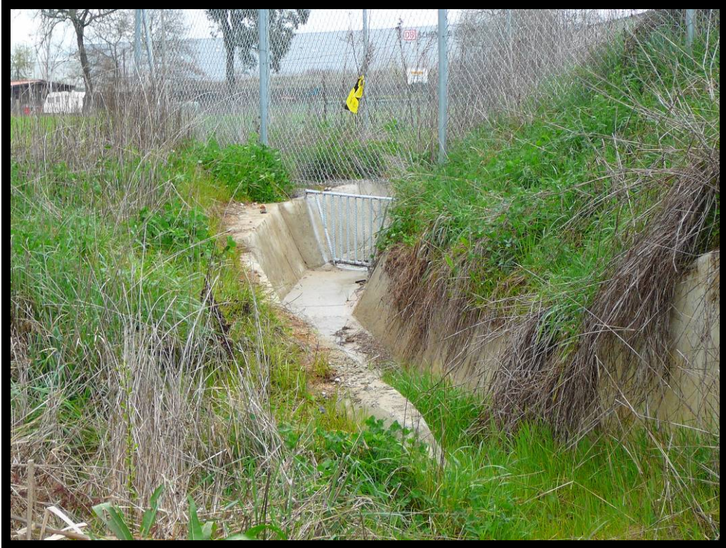
19. Drenaje, margen izquierdo, aguas arriba.
