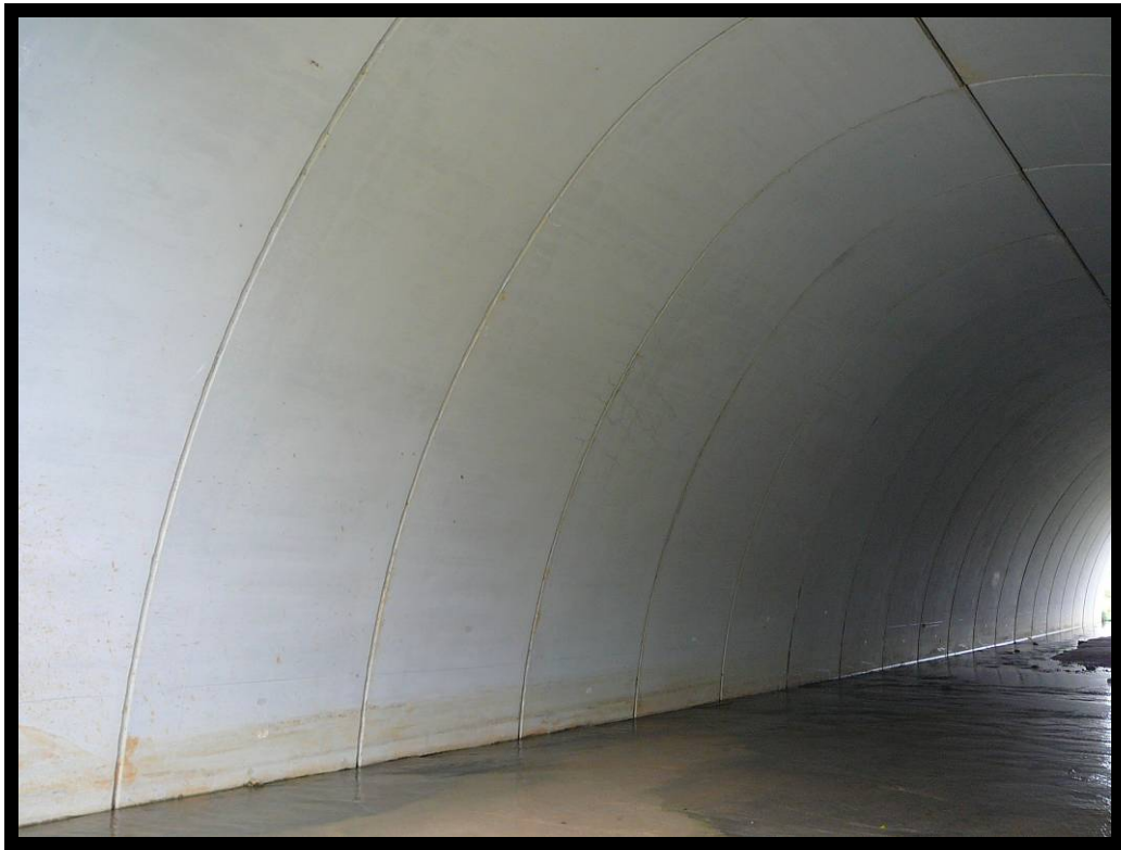
5. Estribo de salida.
