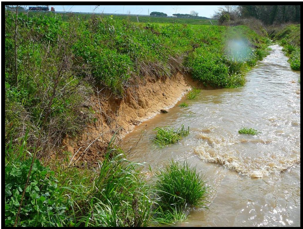
24. Socavación en margen izquierda, aguas abajo.
