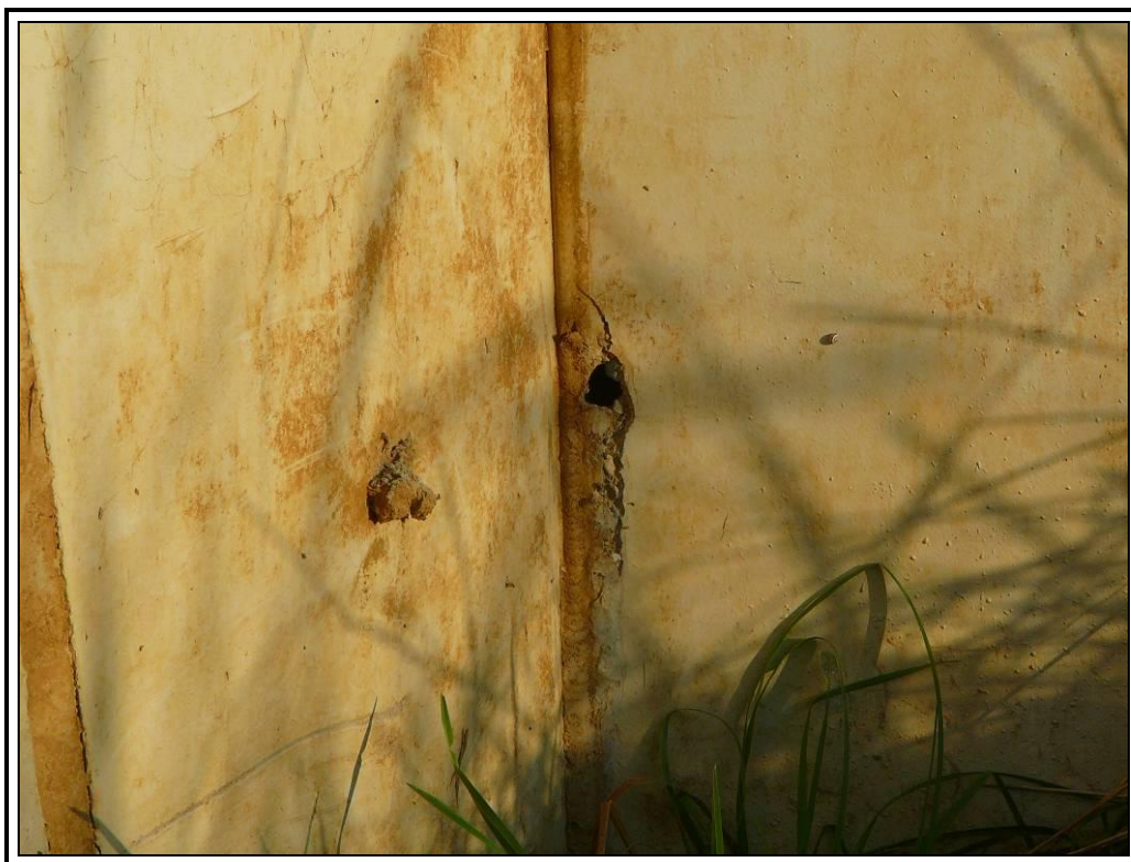
Desconchón en aleta izquierda de semibóveda de salida
