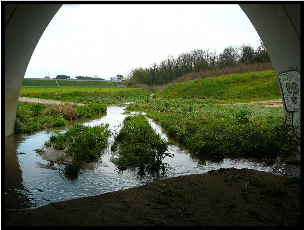
7. Cauce hacia aguas abajo.
