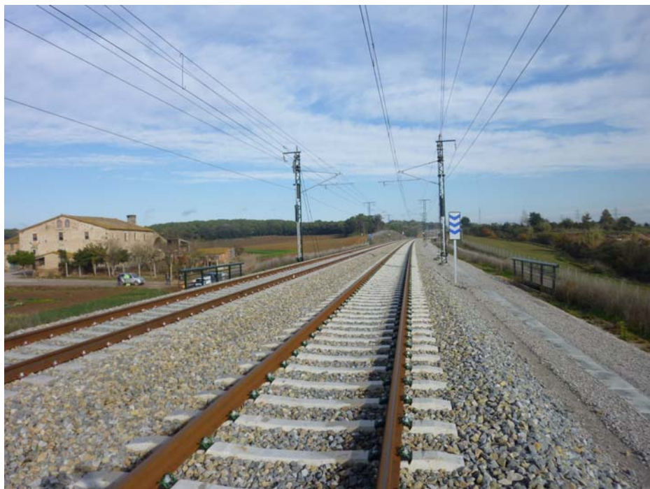
FOTOGRAFIA Nº 1: Vista Superior del tablero dirección Figueres
