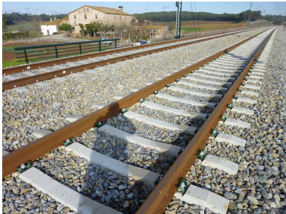
FOTOGRAFIA N° 6: Vista del material de vía
