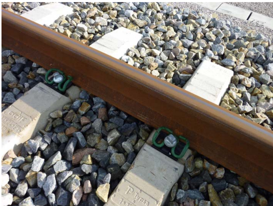
FOTOGRAFIA N° 7: Detalle de sujeción del carril
