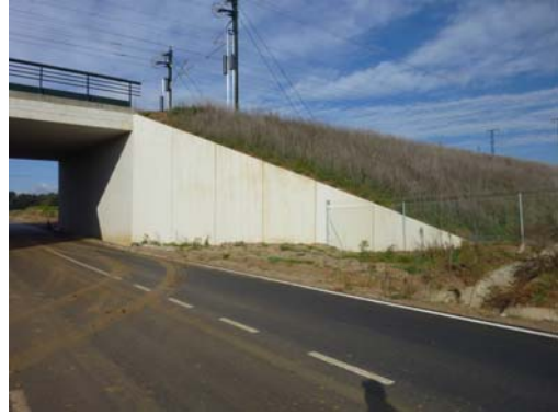
Fotografía nº 6. Estribo de salida
