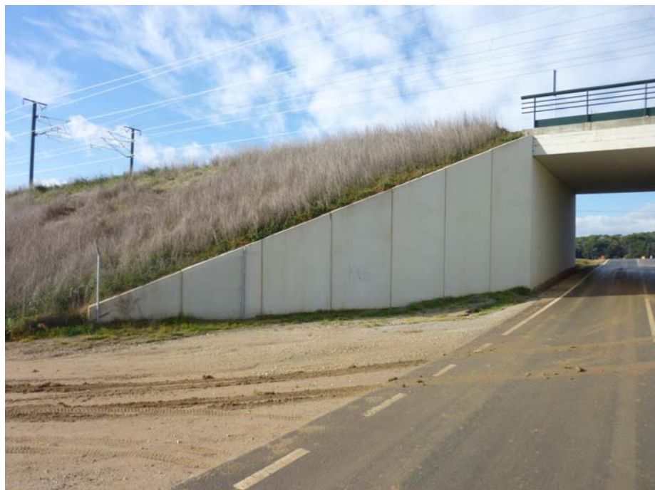
FOTOGRAFIA N° 10: Vista del estribo de entrada
