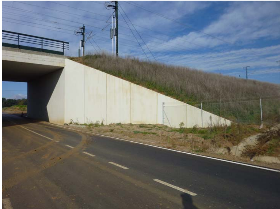
FOTOGRAFIA N° 11: Vista del estribo de salida
