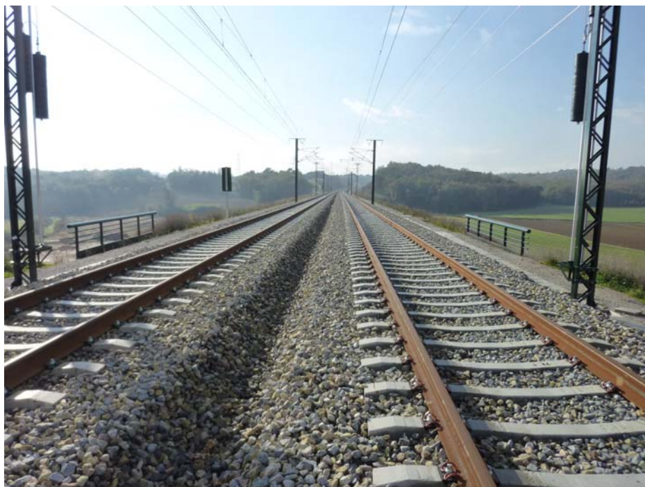
FOTOGRAFIA Nº 2: Vista superior del tablero dirección Barcelona
