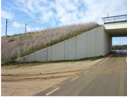
Fotografía nº 5. Estribo de entrada
