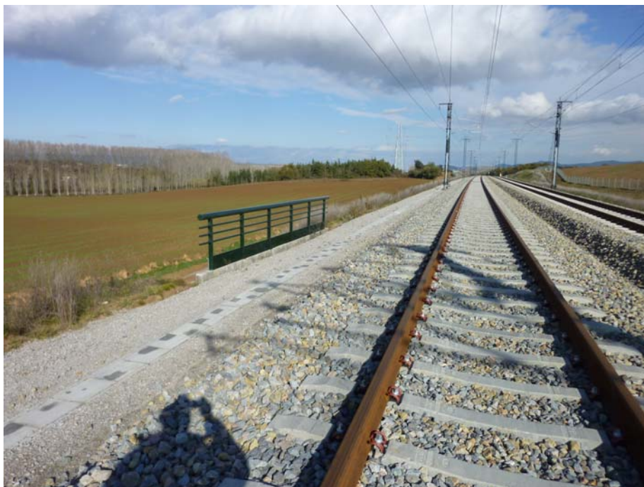
FOTOGRAFIA N° 9: Vista del lado izquierdo de la plataforma
