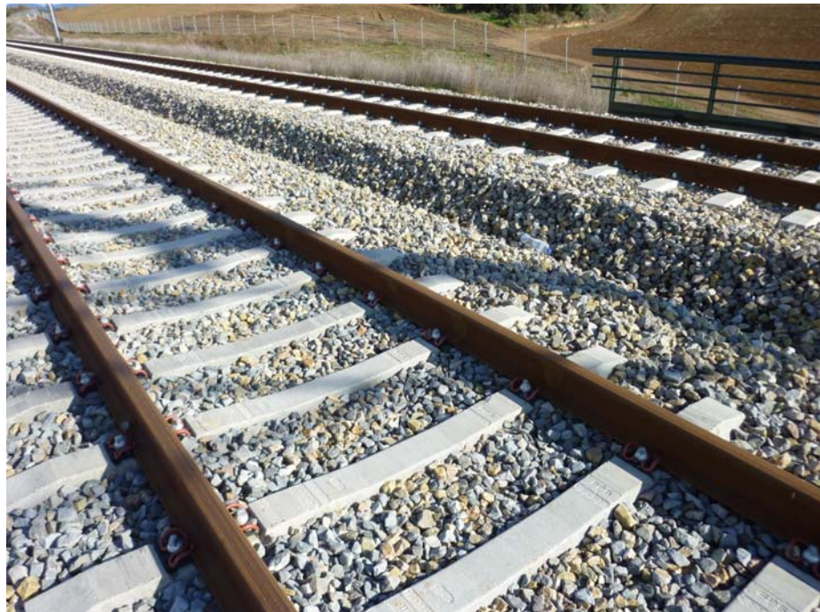
FOTOGRAFIA N° 6: Vista del material de vía
