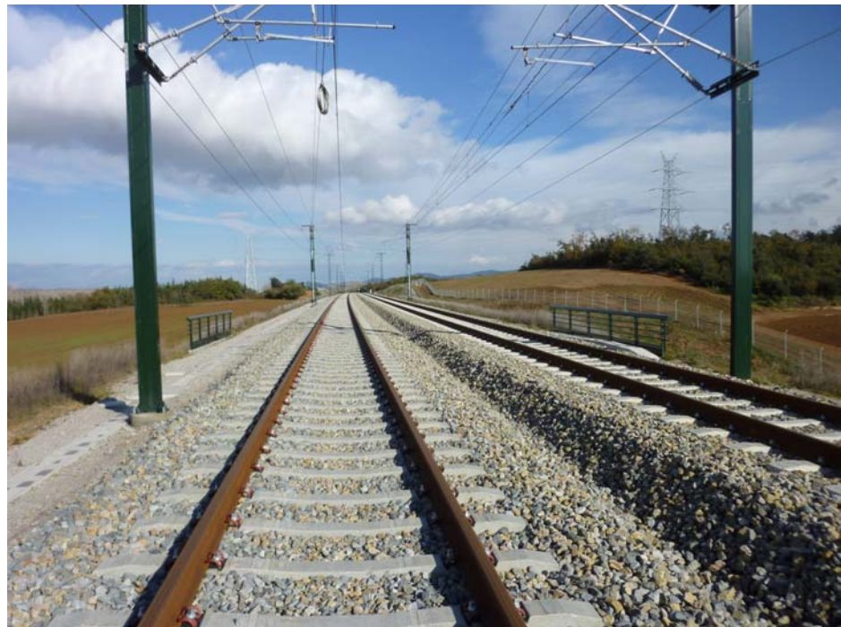
FOTOGRAFIA N° 1: Vista Superior del tablero dirección Figueres
