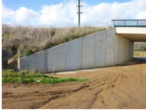
Fotografía nº 5. Estribo de entrada
