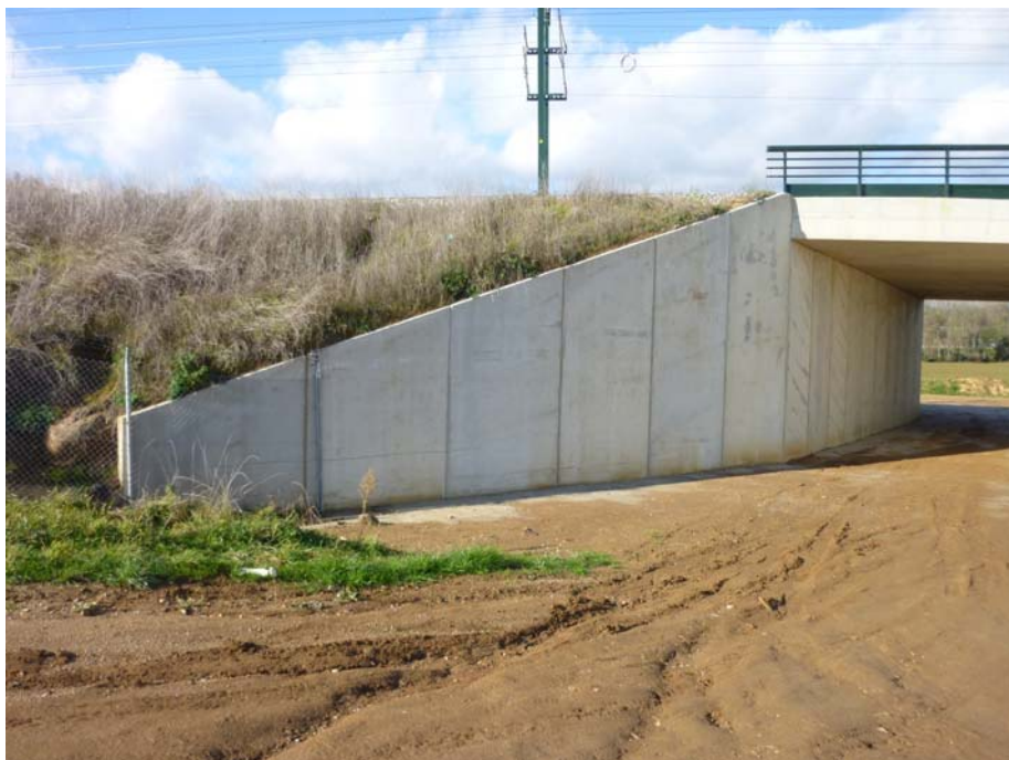
FOTOGRAFIA N° 10: Vista del estribo de entrada
