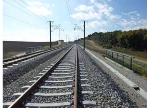
Fotografía nº 6. Estribo de salida
