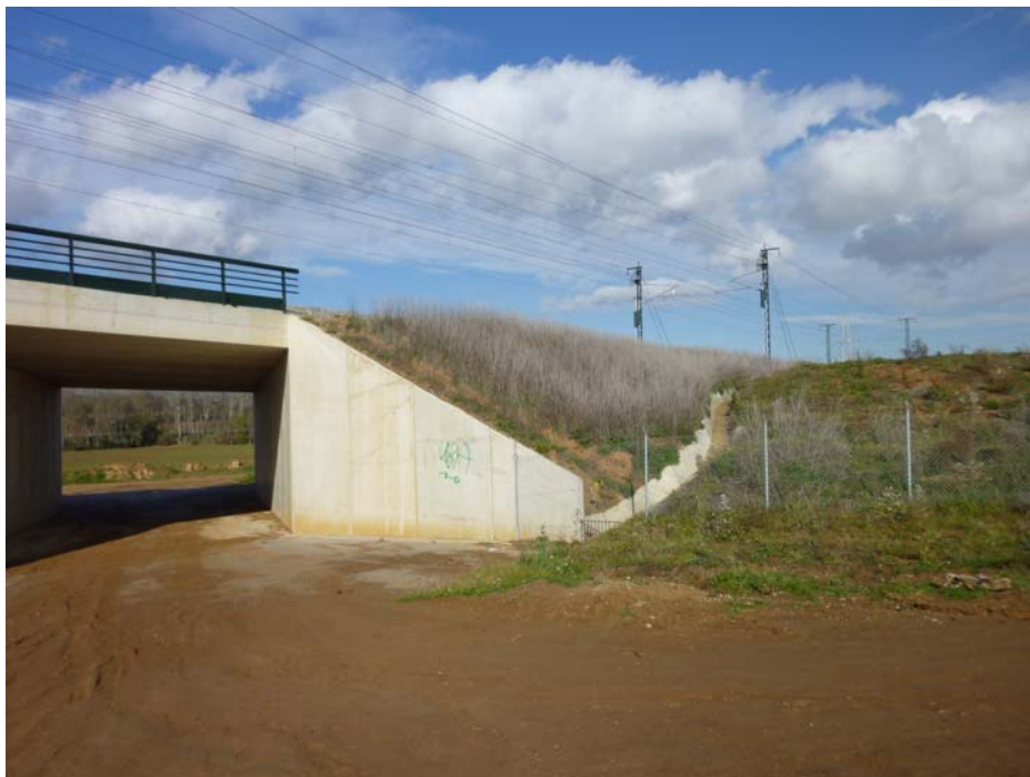
FOTOGRAFIA N° 11: Vista del estribo de salida
