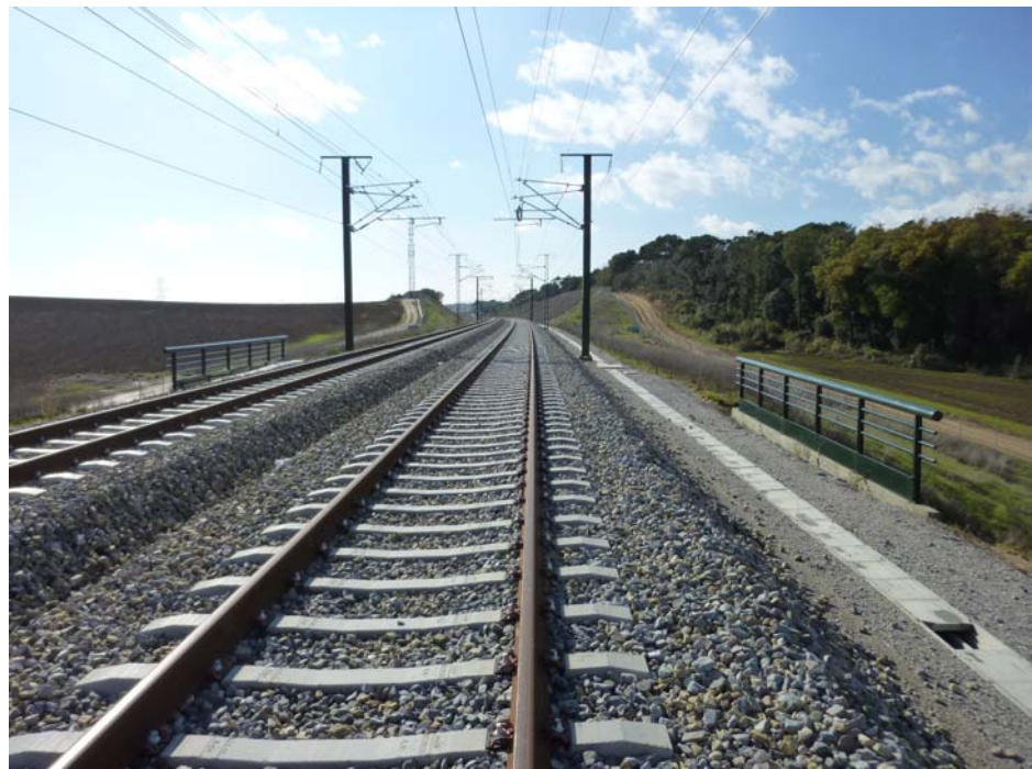
FOTOGRAFIA N° 2: Vista superior del tablero dirección Barcelona
