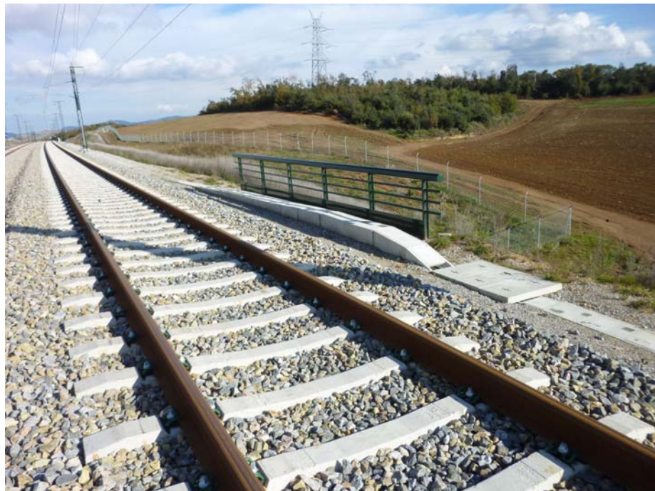
FOTOGRAFIA N° 8: Vista del lado derecho de la plataforma
