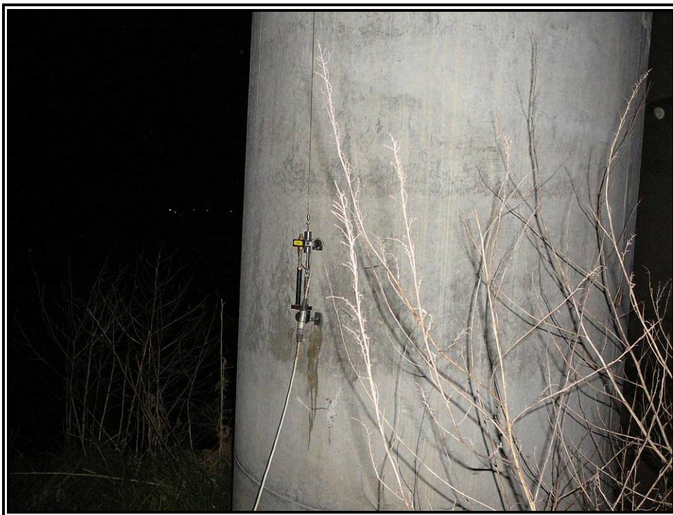
Nº 4.- LVDT colocado en apoyo.
