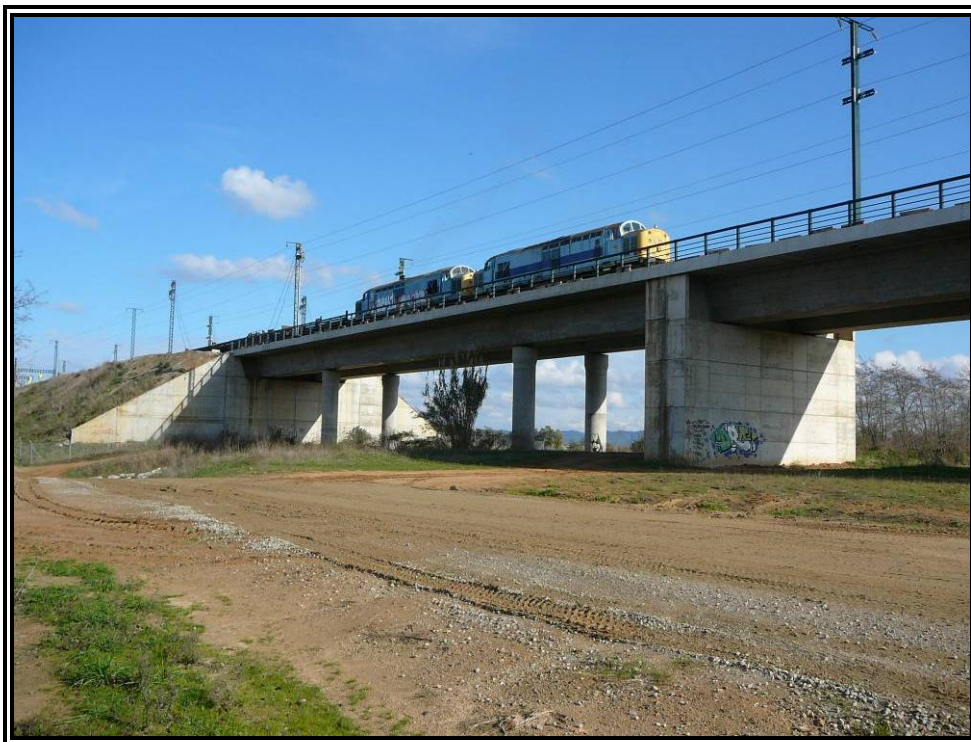
Nº 2.- Alzado izquierdo de la estructura.
