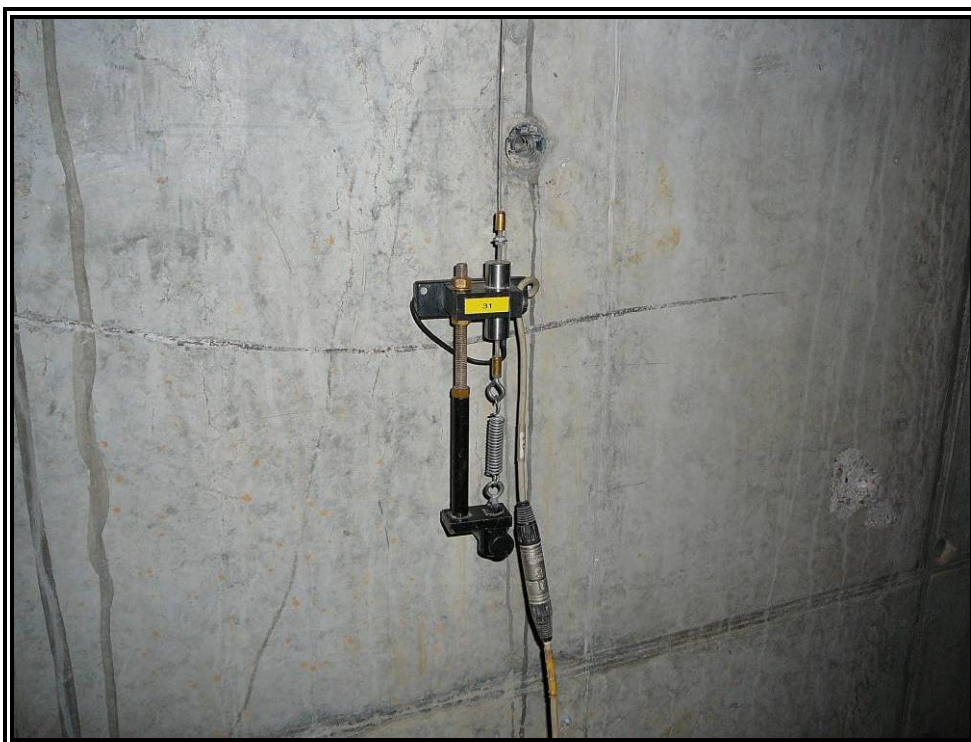
Nº 4.- LVDT colocado en apoyo.
