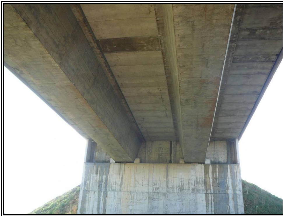
Nº 3.- Vista inferior de la estructura.
