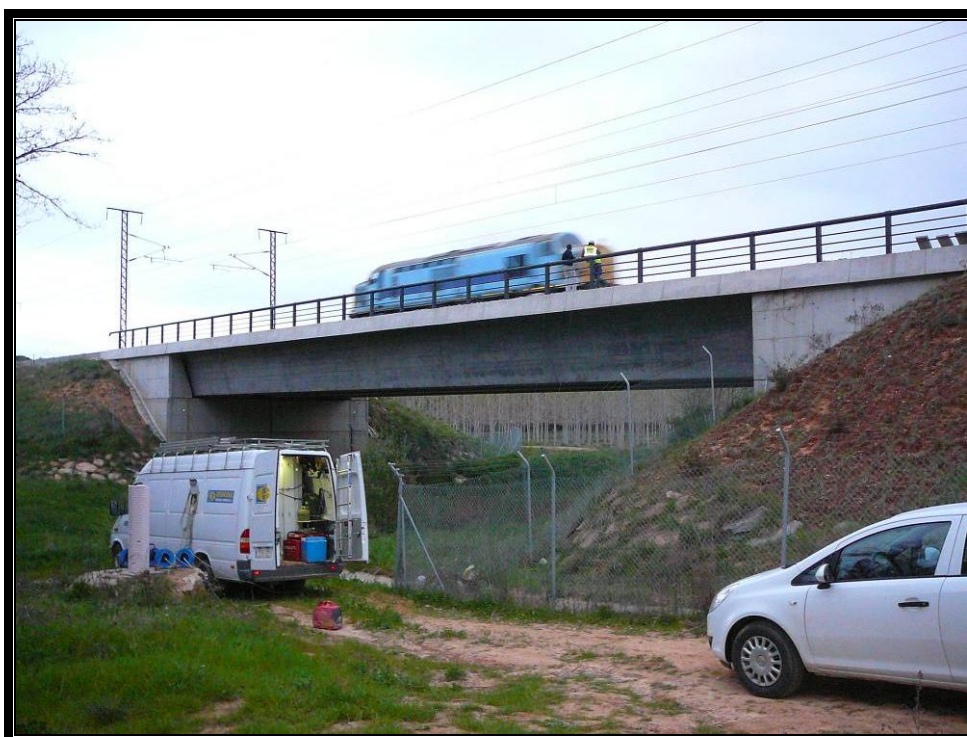
Nº 4.- Realización de prueba dinámica.
