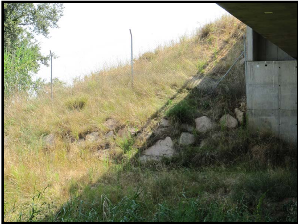
13. Protecciones de escollera en estribo 1.
