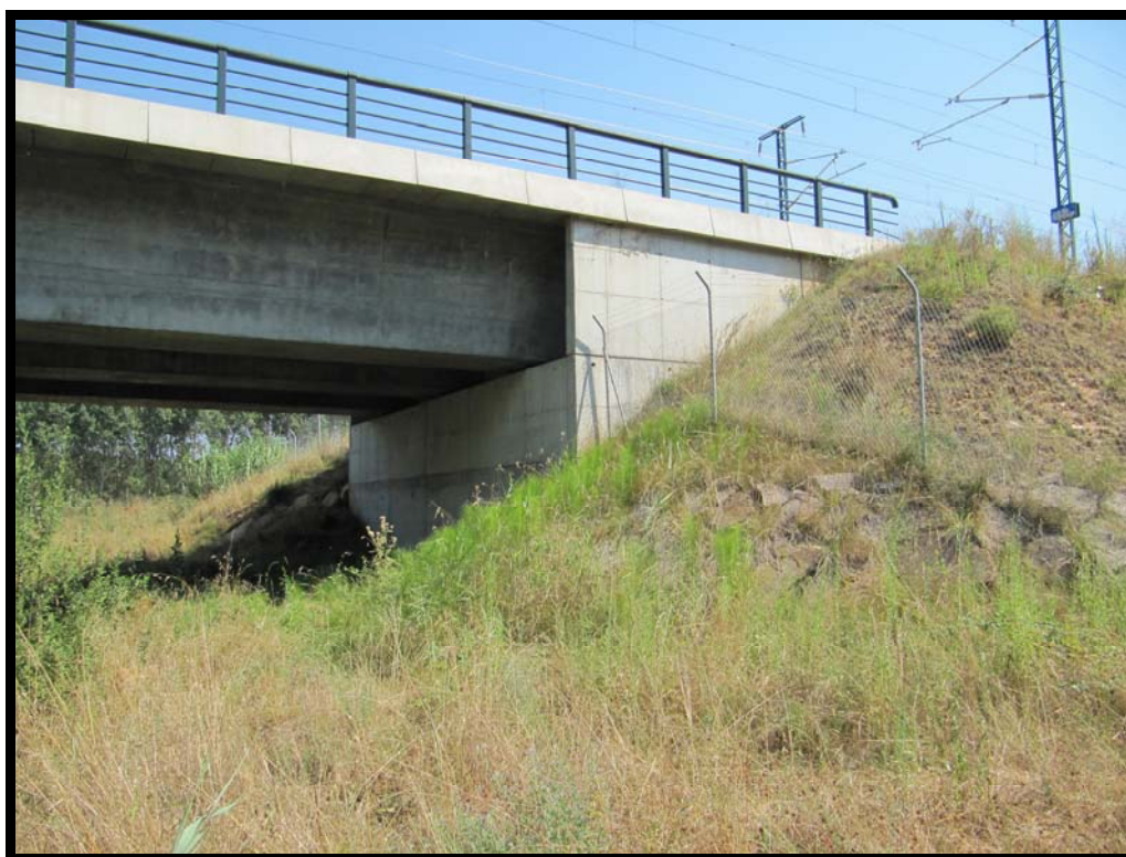
3. Estribo de entrada.
