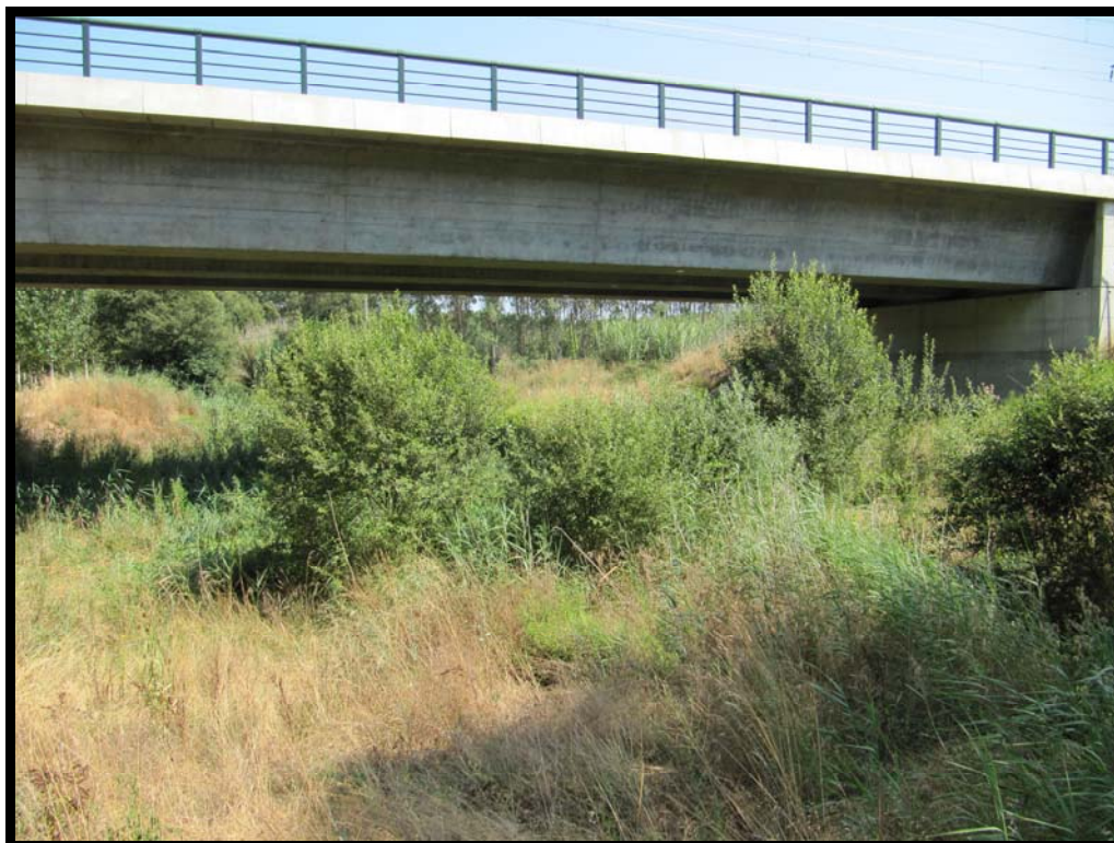
15. Vegetación bajo la estructura.
