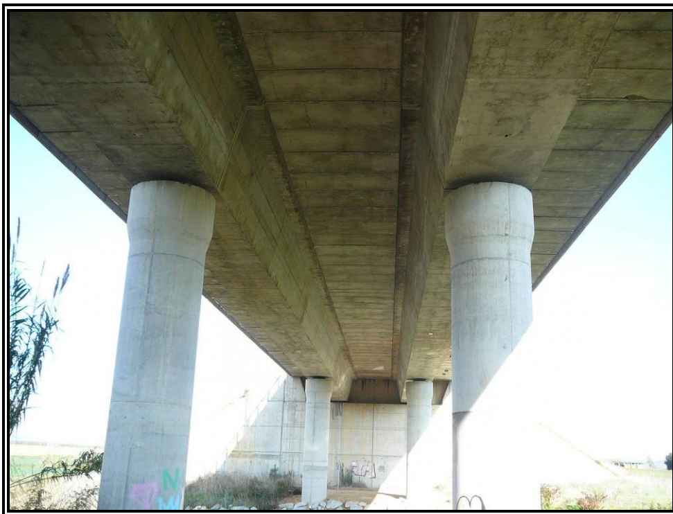
Nº 3.- Vista inferior de la estructura.
