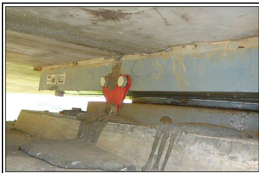
Elemento de sujeción de montaje de POT sin retirar.
