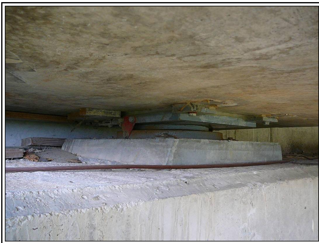
Apoyo derecho de estribo uno
