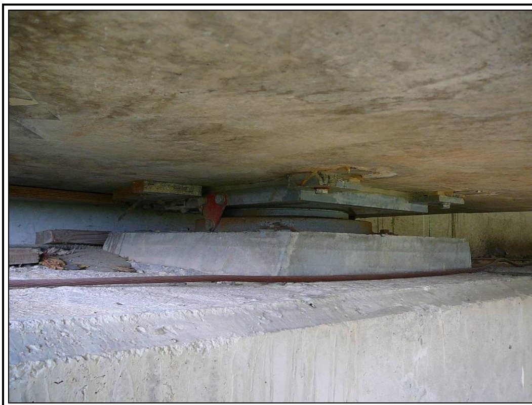
Apoyo derecho de estribo uno
