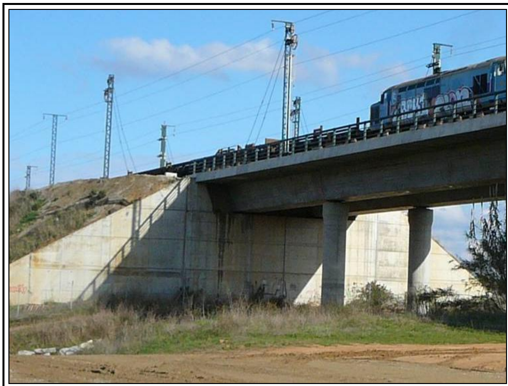
Estribo de entrada
