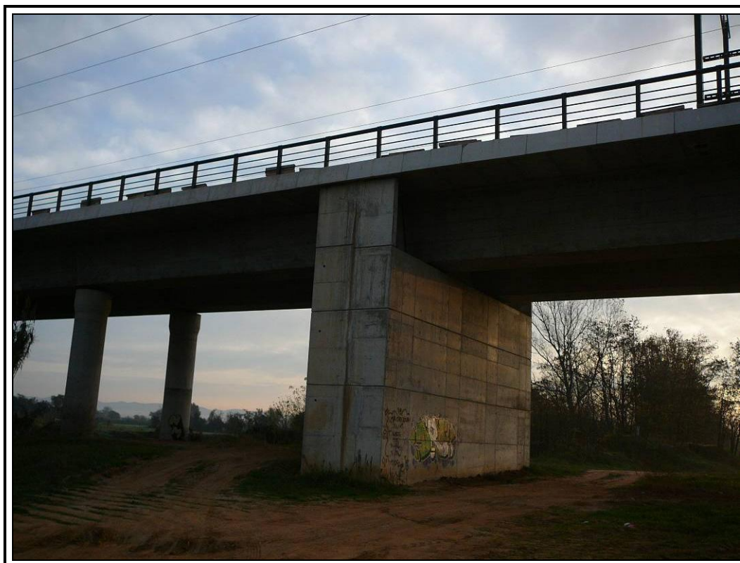
Estribo-Pila de entrada (conexión con Vto.711+200)
