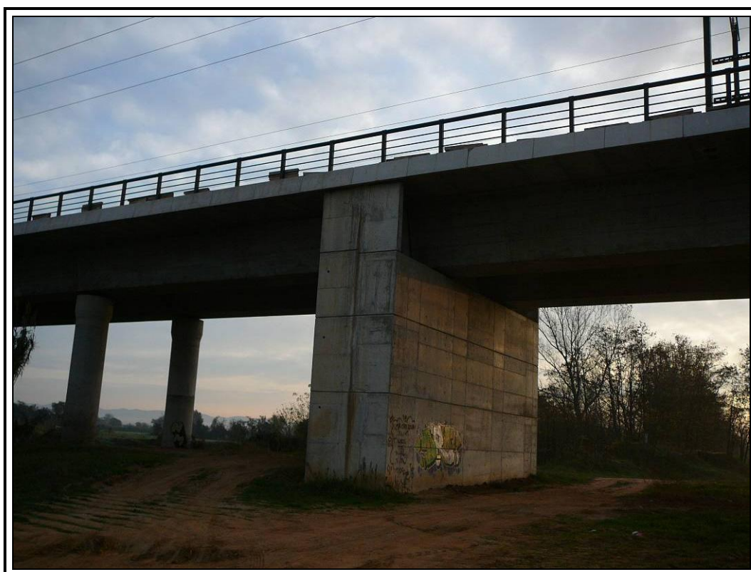
Estribo-Pila de entrada (conexión con Vto.711+200)
