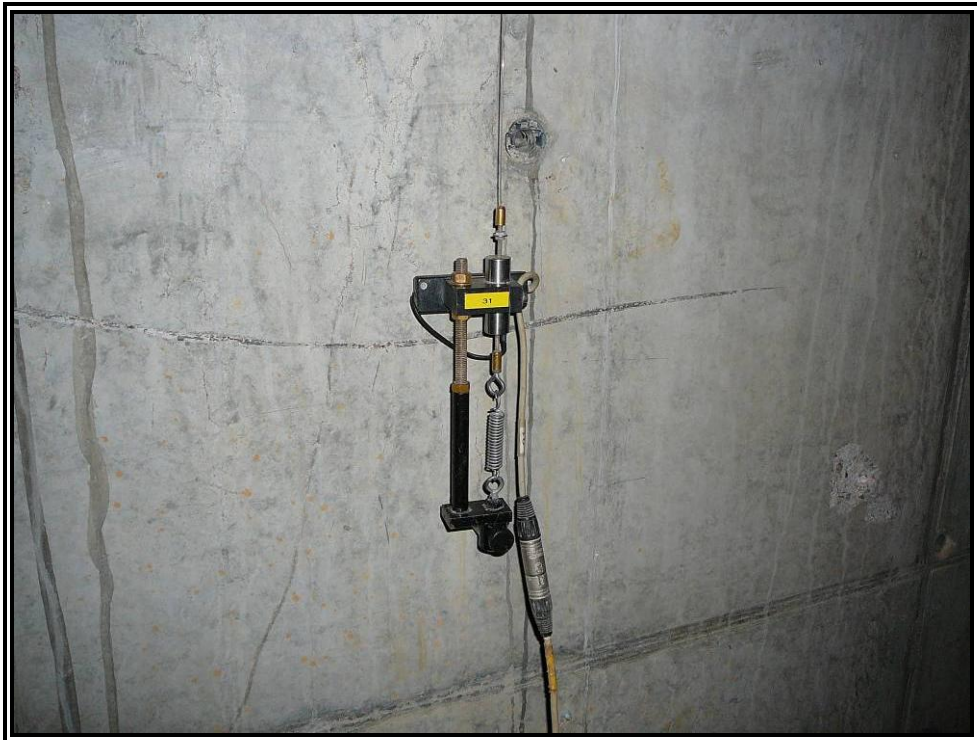
Nº 4.- LVDT colocado en apoyo.
