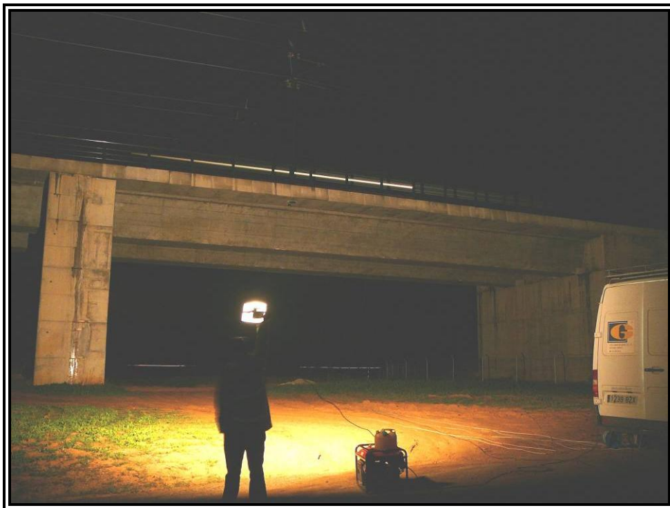
Nº 6.- Realización de prueba dinámica.
