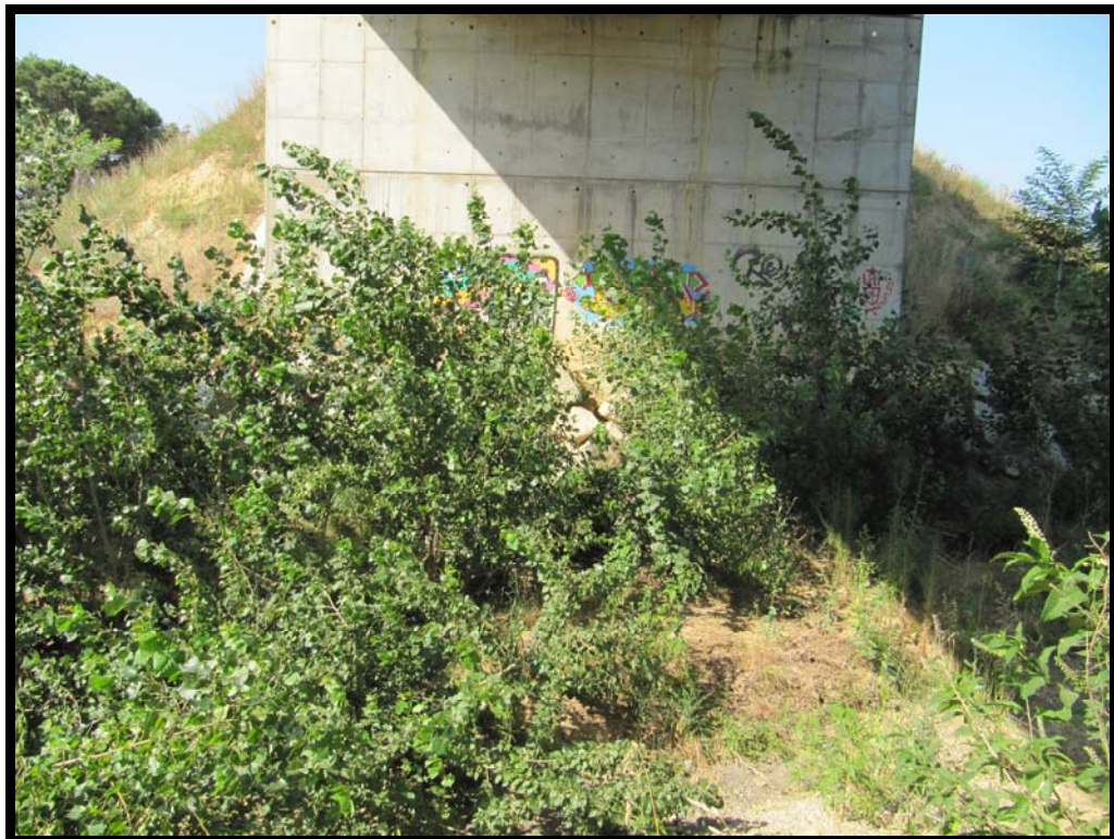
14. Escollera de protección en la base del estribo de salida.
