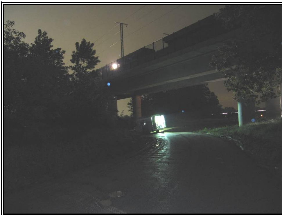
Nº 17.- Prueba estática Estado Nº 6 (Carga en vanos Nº 5 y Nº 6).
