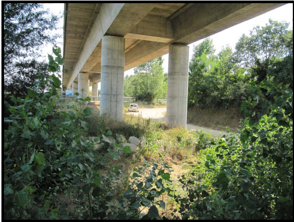
13. Escollera de protección en base de pila 5.
