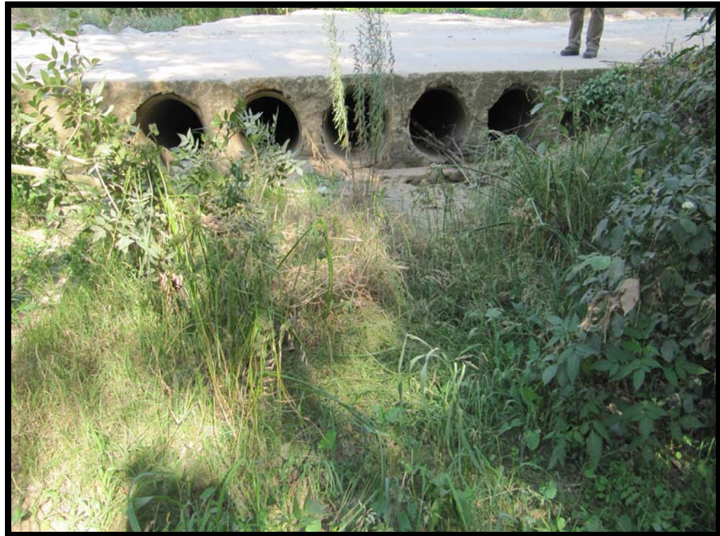
18. Pequeña obra de paso sobre el cauce, aguas arriba.
