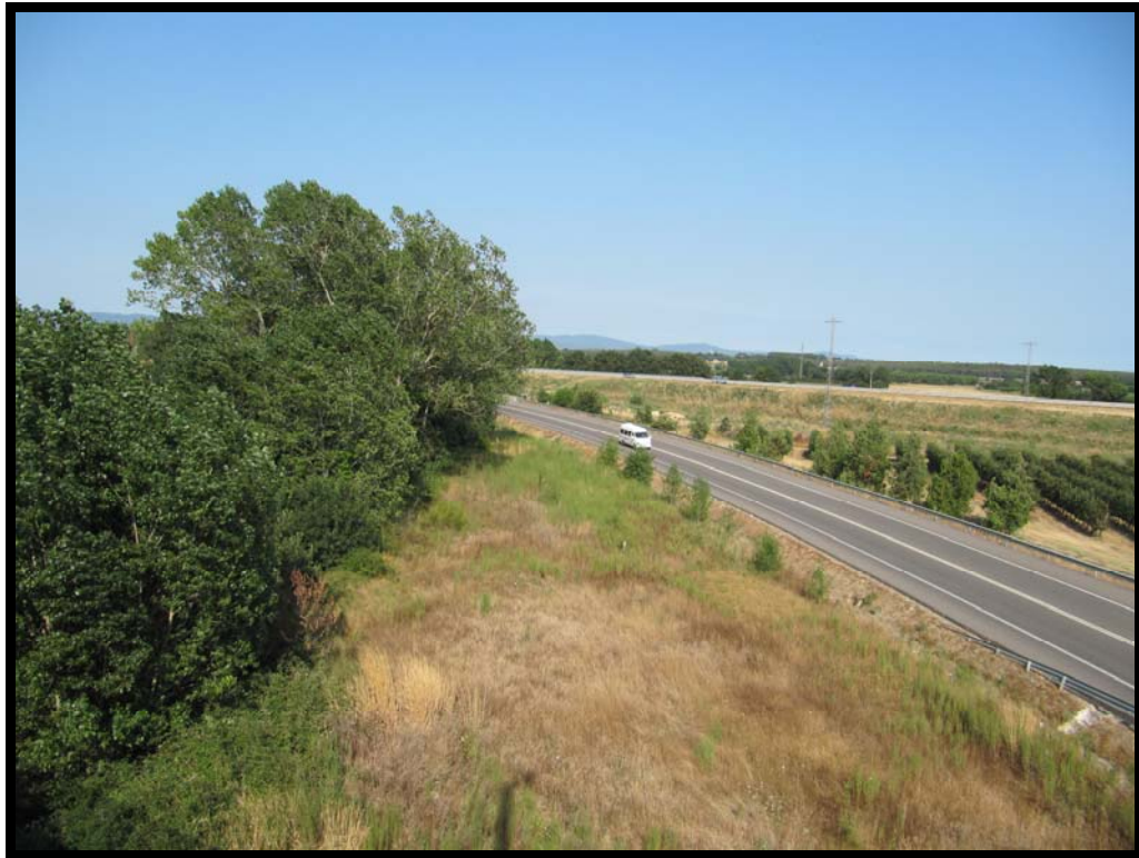
9. Llanura de inundación derecha aguas abajo.
