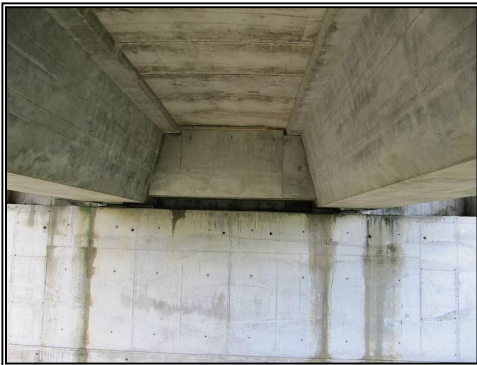
Nº 7.- Detalle de estribo.
