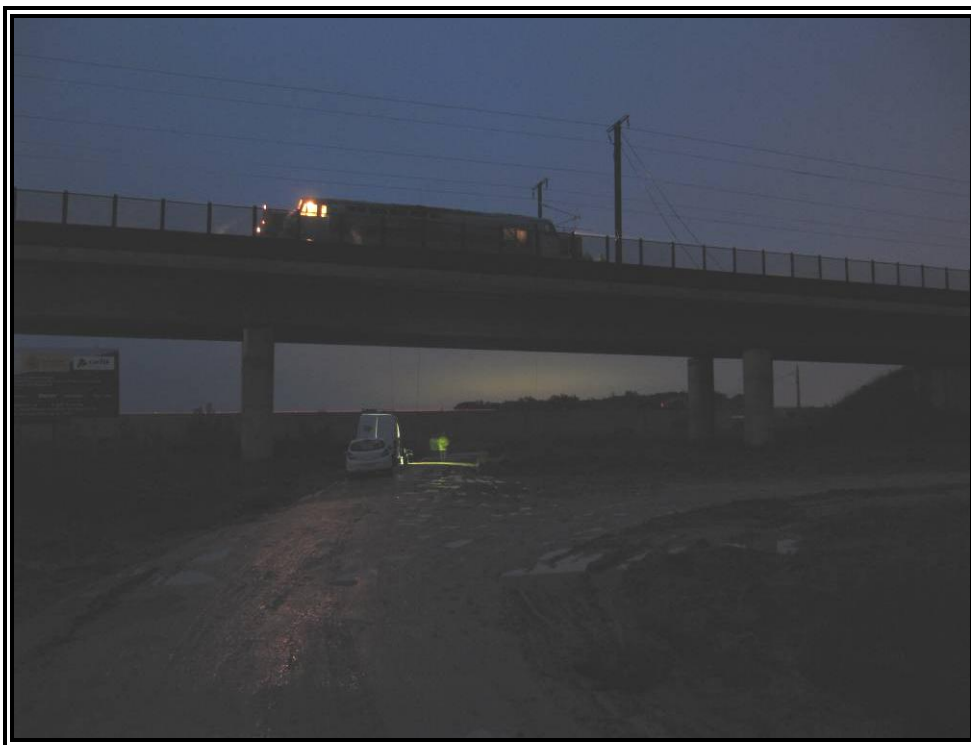
Nº 13.- Prueba estática Estado Nº 2 (Carga en vano Nº 2).
