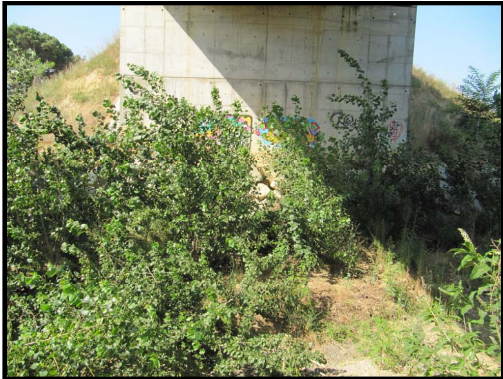
5. Estribo de salida.
