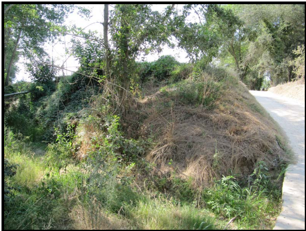
10. Margen izquierdo del cauce aguas arriba.
