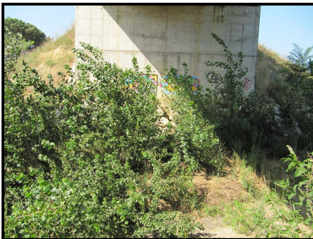
5. Estribo de salida.
