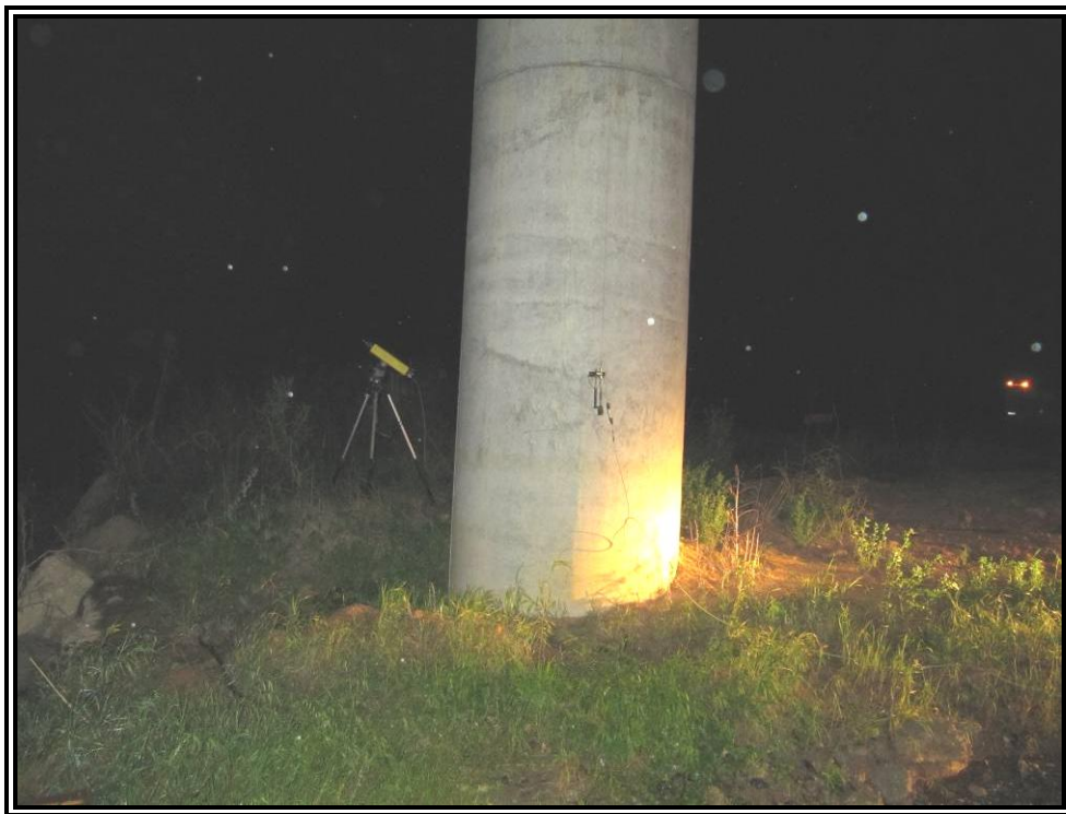
Nº 9.- Laser instalado para lectura del vano Nº 6.
