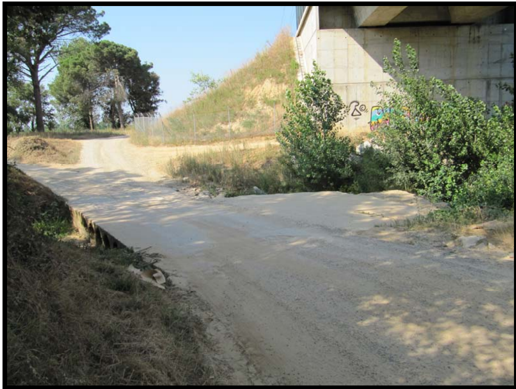
17. Camino paralelo a la estructura, aguas arriba.
