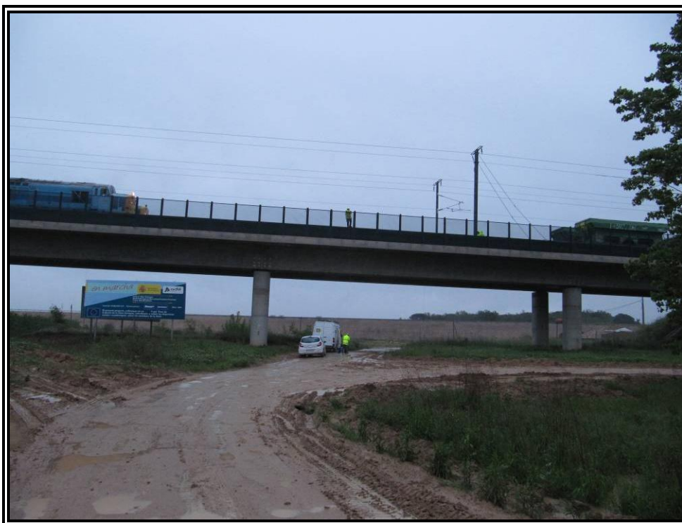
Nº 12.- Prueba estática Estado Nº 1 (Carga en vanos Nº 1 y Nº 3).
