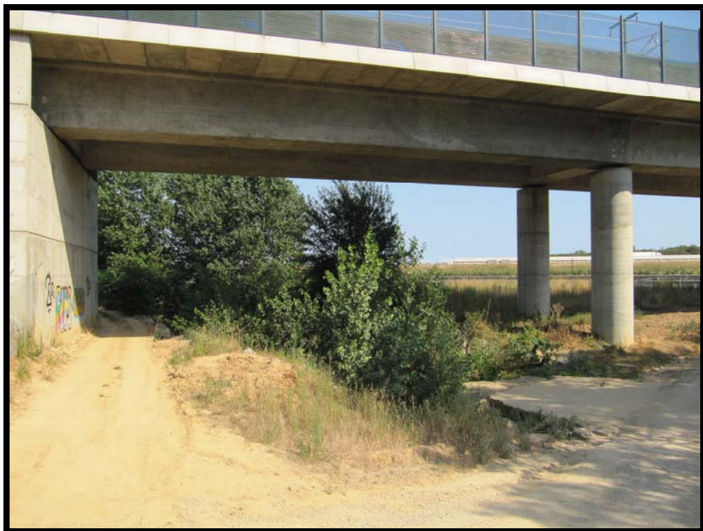
20. Vegetación arbórea en las márgenes del cauce, bajo la estructura.
