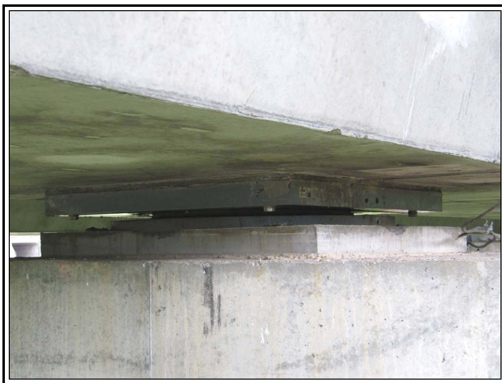
Apoyo izquierdo de pila dos
