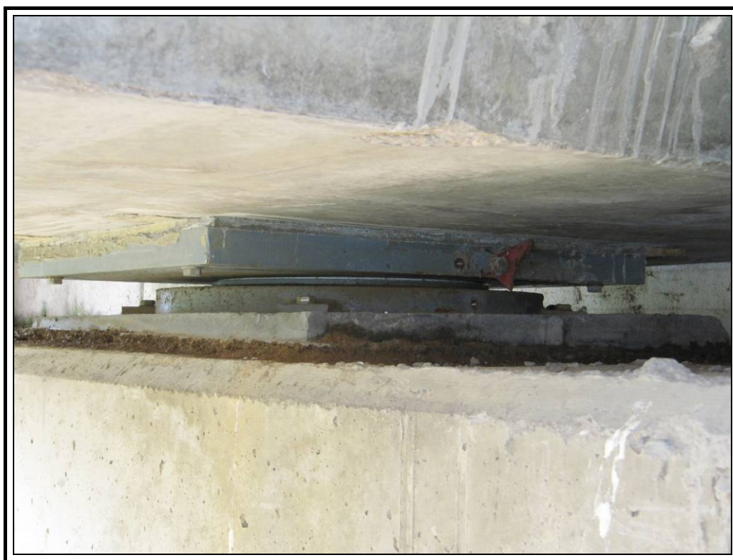
Apoyo izquierdo de estribo dos
