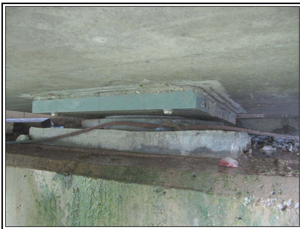
Apoyo izquierdo de estribo uno
