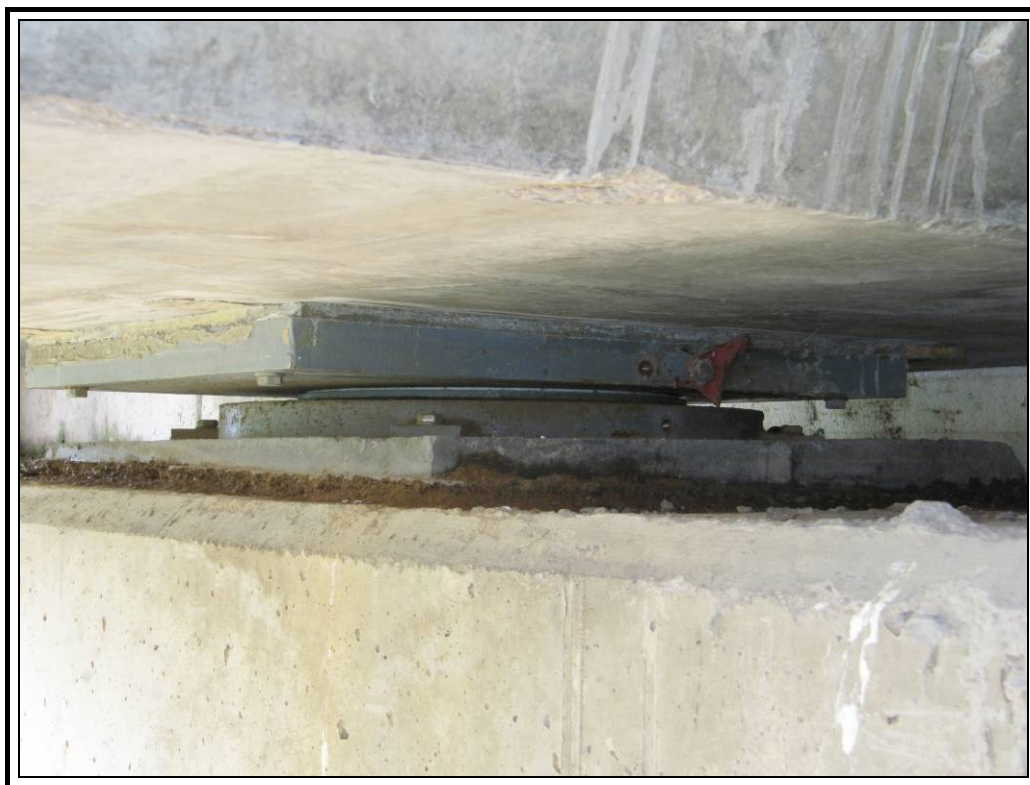
Apoyo izquierdo de estribo dos
