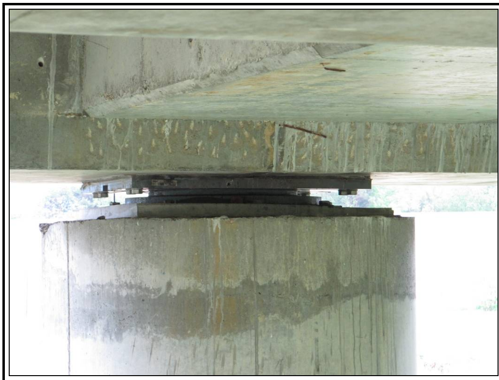
Apoyo derecho pila dos
