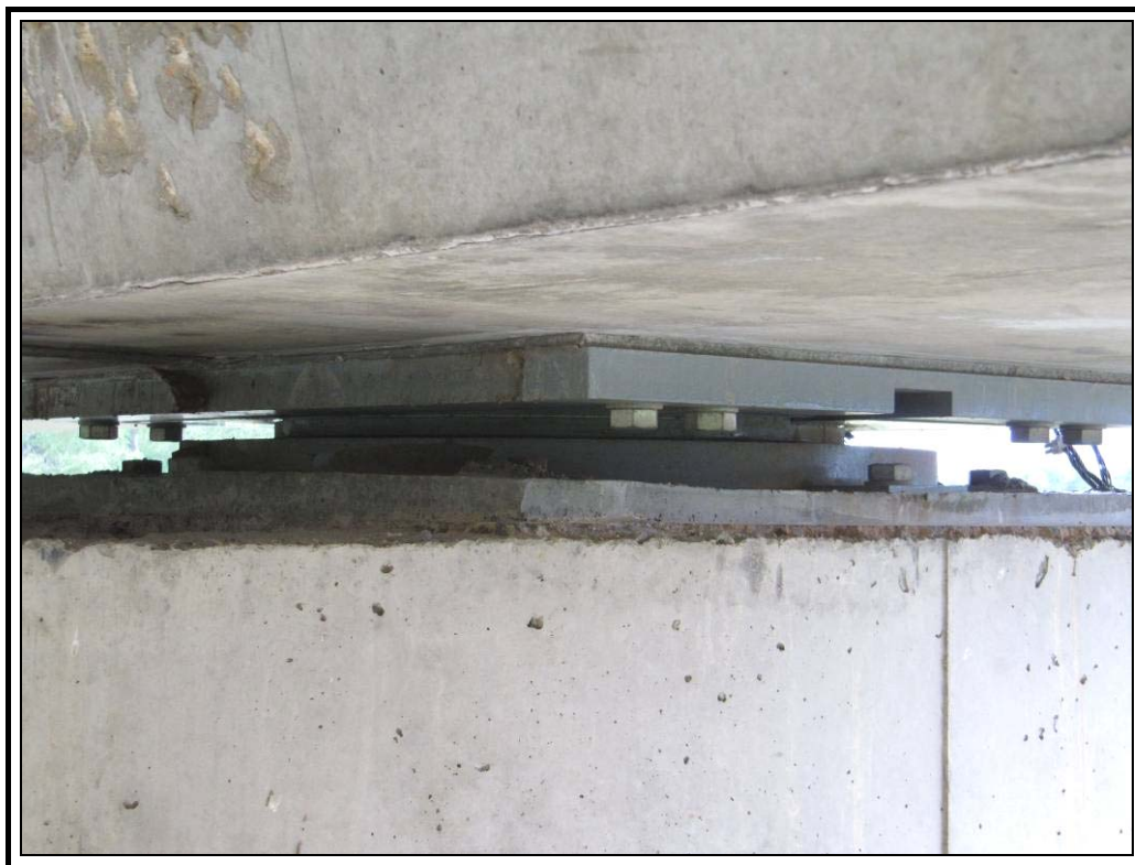
Apoyo derecho pila tres
