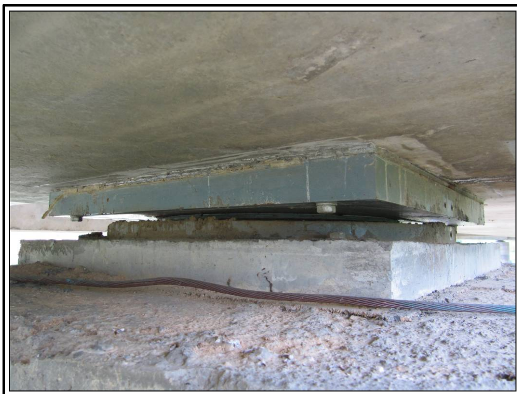
Apoyo derecho pila cinco
