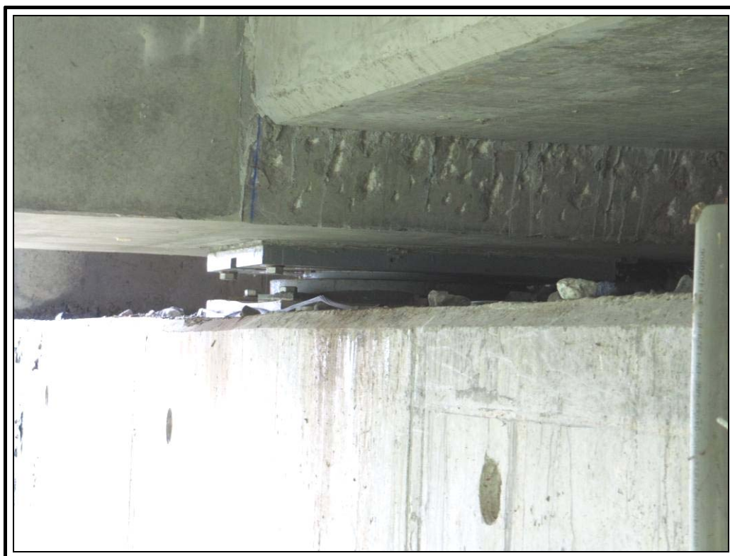
Apoyo derecho de estribo uno
