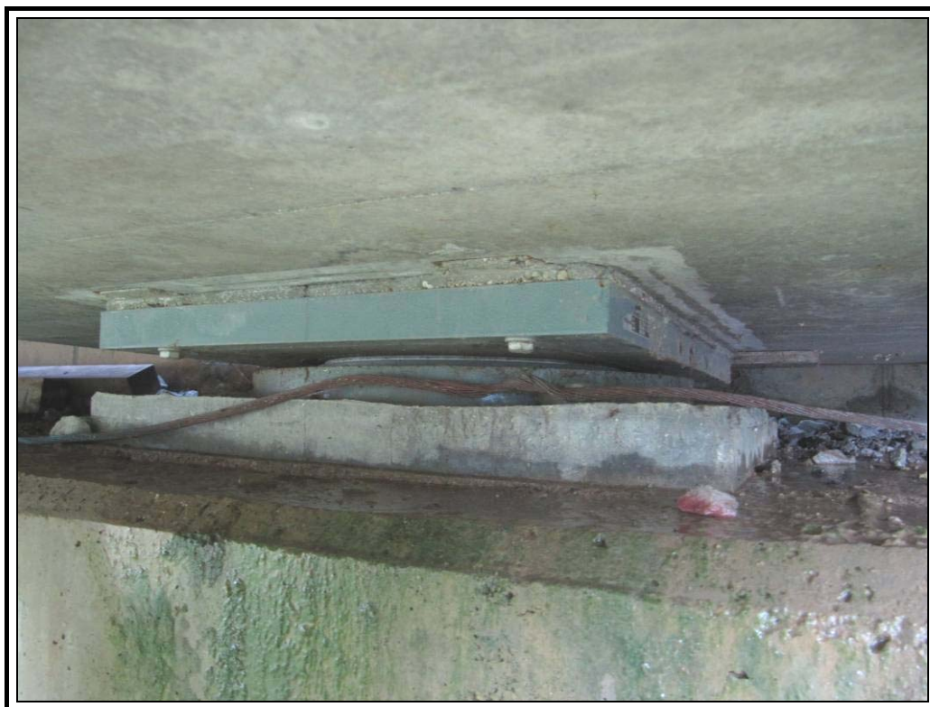
Apoyo izquierdo de estribo uno
