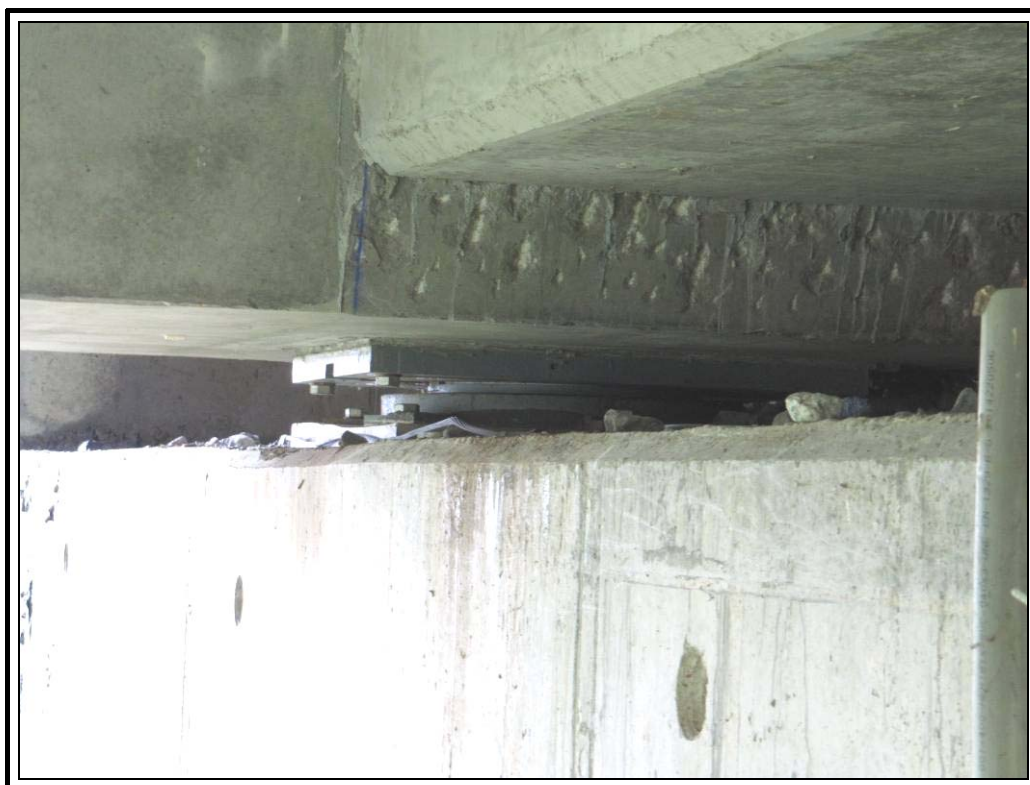
Apoyo derecho de estribo uno
