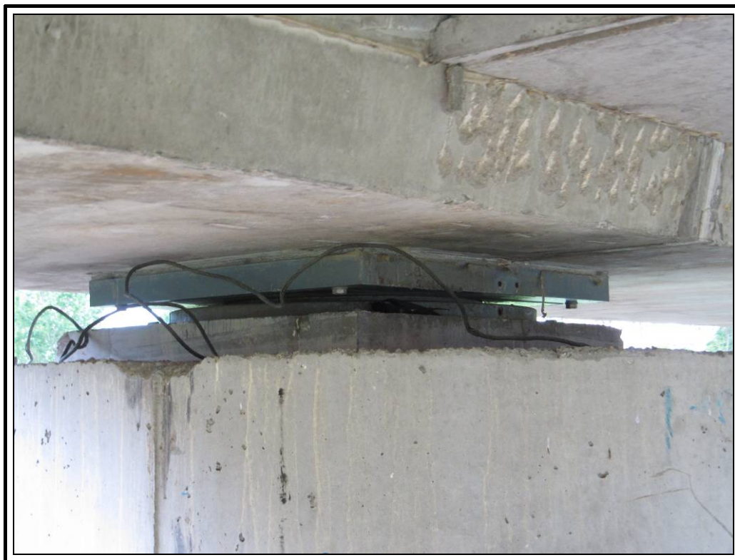
Apoyo izquierdo de pila tres
