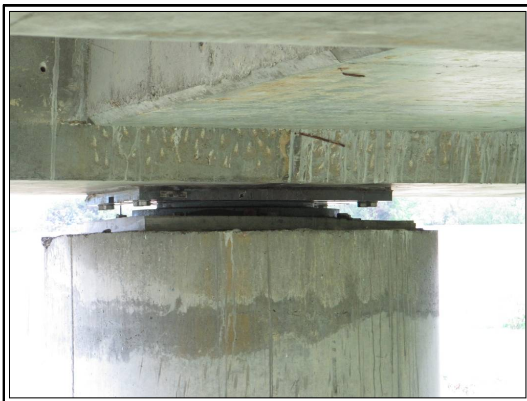
Apoyo derecho pila dos
