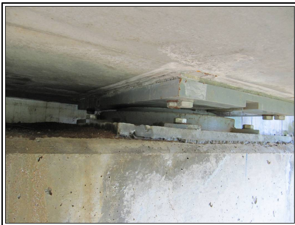
Apoyo derecho de estribo dos
