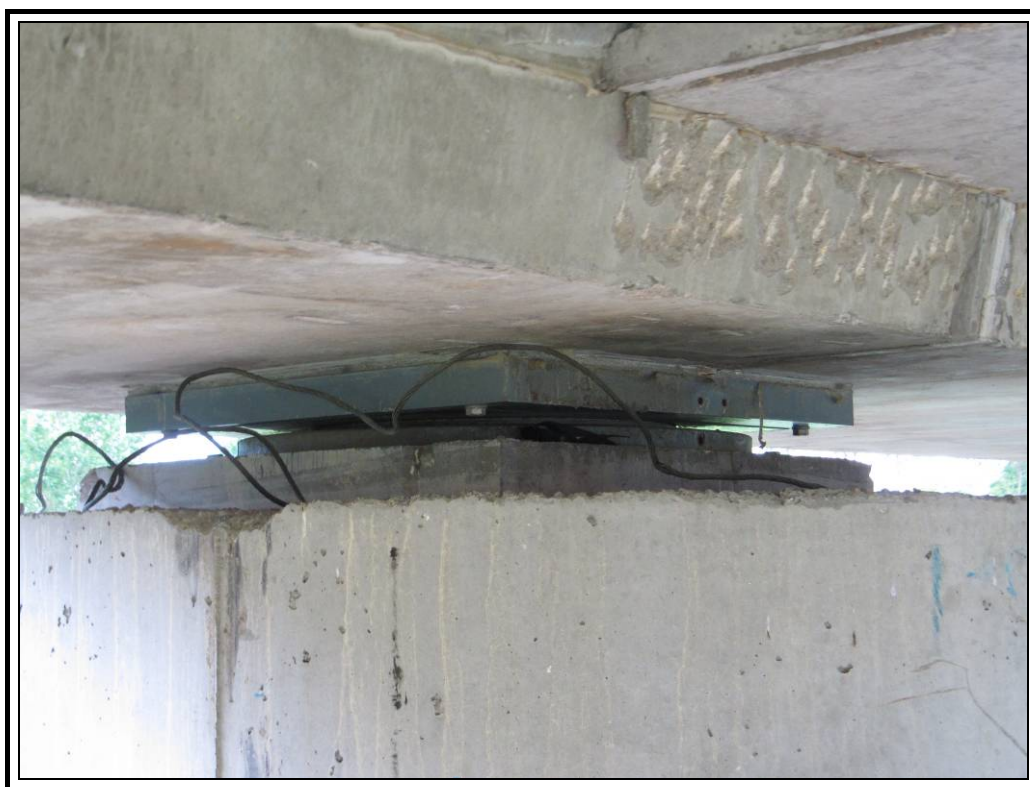
Apoyo izquierdo de pila tres
