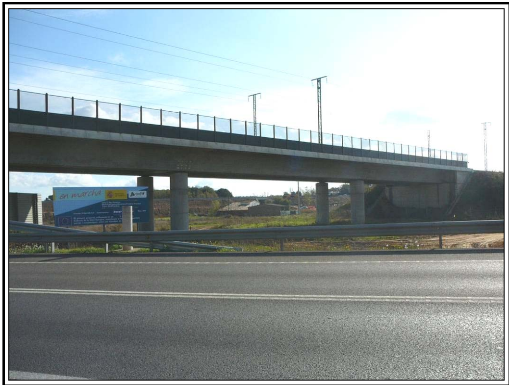
Estribo de salida
