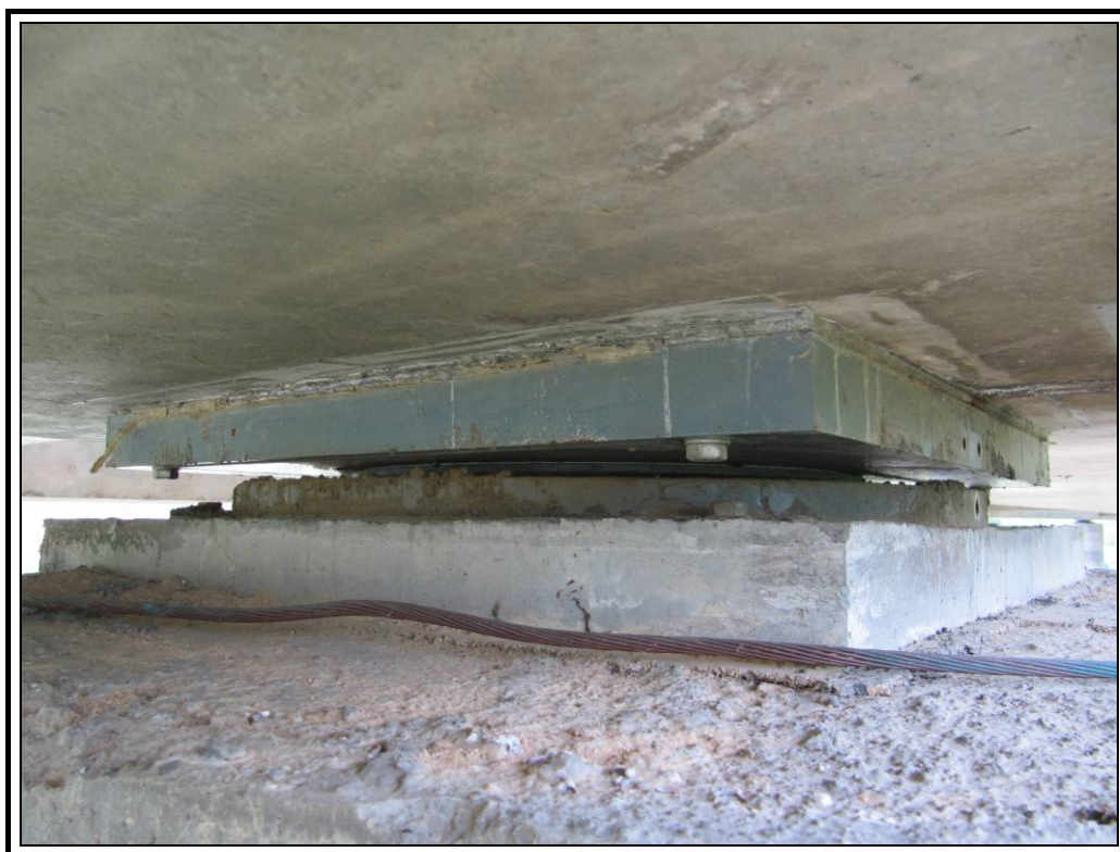
Apoyo derecho pila cinco
