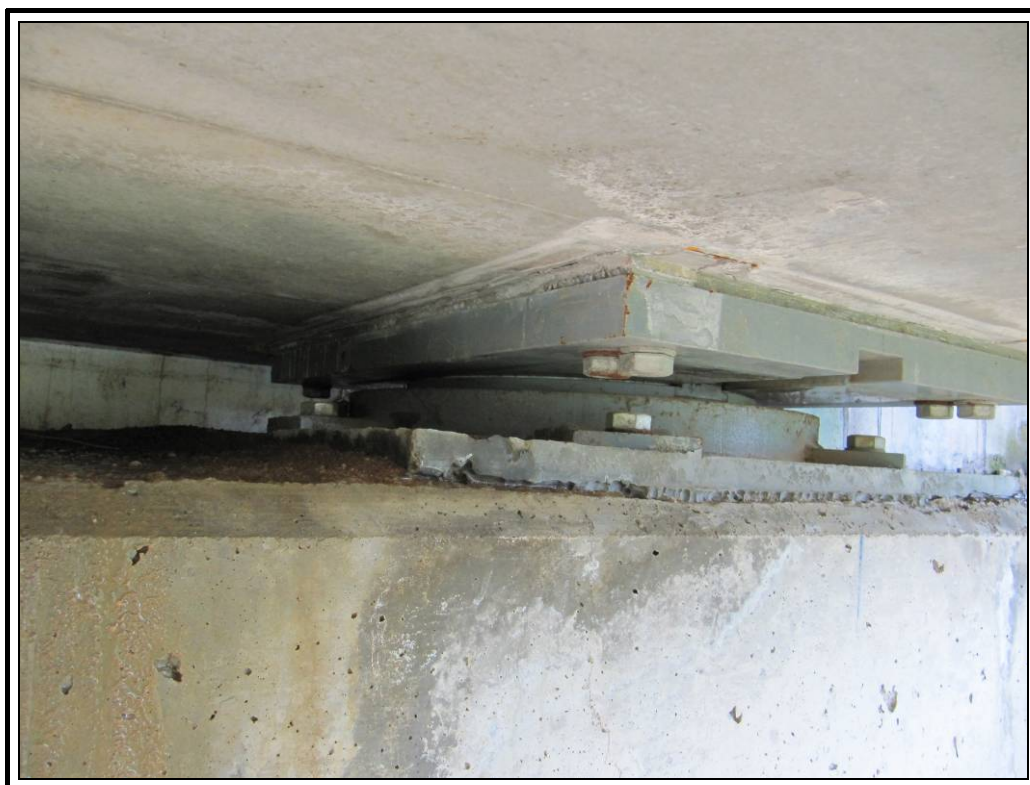
Apoyo derecho de estribo dos
