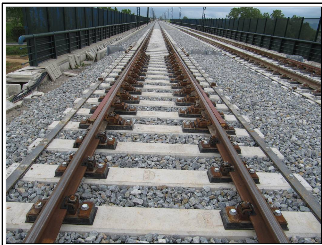
Material de vía (aparato de dilatación)
