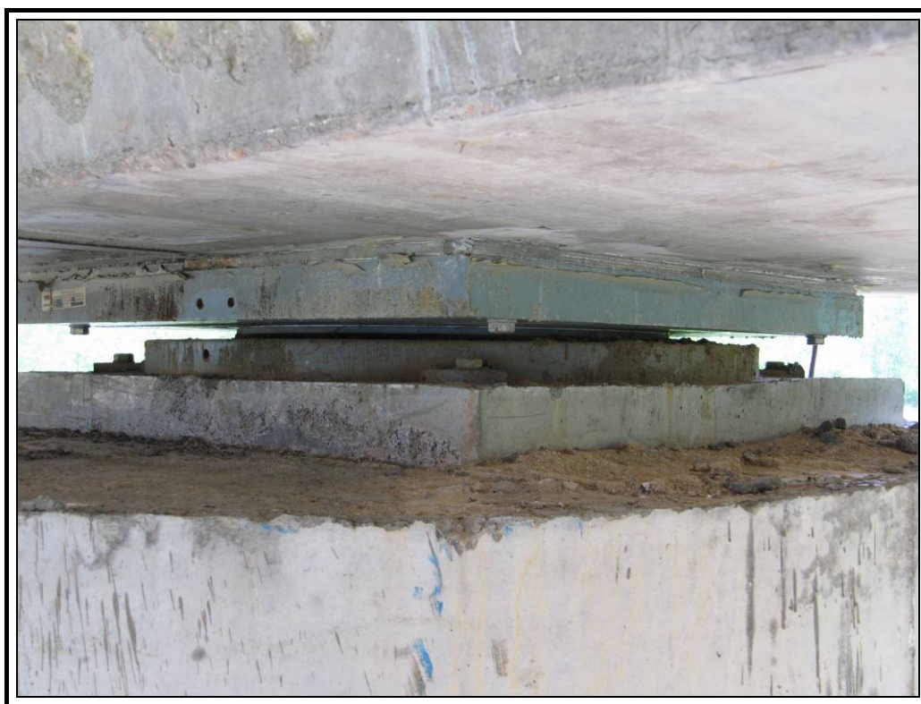
Apoyo izquierdo de pila cuatro
