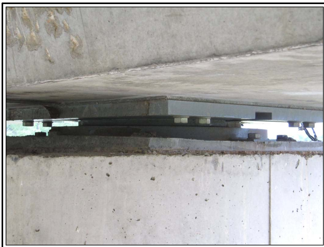
Apoyo derecho pila tres
