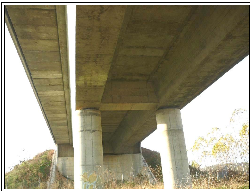
Estribo de entrada
