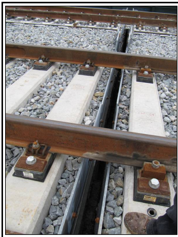
Material de vía (junta de dilatación)
