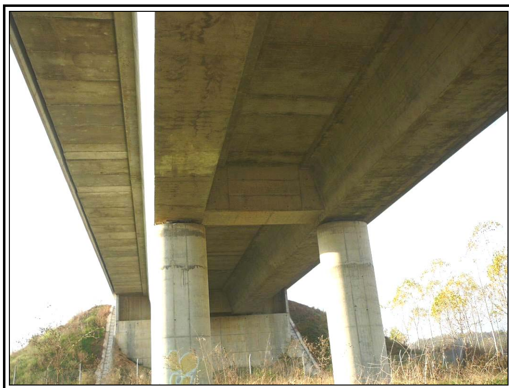
Estribo de entrada
