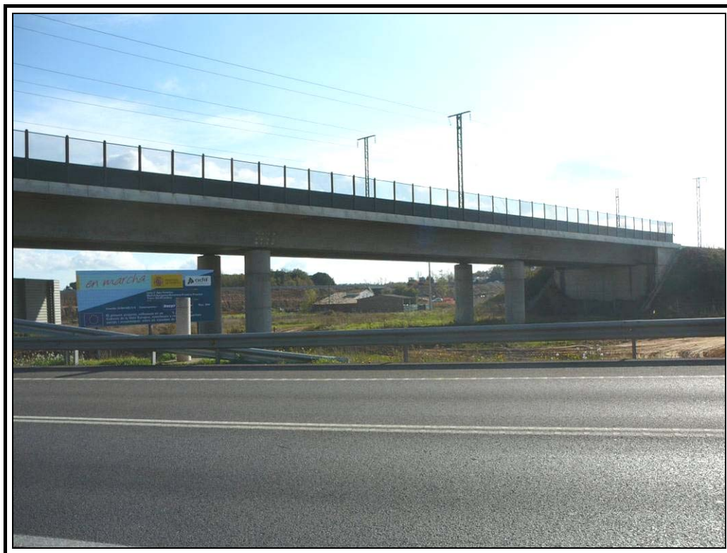
Estribo de salida
