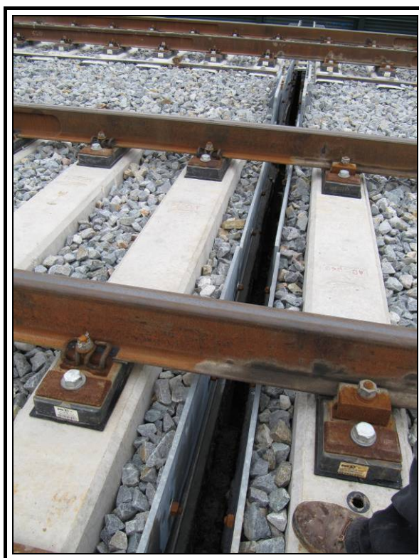
Material de vía (junta de dilatación)
