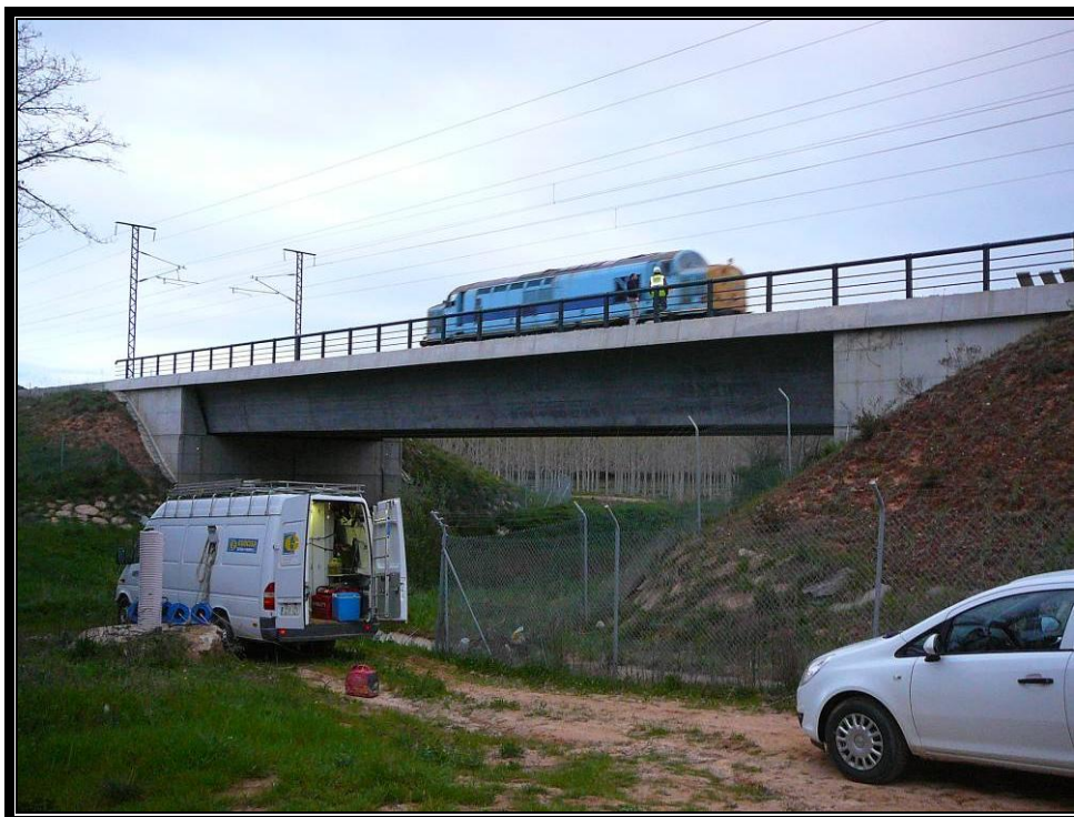
Nº 1.- Vista general de la estructura.
