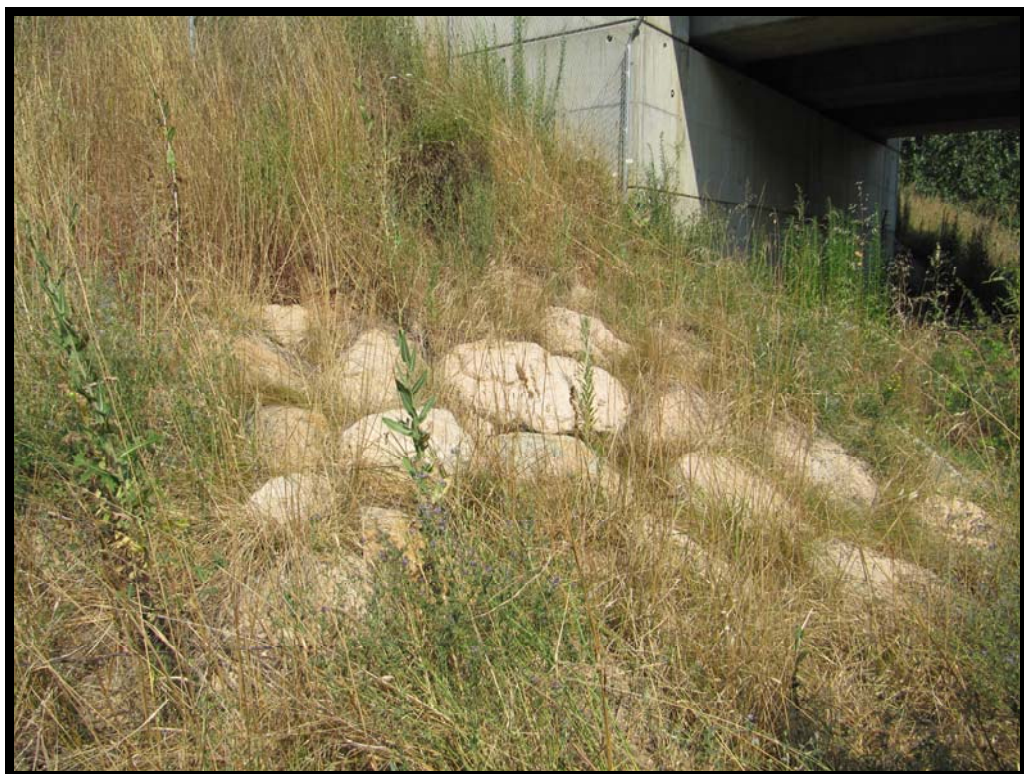
14. Protecciones de escollera en estribo 2.
