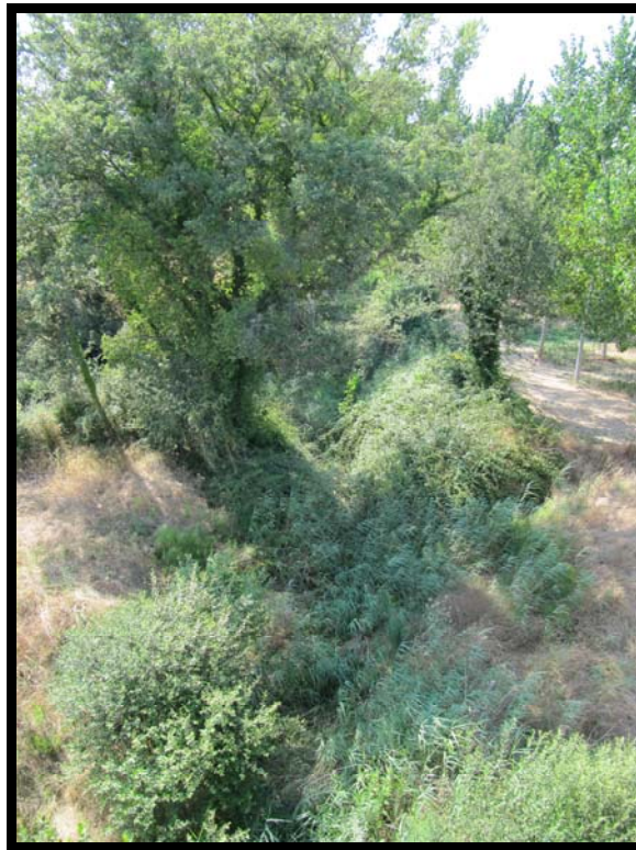
10. Cauce y márgenes aguas arriba.
