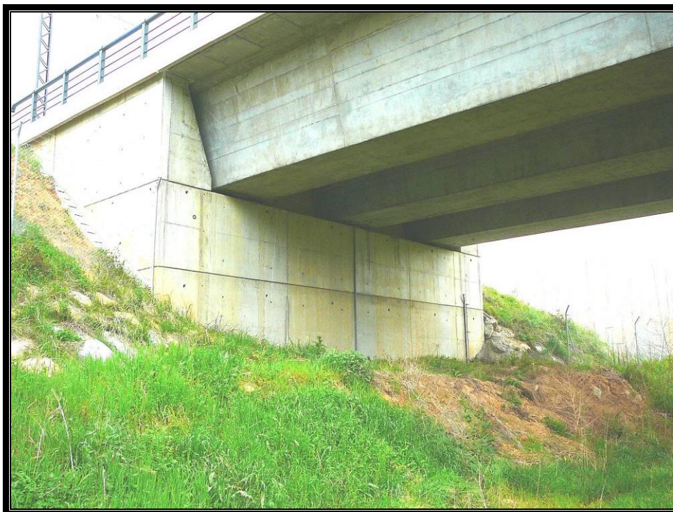
Nº 2.- Vista inferior de la estructura.
