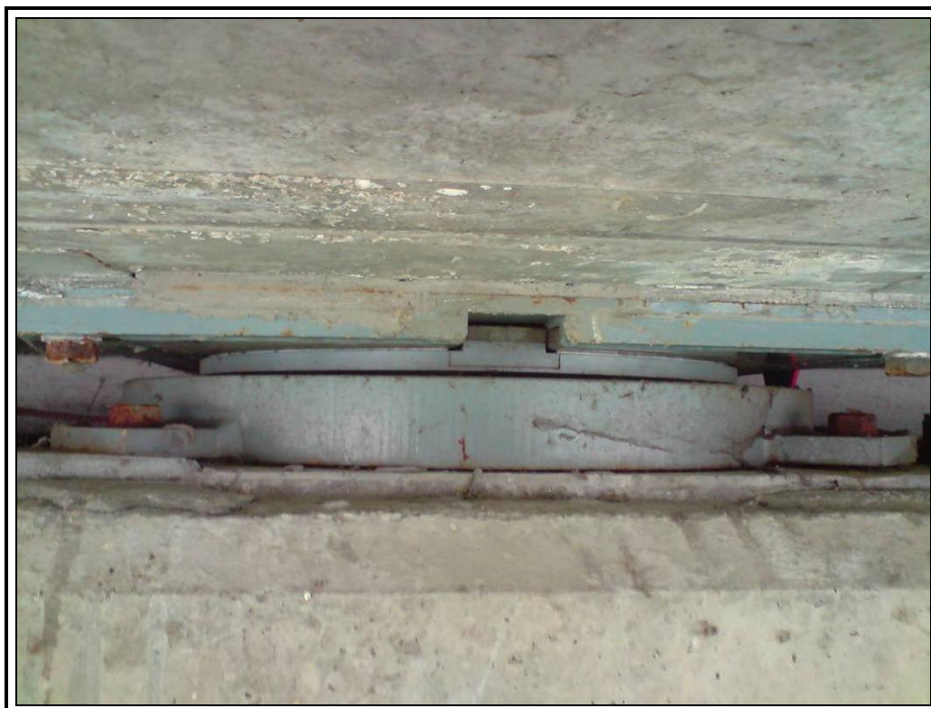
Apoyo izquierdo de estribo uno.
