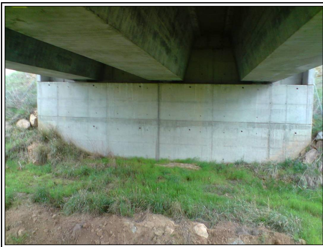
Estribo de entrada
