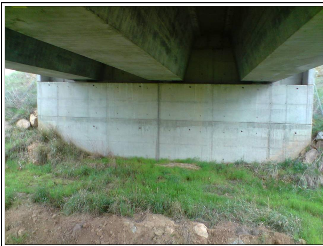
Estribo de entrada
