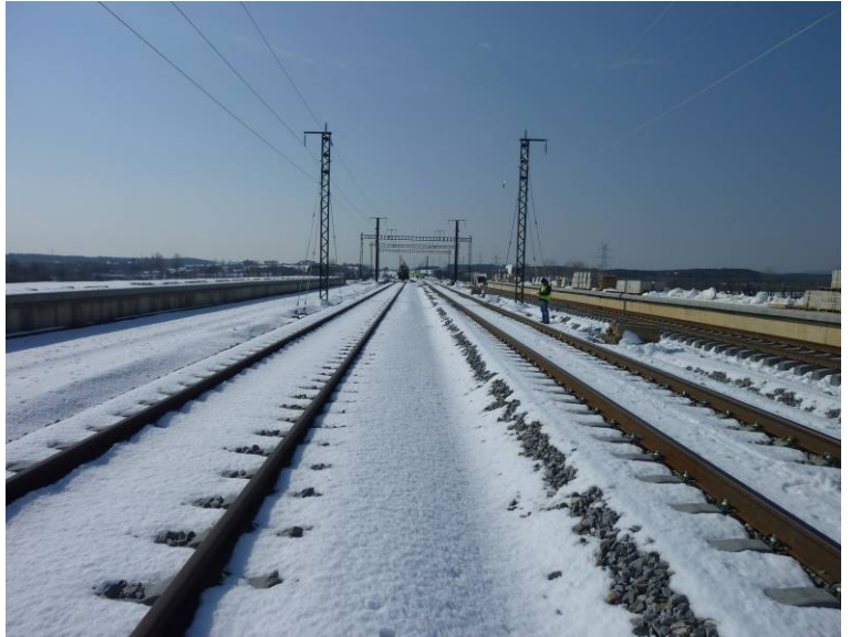
Fotografía N°7: Vista desde el estribo 2.
