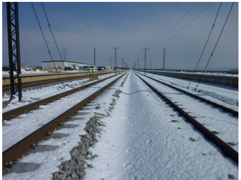
Fotografía N°6: Vista desde el estribo 1.
