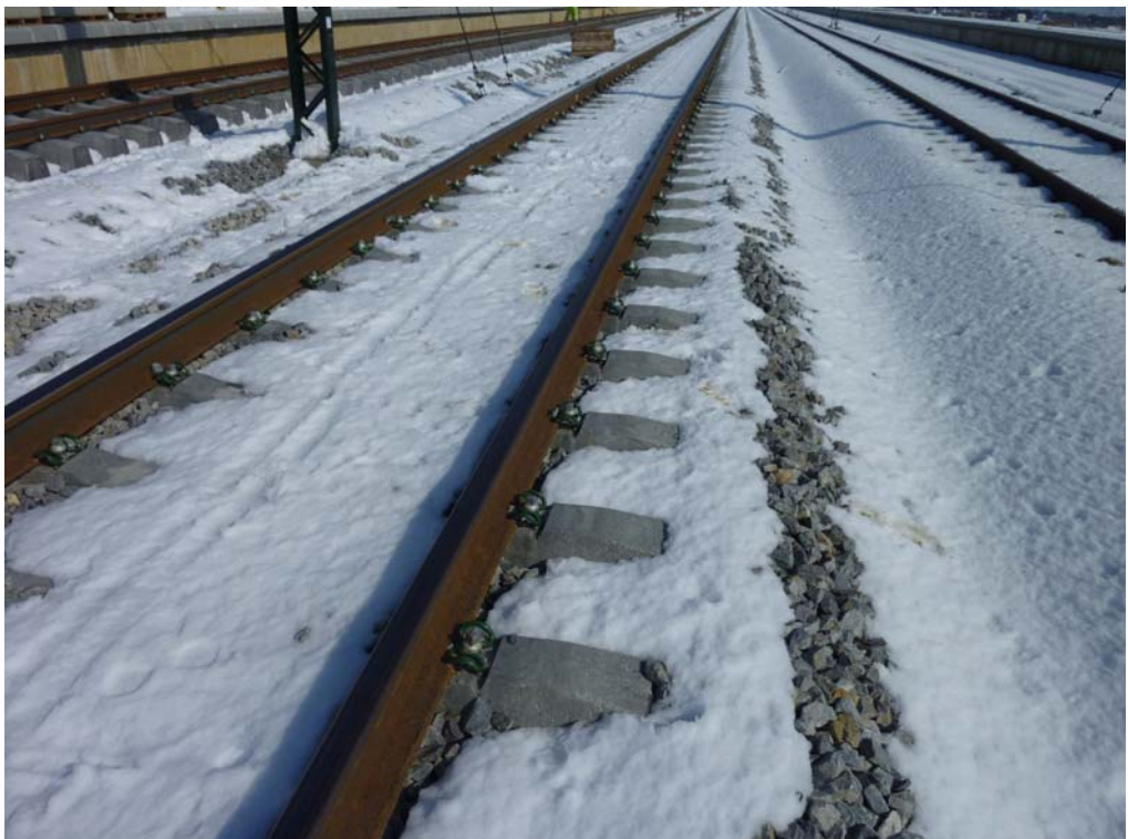
Fotografía 366: Material de vía
