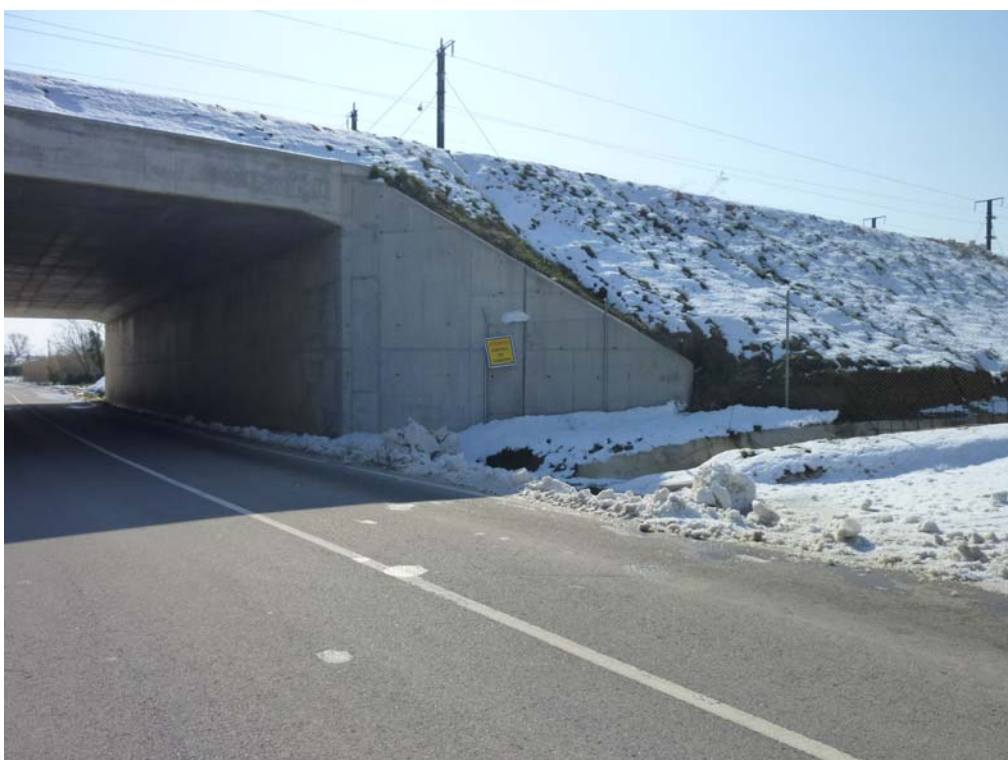
Fotografía 346: Vista estribo de entrada
