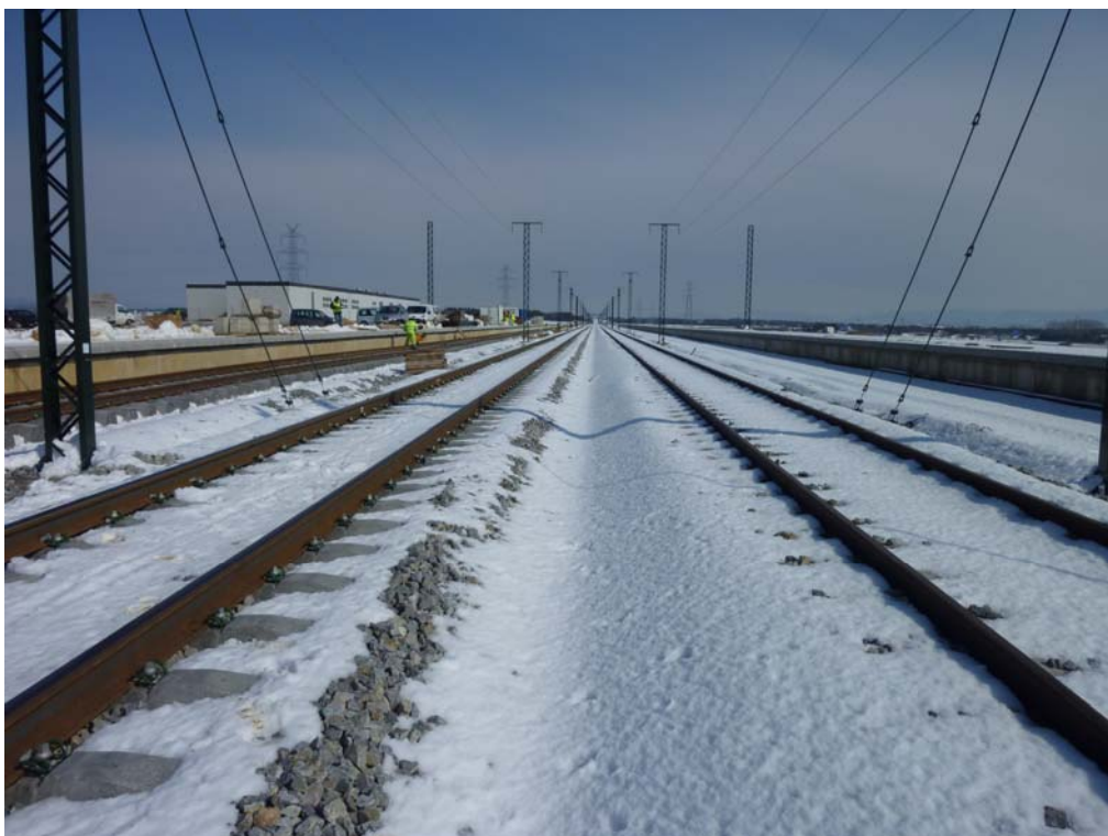
Fotografía 363: Vista desde el estribo de entrada
