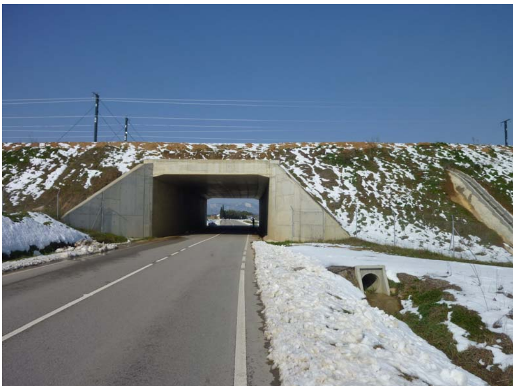
Fotografía 349: Vista alzado derecho
