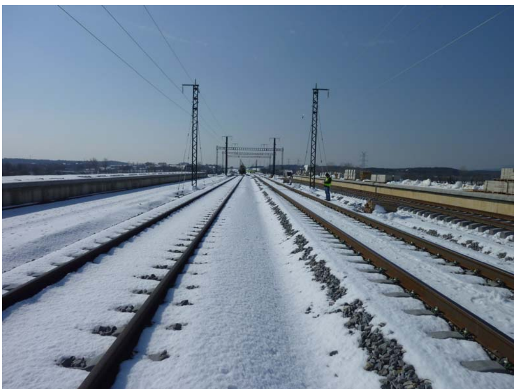
Fotografía 368: Vista desde el estribo de salida
