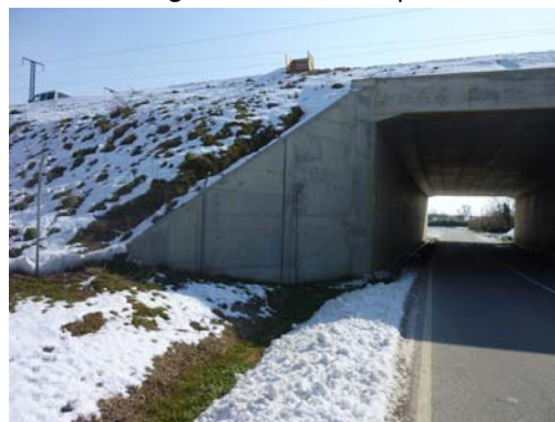
Fotografía nº 6. Estribo de salida
