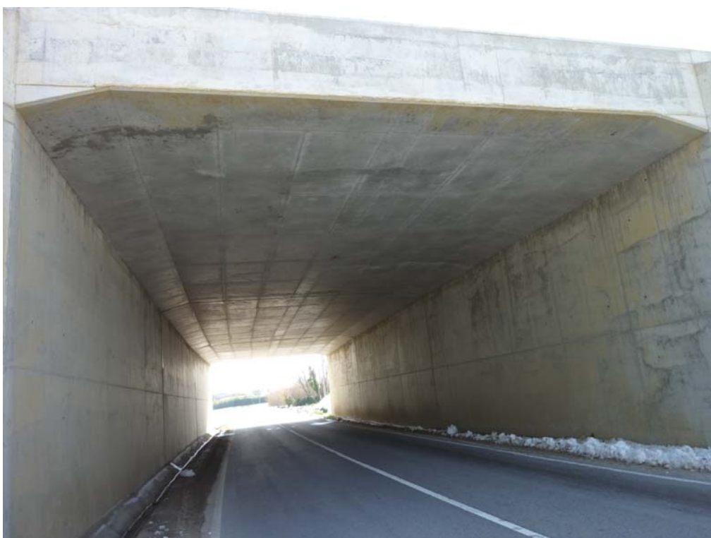
Fotografía 348: Vista losa inferior
