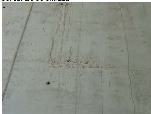
Fotografía nº 9. Nido de grava en el hastial de salida
