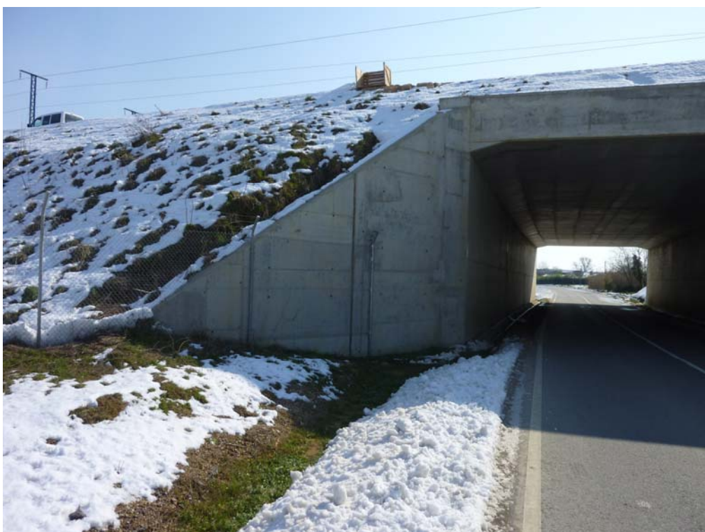
Fotografía 347: Vista estribo de salida
