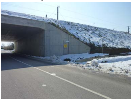
Fotografía nº 5. Estribo de entrada
