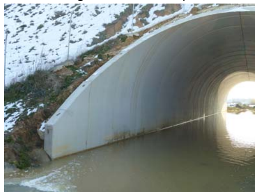
Fotografía nº 6. Estribo de salida
