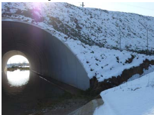
Fotografía nº 5. Estribo de entrada
