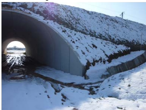
Fotografía nº 5. Estribo de entrada
