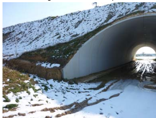
Fotografía nº 6. Estribo de salida
