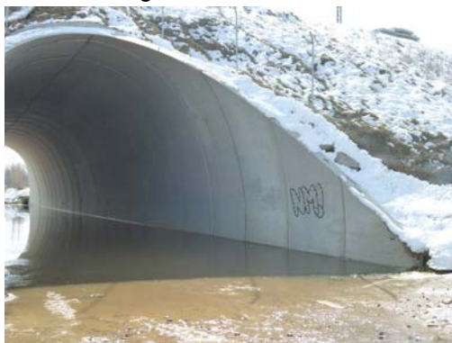
Fotografía nº 5. Estribo de entrada
