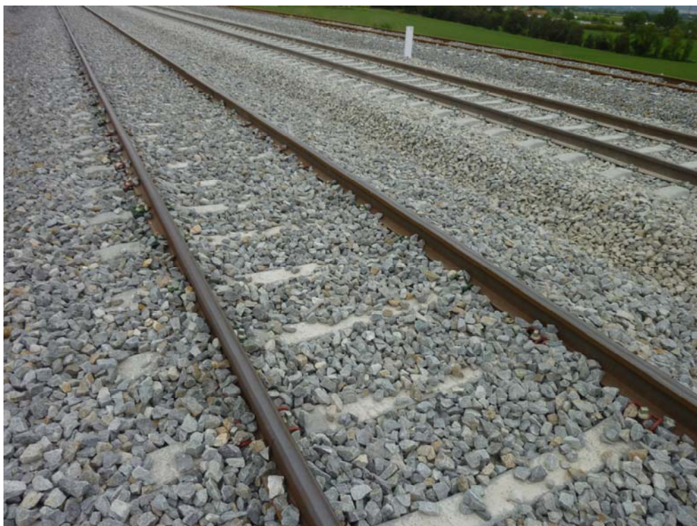
Material de vía
