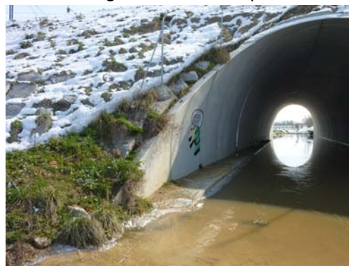
Fotografía nº 6. Estribo de salida
