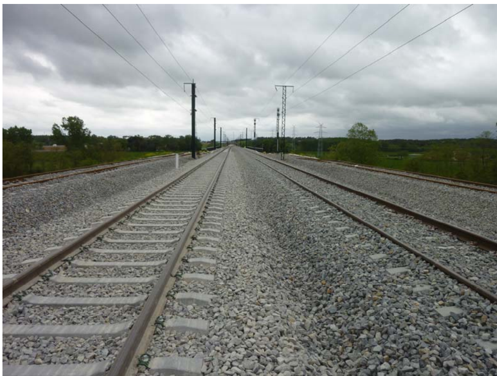
Vista desde el estribo de salida hacia el estribo de entrada
