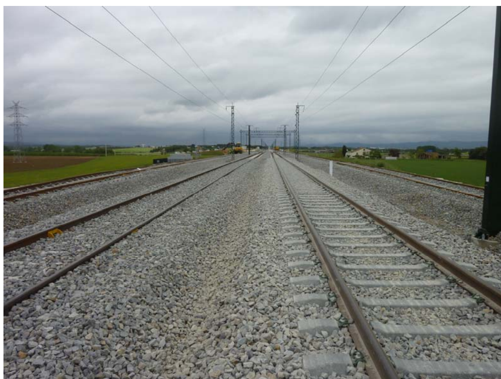
Vista desde el estribo de entrada hacia el estribo de salida
