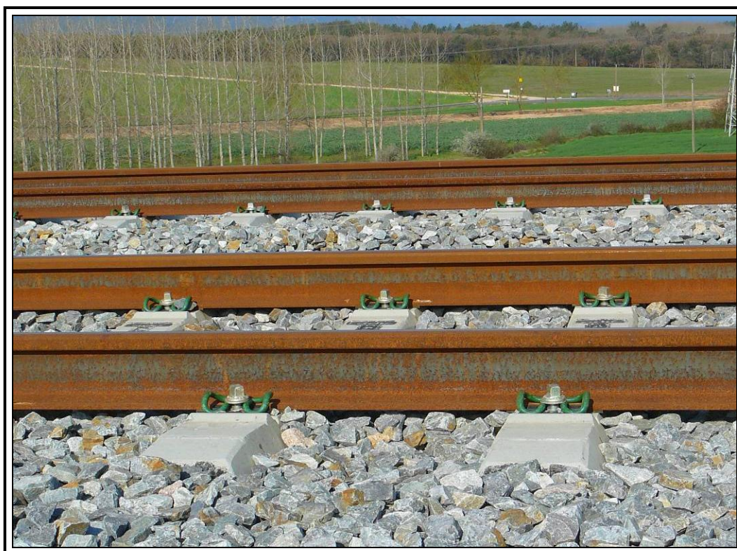
Material de vía.
