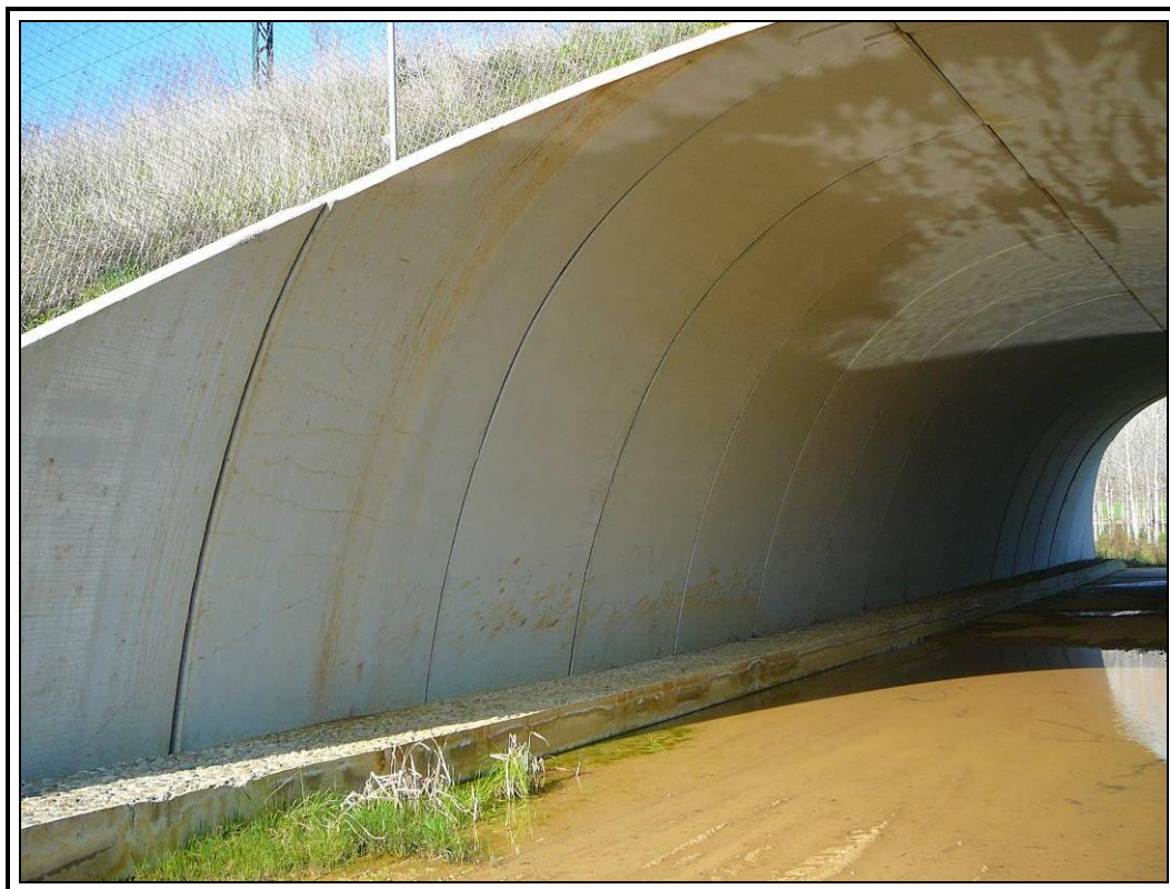
Estribo de entrada.
