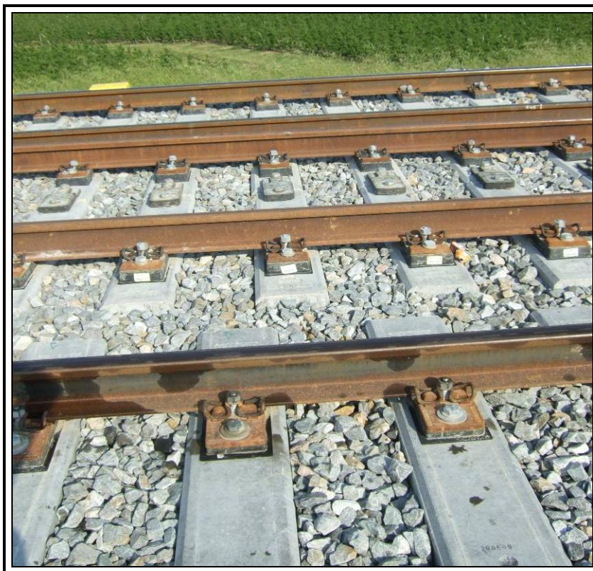
Material de vía.
