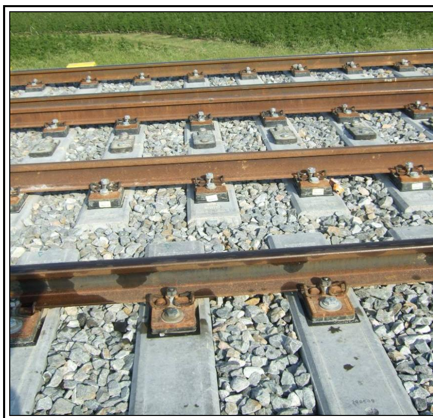
Material de vía.
