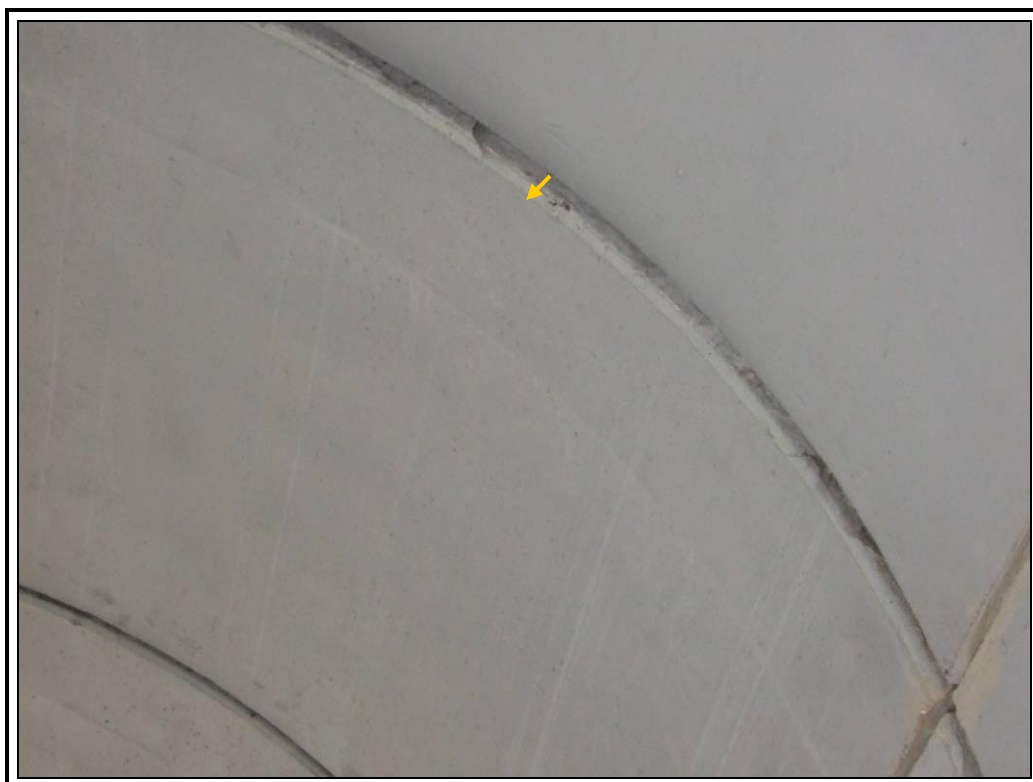
Dovela desplazada de su posición original
