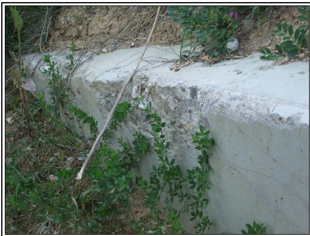
Desconchón en extremo izquierdo del pico de flauta alzado izquierdo
