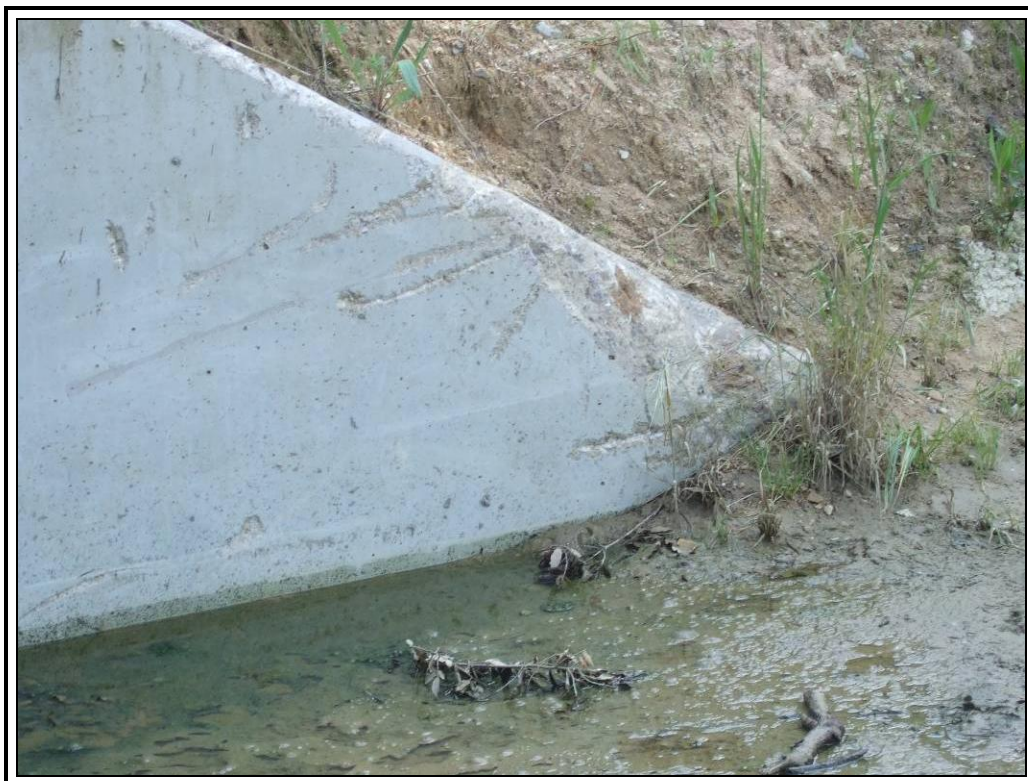
Desconchón en extremo derecho del pico de flauta alzado izquierdo
