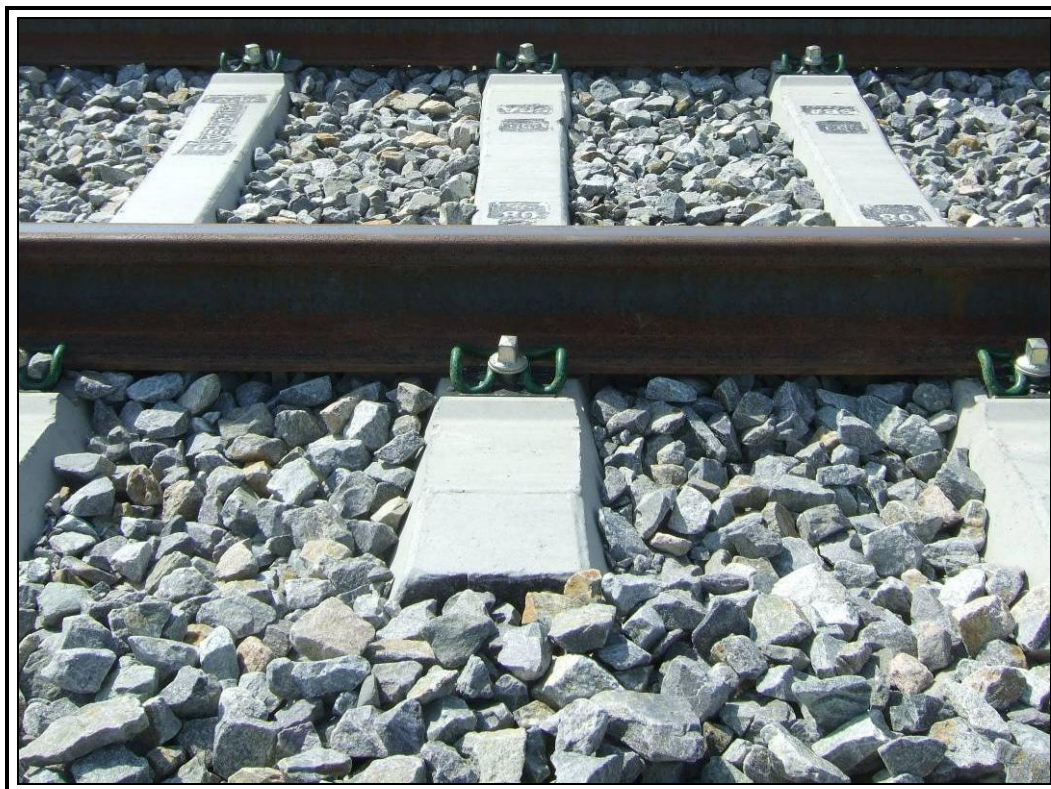
Material de vía.
