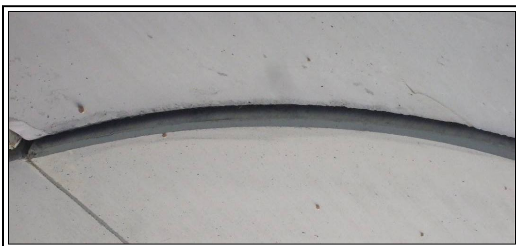
Detalle del desplazamiento entre el 2º y el tercer elemento en el lado derecho.
