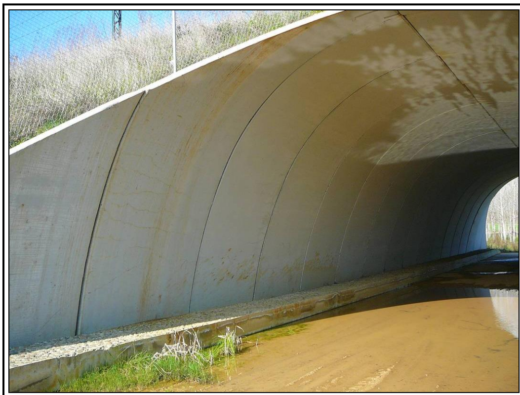
Estribo de entrada.
