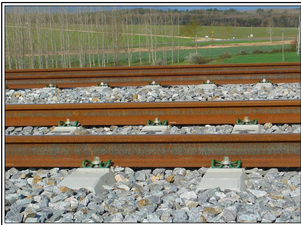
Material de vía.
