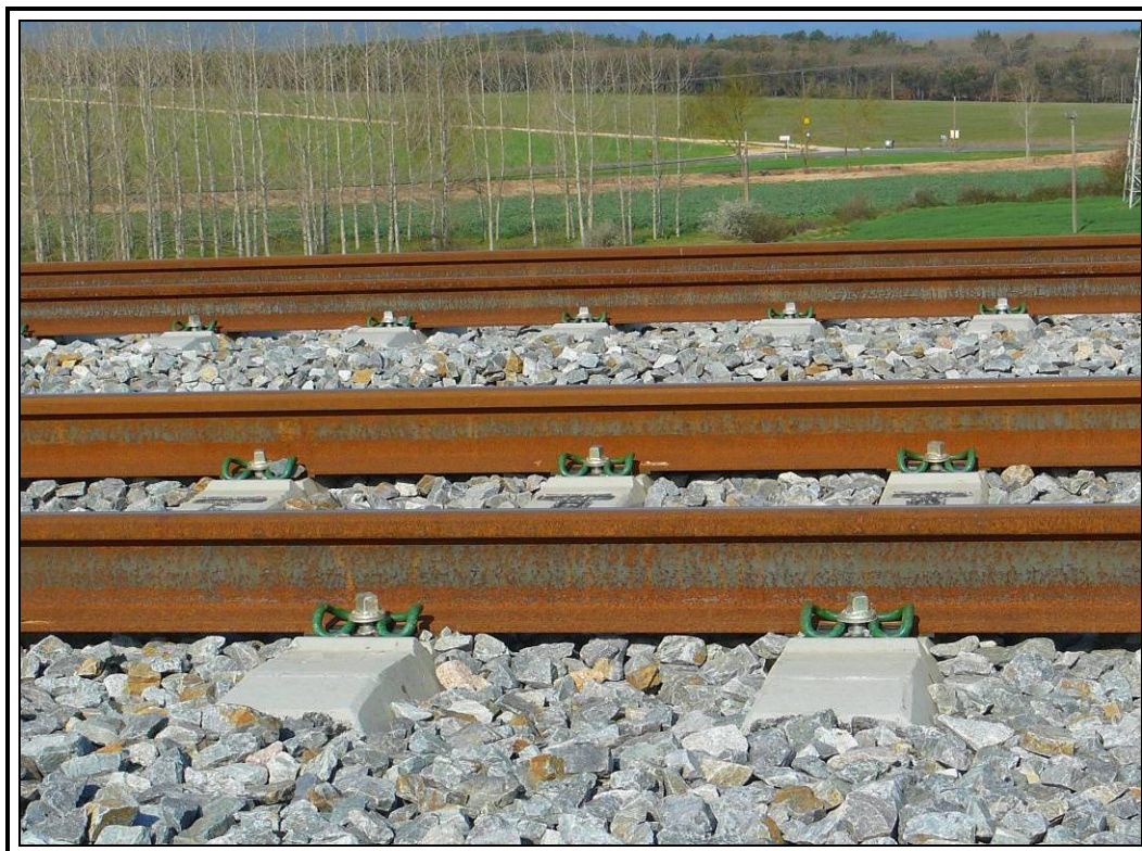
Material de vía.
