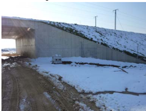
Fotografía nº 5. Estribo de entrada
