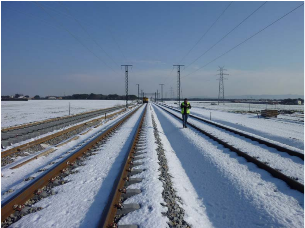
Fotografía 305: Vista superior desde el estribo de entrada
