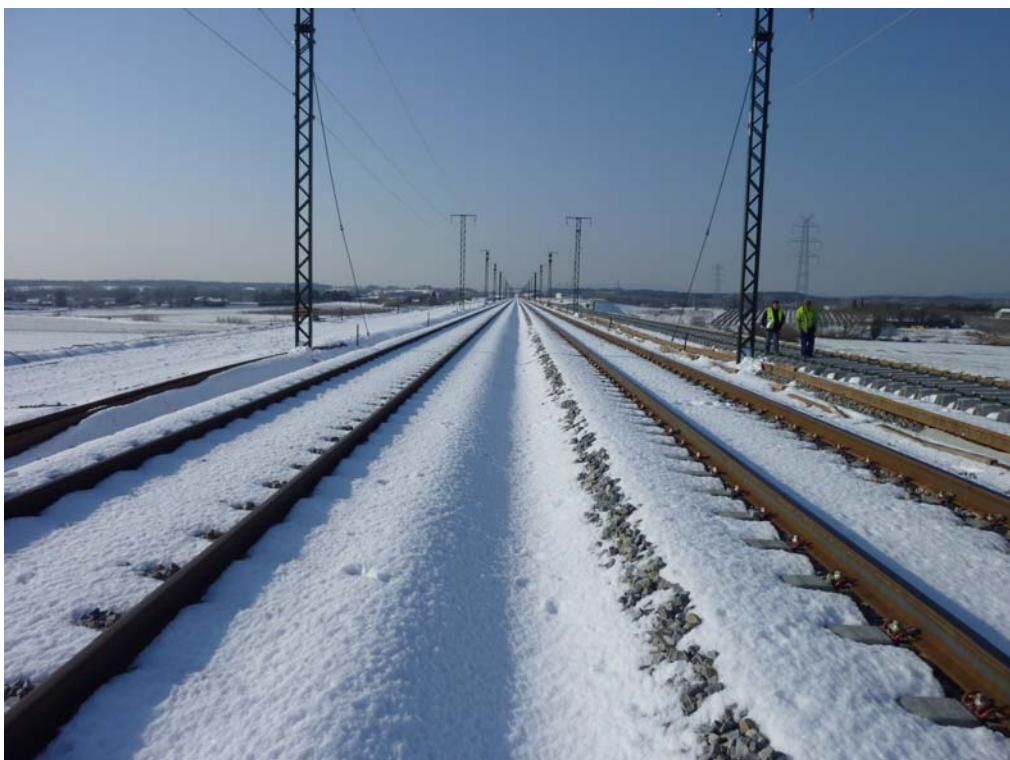
Fotografía 310: Vista desde el estribo de salida
