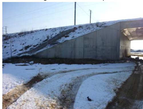
Fotografía nº 6. Estribo de salida
