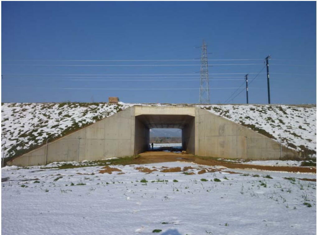
Fotografía 289: Vista del alzado derecho
