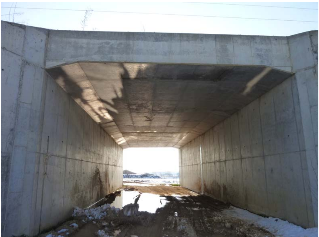
Fotografía 288: Vista inferior de la losa
