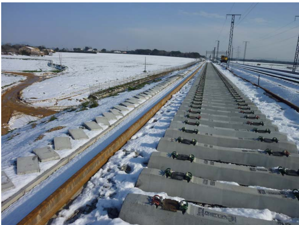
Fotografía 307: Vista del lado izquierdo de la plataforma
