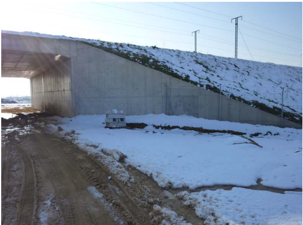
Fotografía 286: Vista del estribo de entrada
