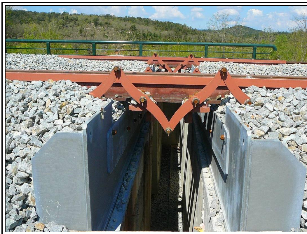
Aparato de dilatación en estribo 2.
