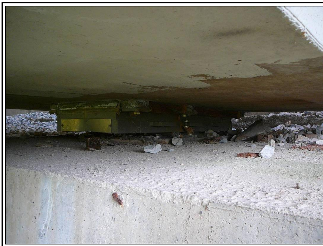
Apoyo derecho estribo 2
