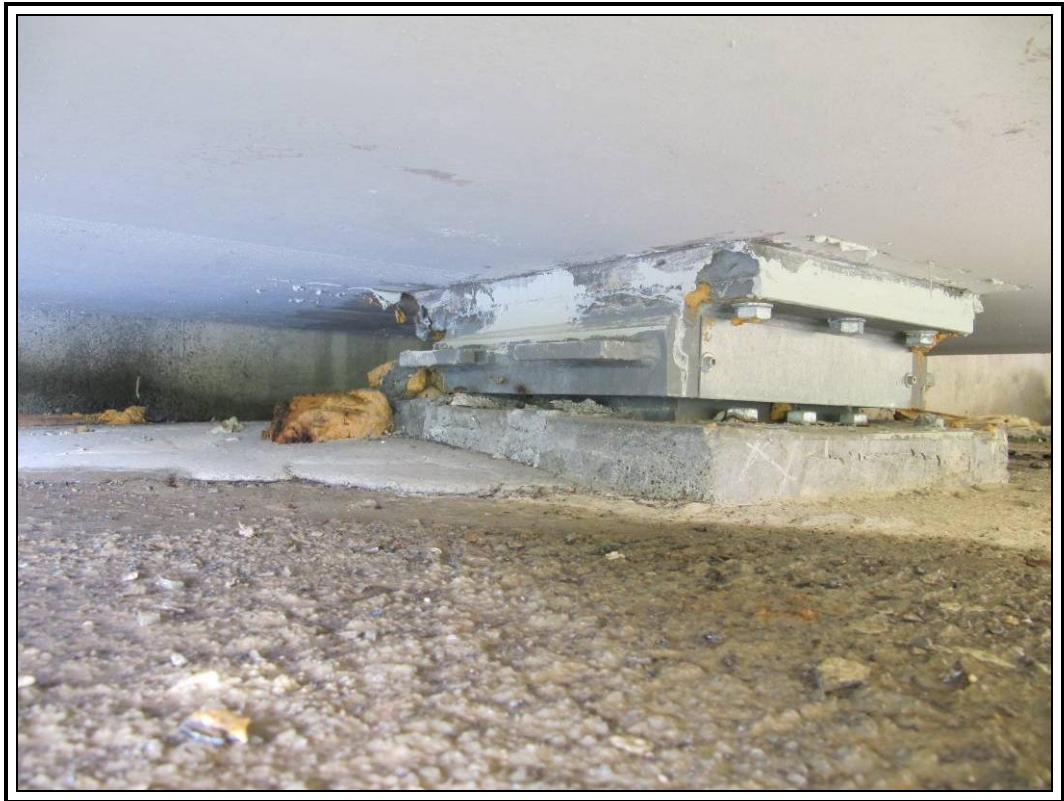
Apoyo izquierdo de estribo uno
