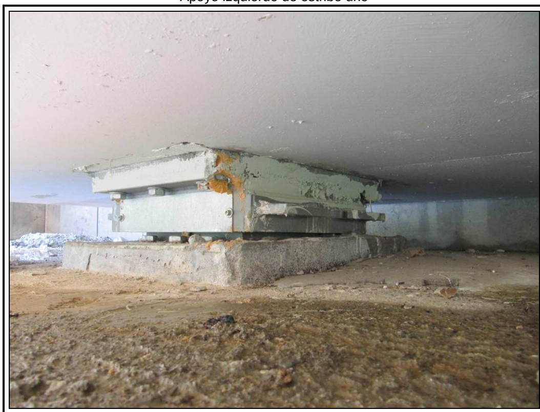
Apoyo derecho de estribo uno
