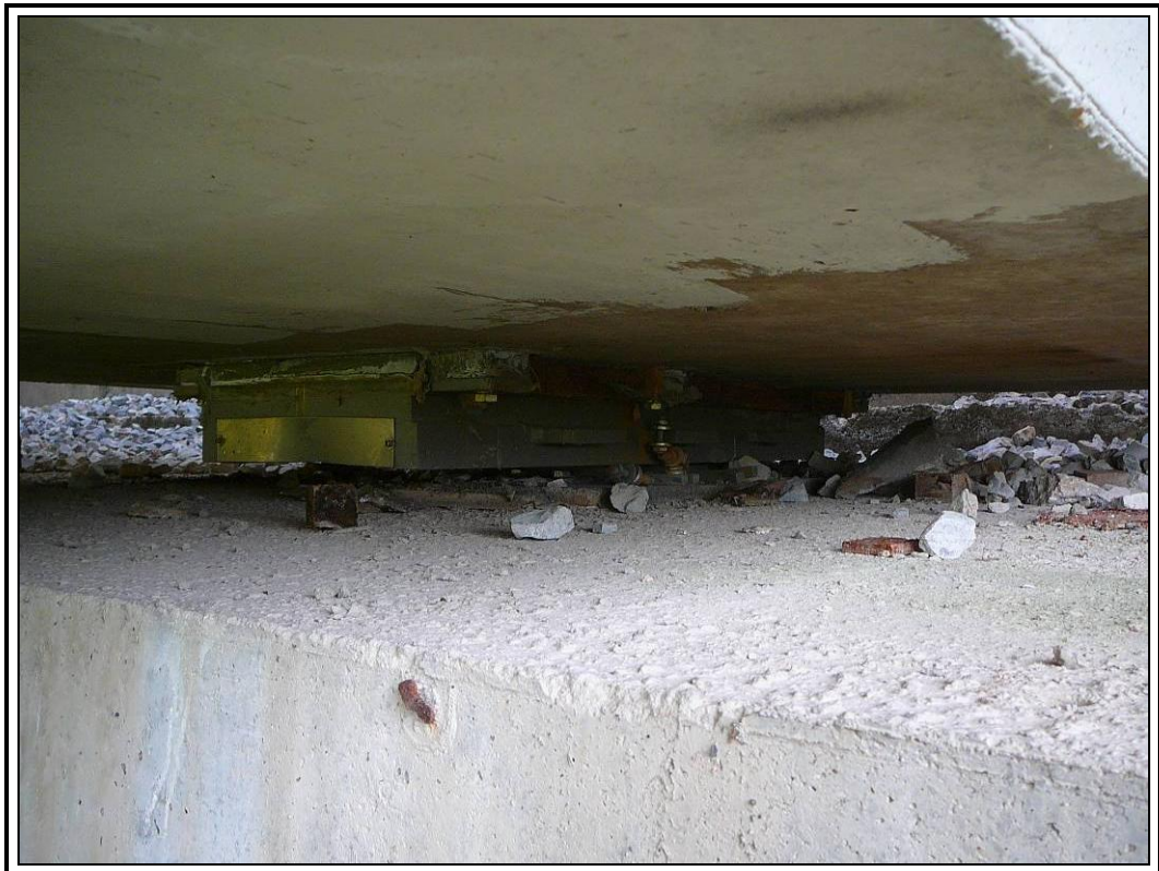
Apoyo derecho estribo 2
