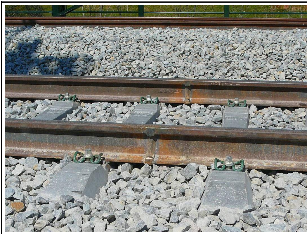
Material de vía
