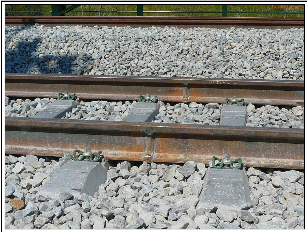
Material de vía
