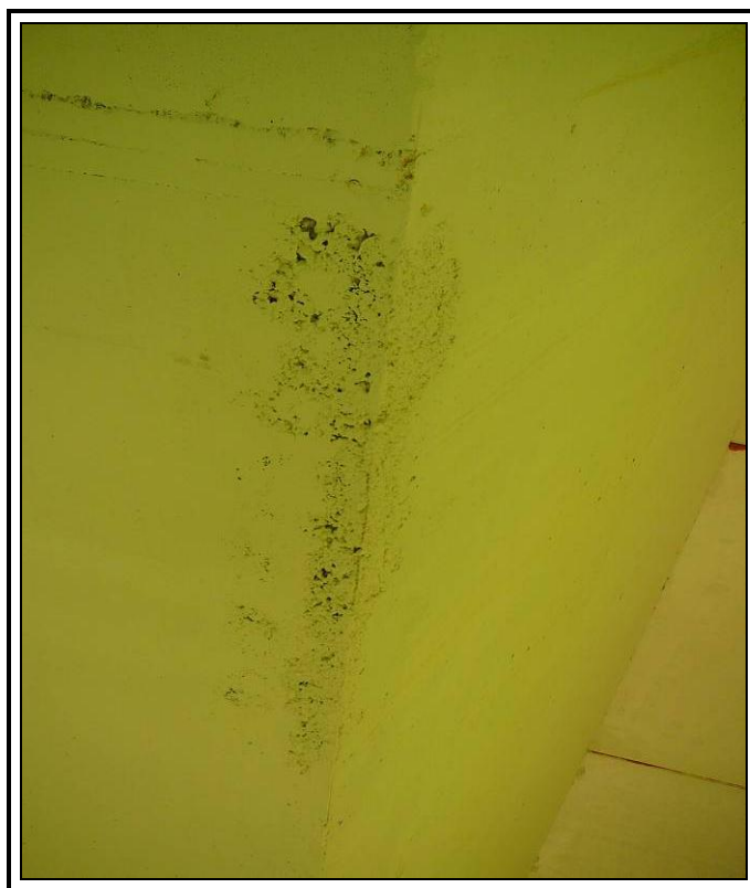
Nido de grava en vano 5 viga izquierda.
