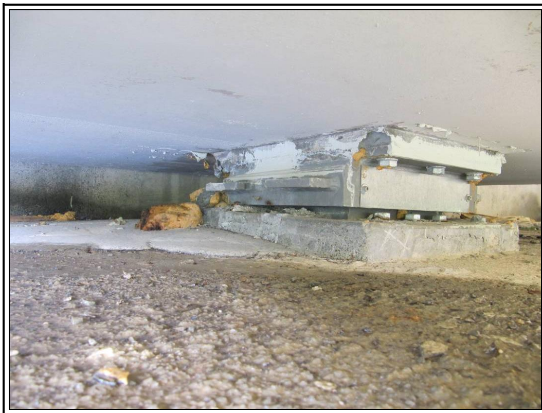
Apoyo izquierdo de estribo uno
