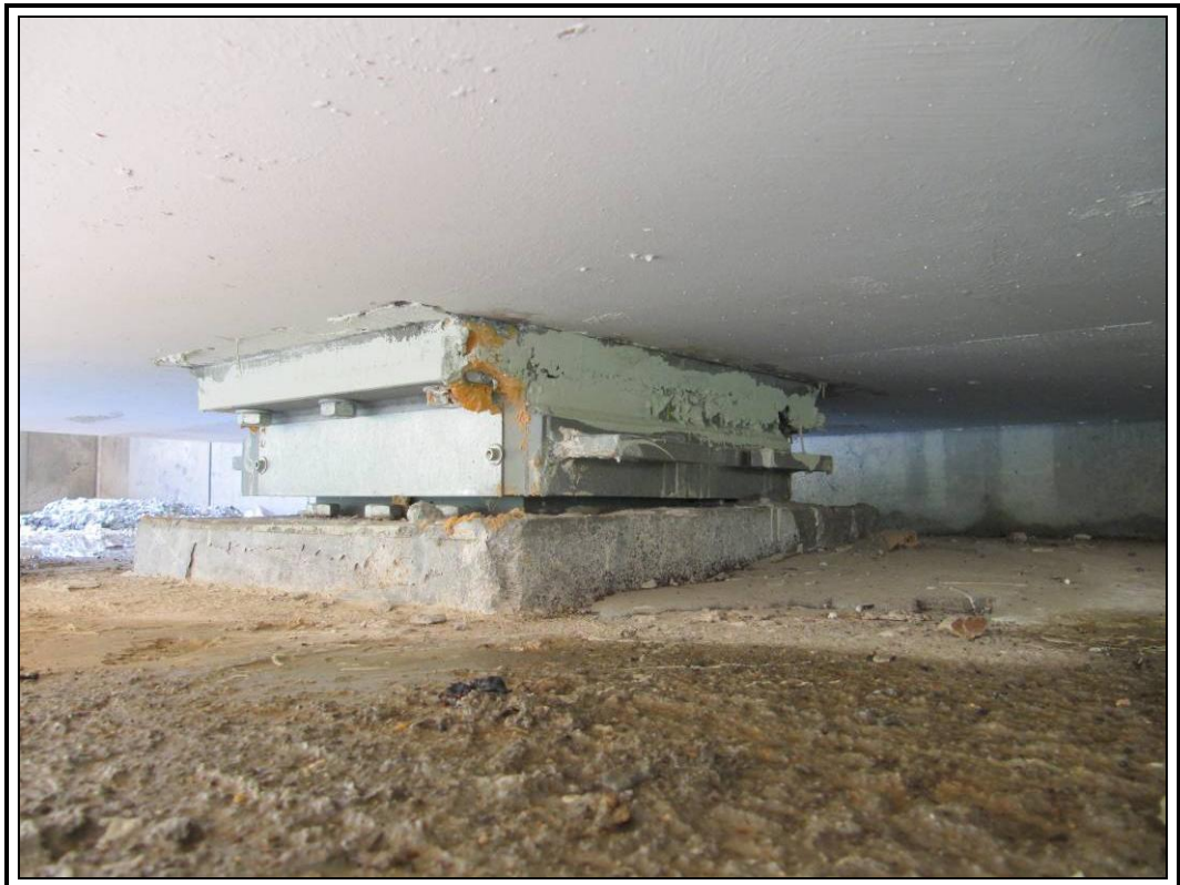
Apoyo derecho de estribo uno
