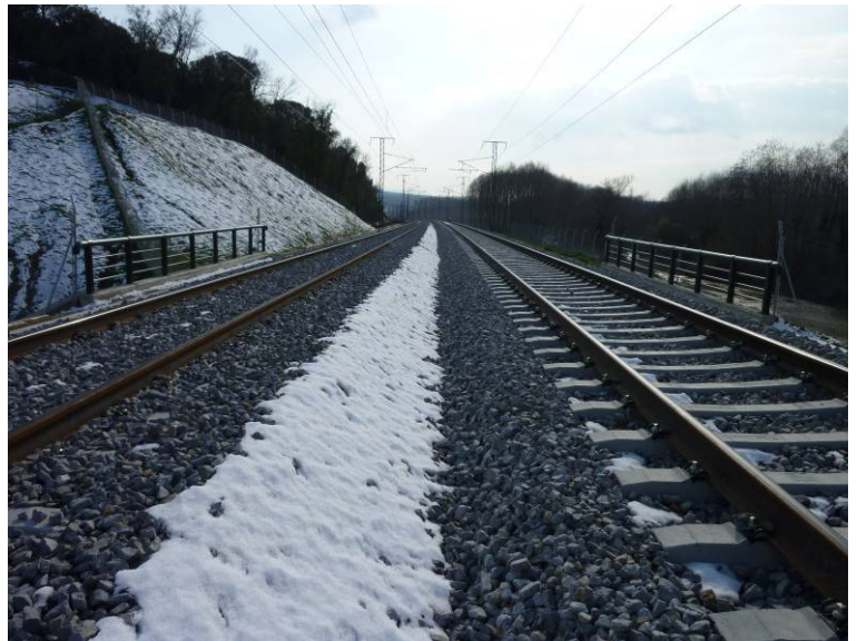
Fotografía N°7: Vista desde el estribo 2.
