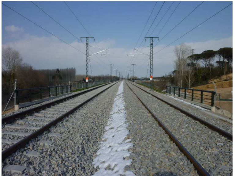
Fotografía N°6: Vista desde el estribo 1.
