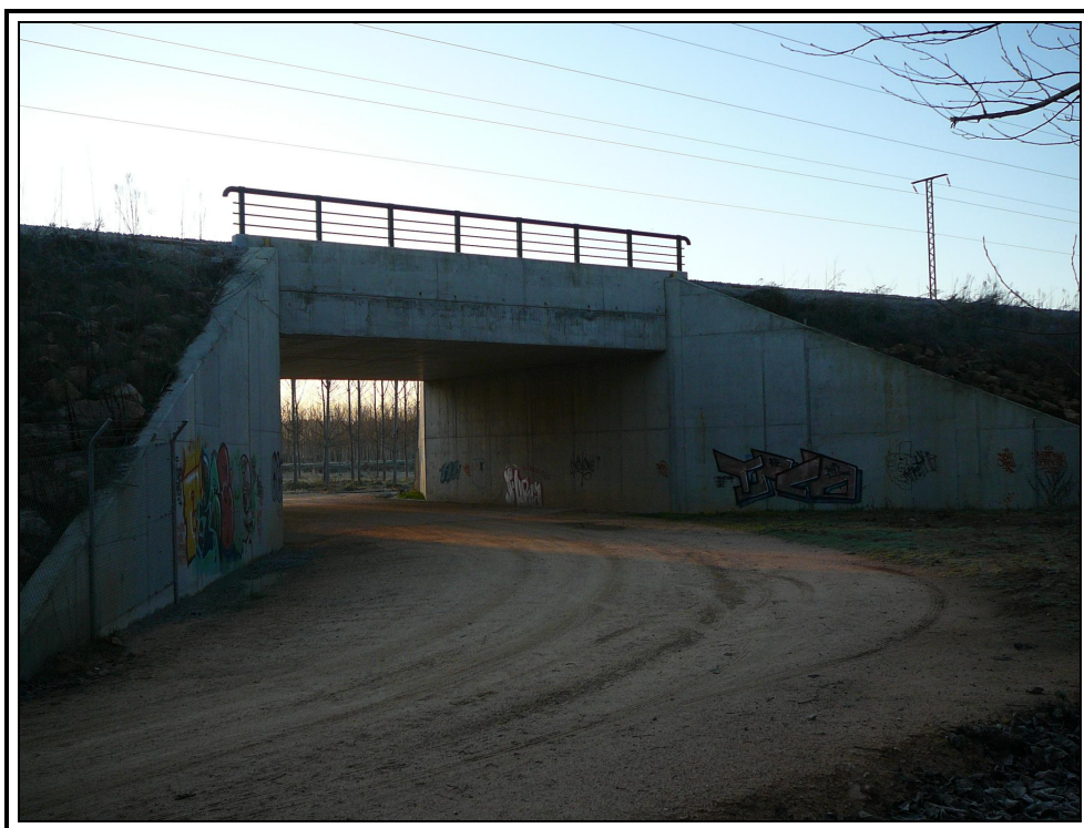
Nº 2.- Alzado izquierdo de la estructura.
