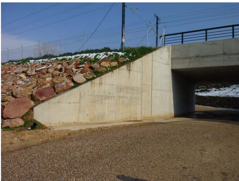
Fotografía 441: Vista del estribo de salida
