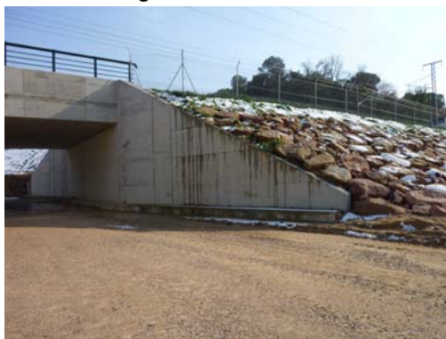
Fotografía nº 5. Estribo de entrada
