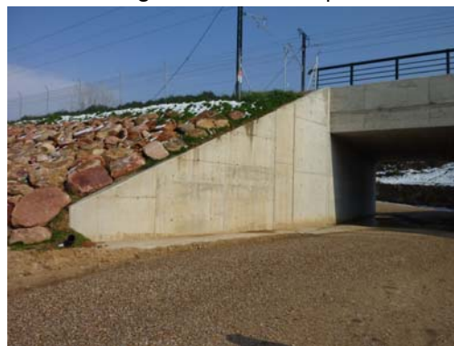
Fotografía nº 6. Estribo de salida
