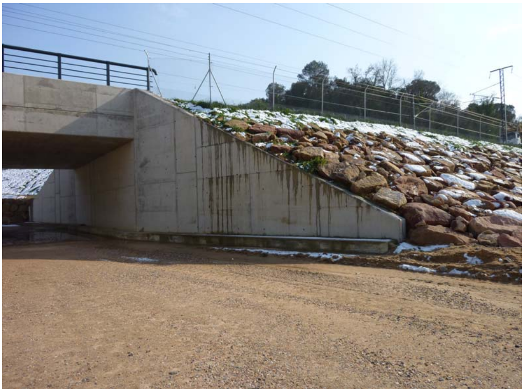
Fotografía 440: Vista del estribo de entrada
