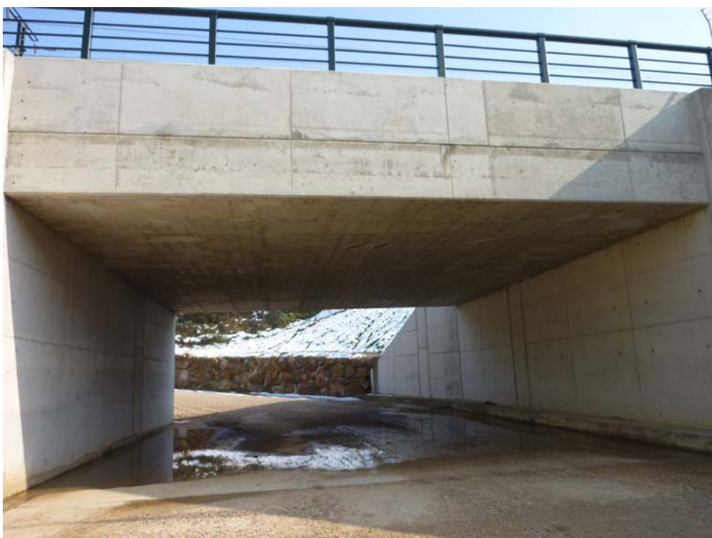
Fotografía 442: Vista inferior de la losa superior
