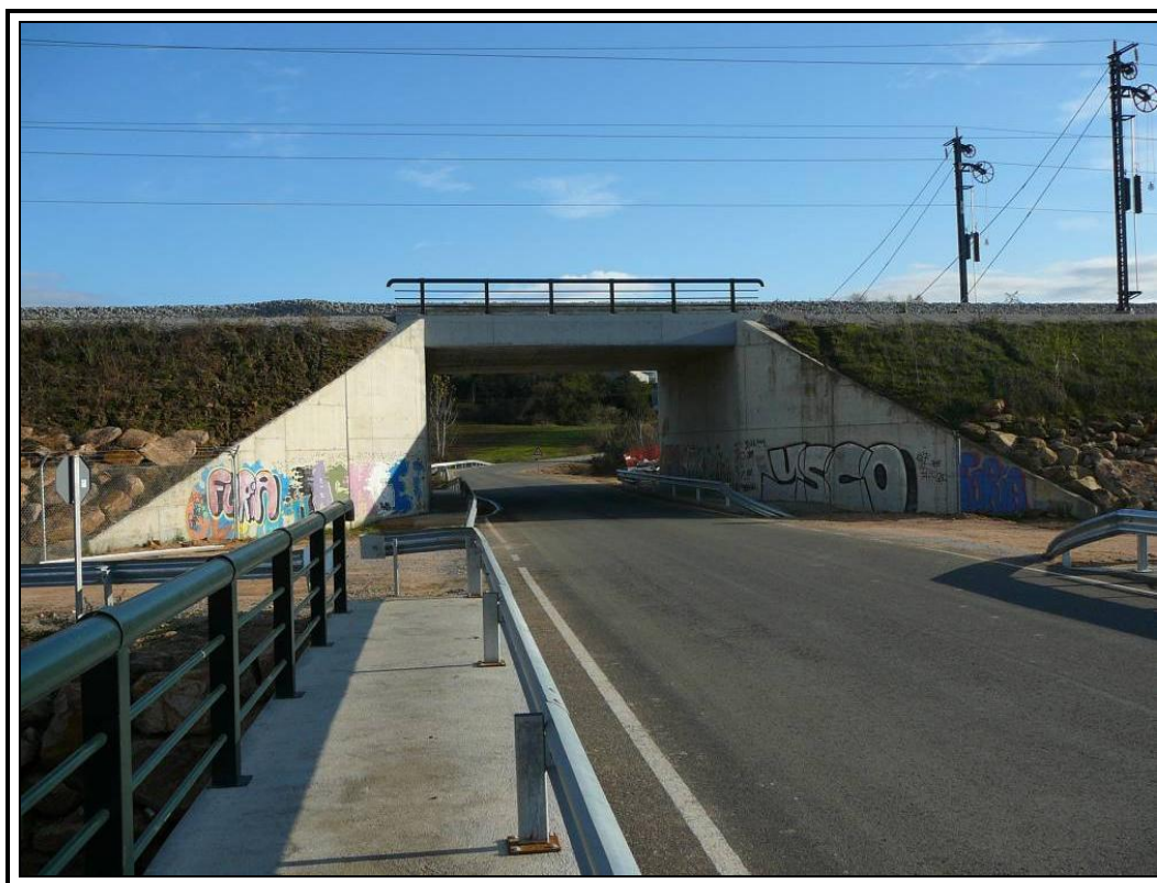
Nº 2.- Alzado izquierdo de la estructura.
