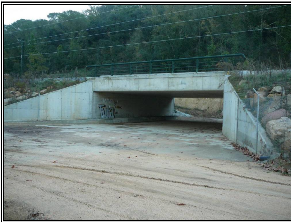
Nº 2.- Alzado izquierdo de la estructura.
