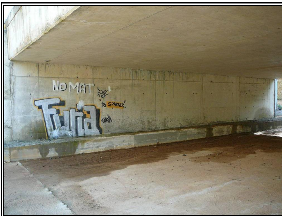
Nº 4.-Hastial izquierdo y vista inferior de la estructura.
