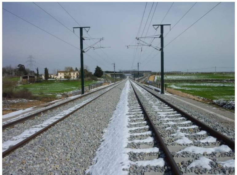
Fotografía N°6: Vista superior desde el estribo de entrada.
