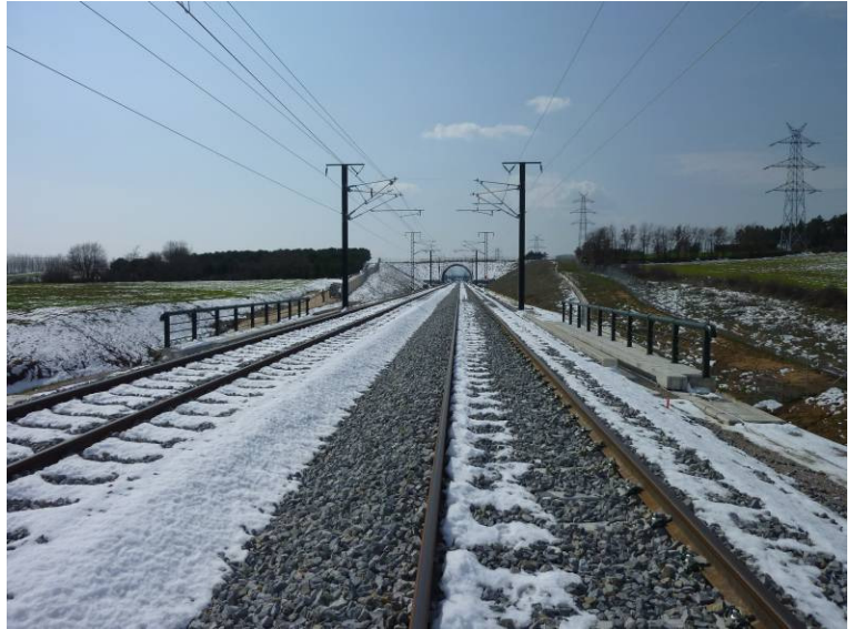
Fotografía N°7: Vista superior desde el estribo de salida.
