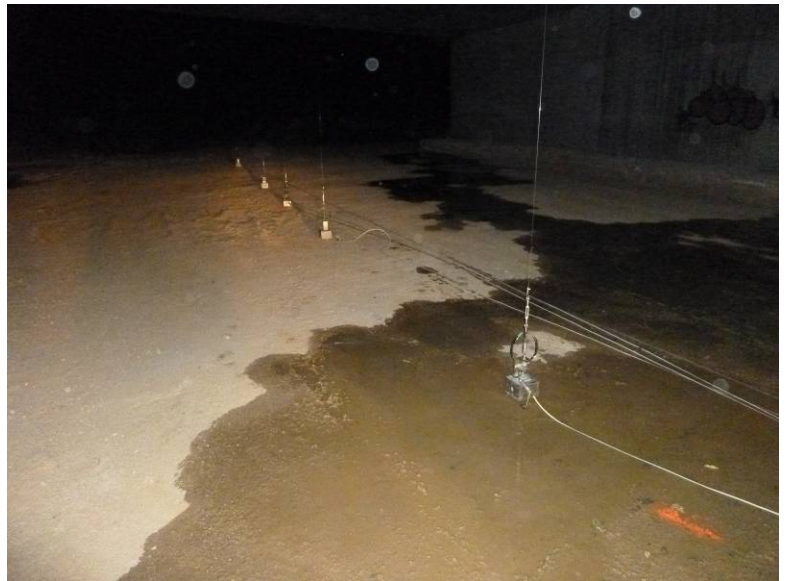
Fotografía N°1: Anillos en centro de vano.
