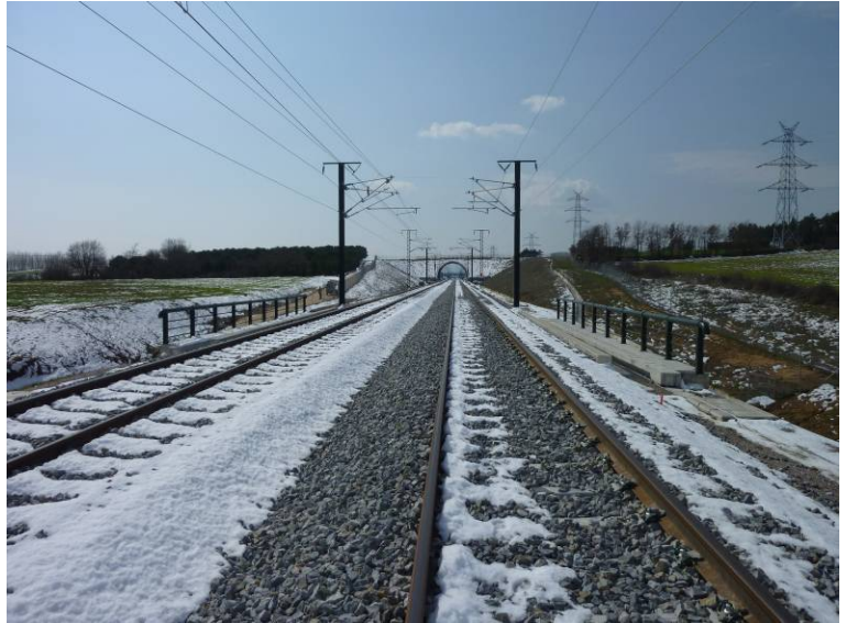
Fotografía N°7: Vista superior desde el estribo de salida.
