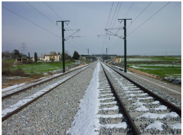
Fotografía N°6: Vista superior desde el estribo de entrada.
