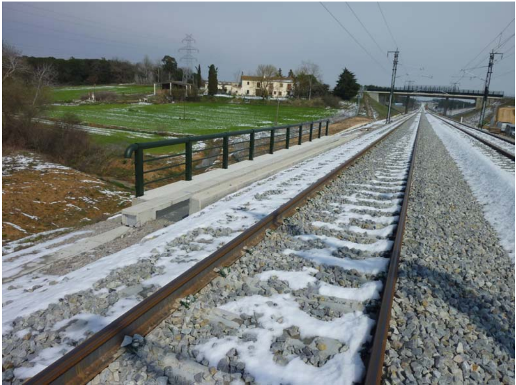
Fotografía 390: Vista del lado izquierdo de la plataforma
