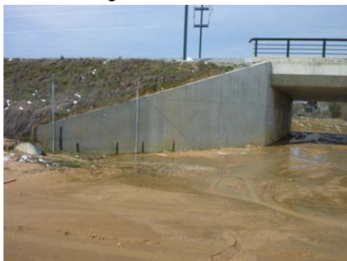
Fotografía nº 5. Estribo de entrada
