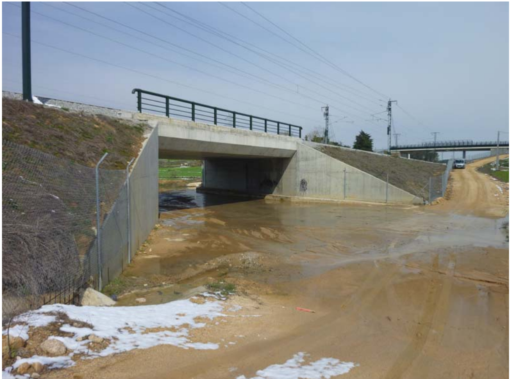
Fotografía 394: Vista del alzado derecho
