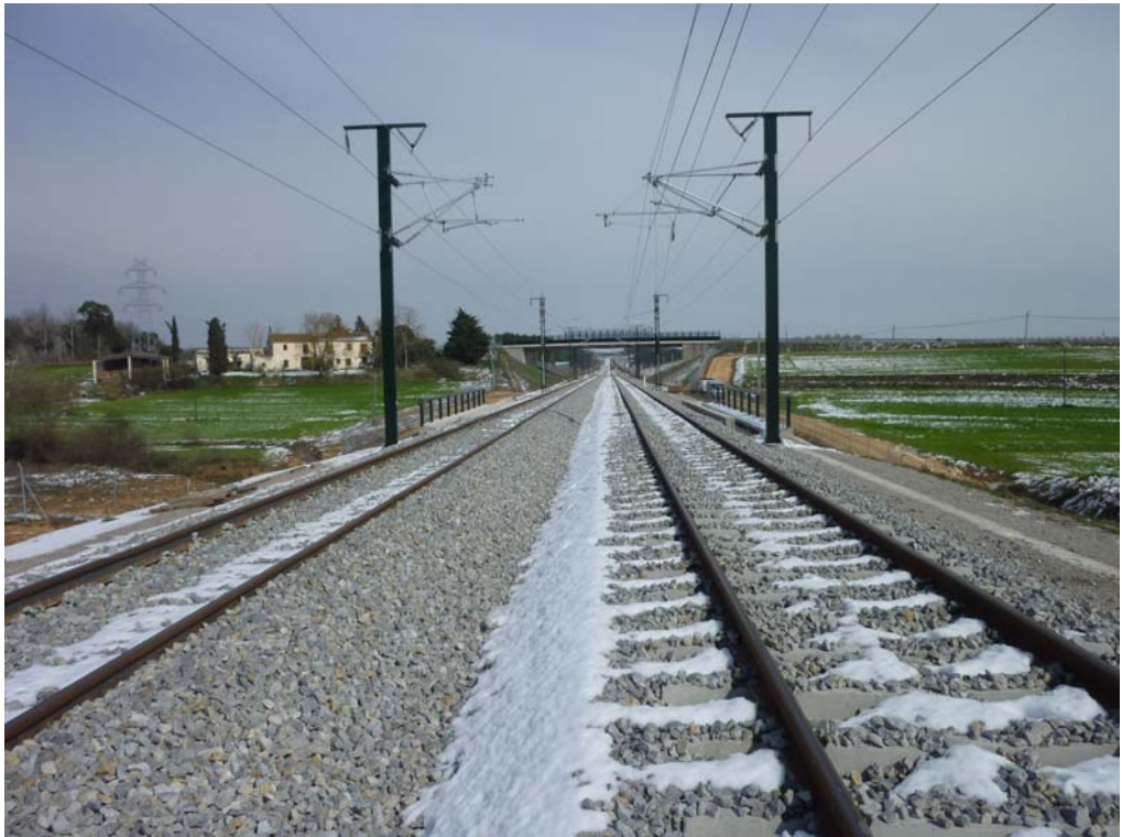
Fotografía 388: Vista superior desde el estribo de entrada
