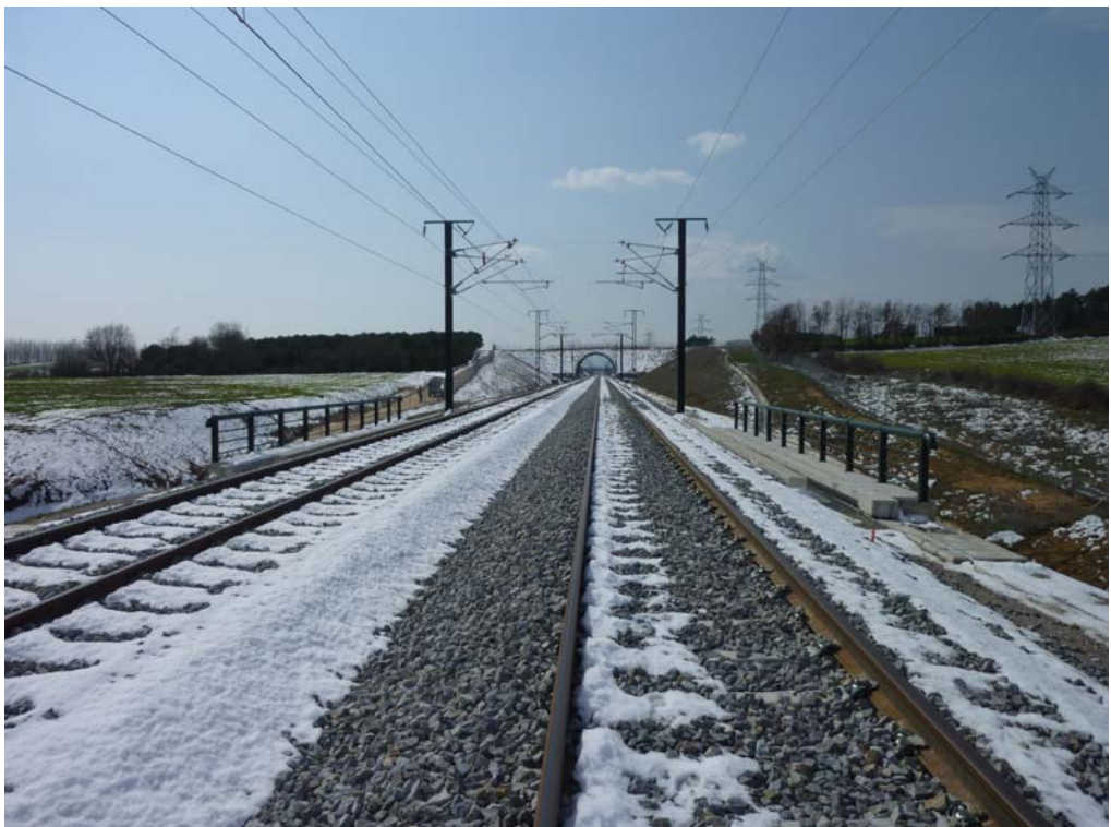
Fotografía 393: Vista superior desde el estribo de salida
