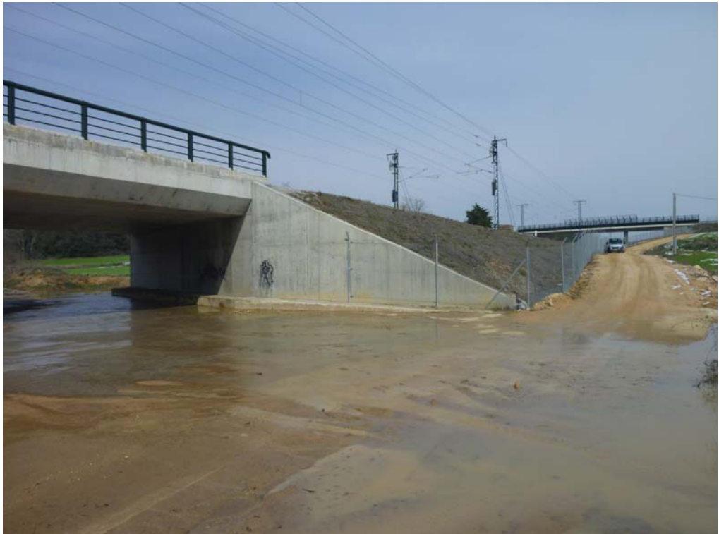
Fotografía 396: Vista del estibo de salida
