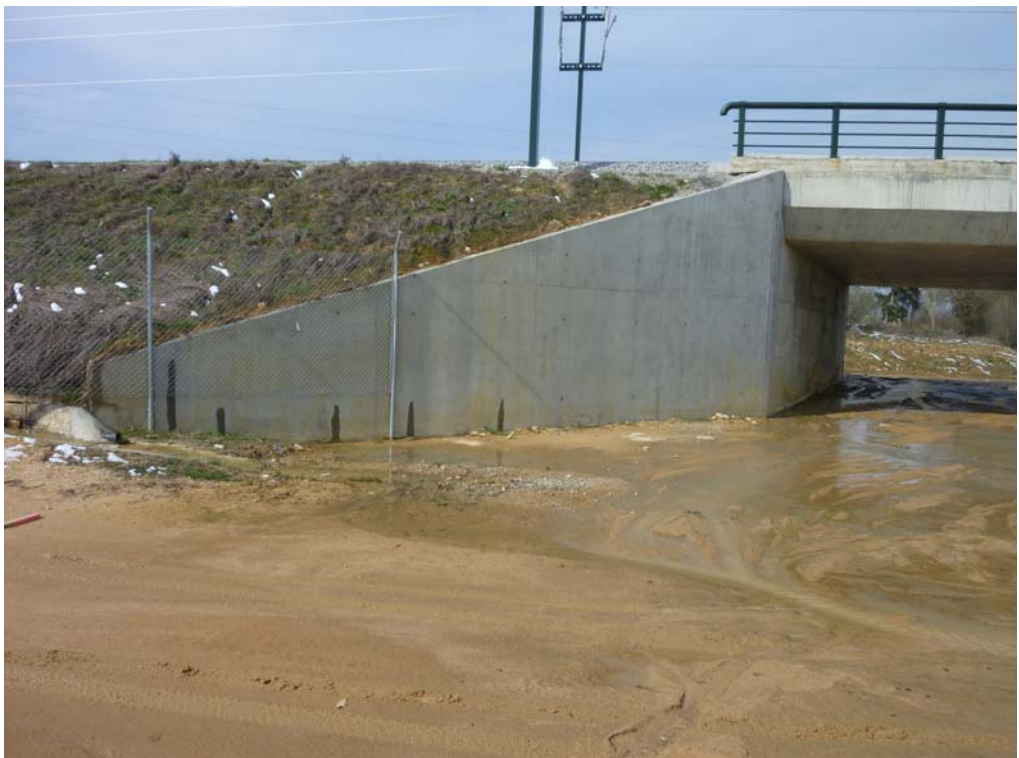
Fotografía 395: Vista del estribo de entrada
