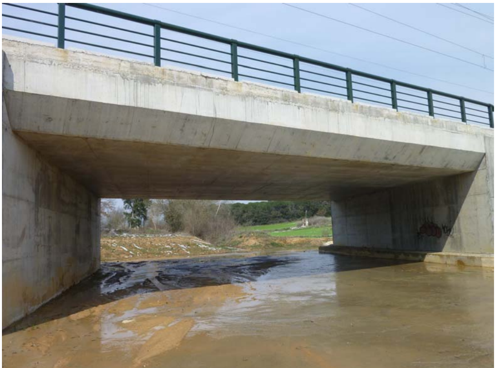
Fotografía 397: vista inferior de la losa superior
