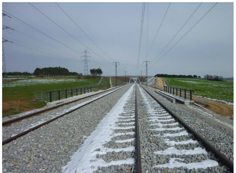
Fotografía N°6: Vista desde el Estribo 1 hacia el Estribo 2.
