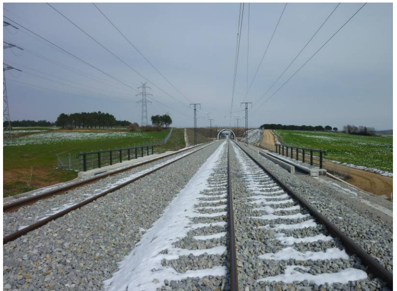
Fotografía N°6: Vista desde el Estribo 1 hacia el Estribo 2.
