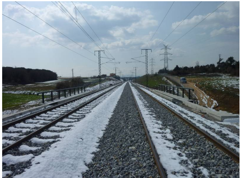
Fotografía N°7: Vista desde el Estribo 2 hacia el Estribo 1.
